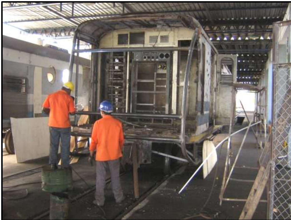
Outro aspecto da construção da nova frente do carro motor do trem húngaro Ganz-Mavag utilizado no Metrô de Teresina-PI.
