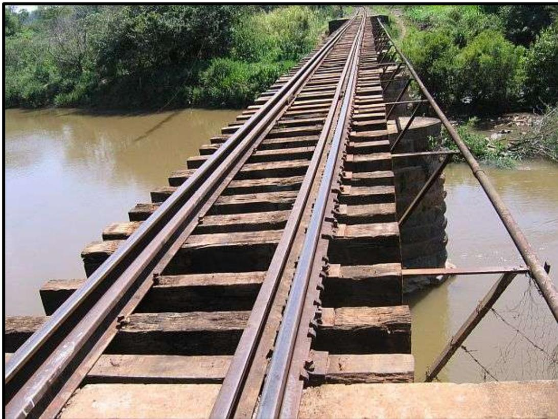
*Ponte da VFCJ sobre o Rio Atibaia, na qual 30% dos dormentes foram substituídos.
