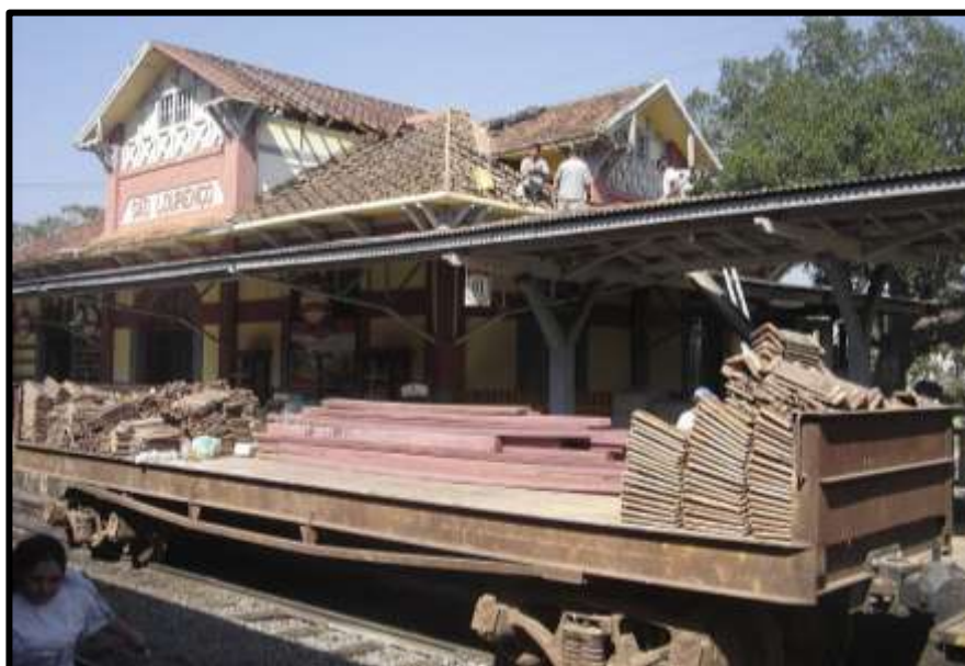
Restauração do telhado da estação de São Lourenço.
