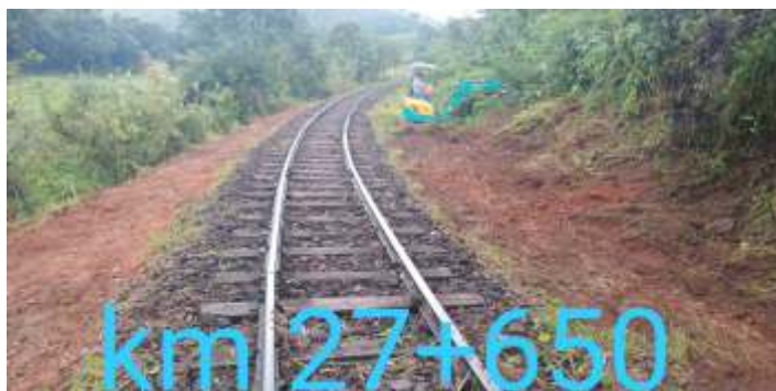
♦ Manutenção na via: serviço de limpeza da faixa de domínio com auxílio de escavadeira no trecho do km 27. Além da limpeza, a escavadeira preparou a plataforma para favorecer a drenagem da água pluvial de maneira que não haja acúmulos de água na área.
