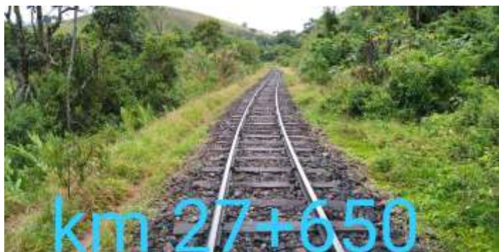
♦ Aspecto da via no trecho do km 27+650 antes dos trabalhos: nessa época de chuvas, principalmente nessa região de serra e de alto índice pluviométrico a vegetação cresce rapidamente, exigindo manutenção constante da equipe.
