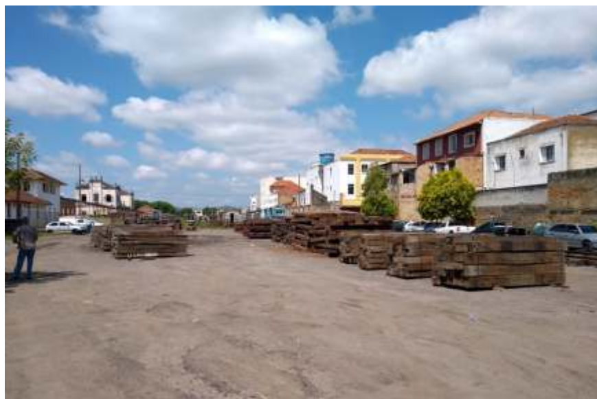
◆ Dormentes sendo organizados na área do pátio, paralelos a linha principal (enterrada a esquerda da foto)
