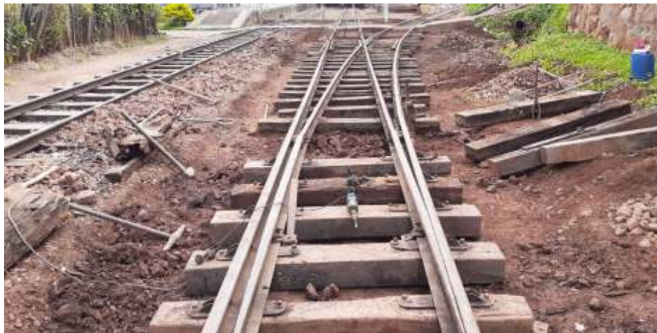
◆ Manutenção nas vias secundários do pátio da estação de São Lourenço: substituição de dormentes e remoção do lastro para descontaminação.
