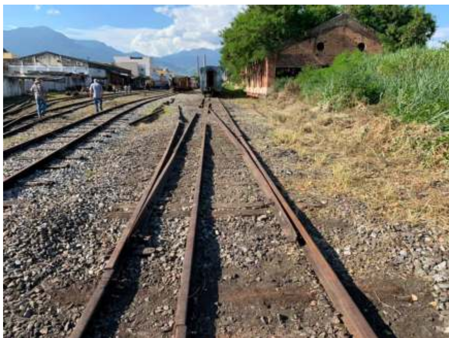
♦ Antes e depois no pátio de Cruzeiro/SP: substituição de dormentes, limpeza e instalação de novo amv para construção de nova linha
