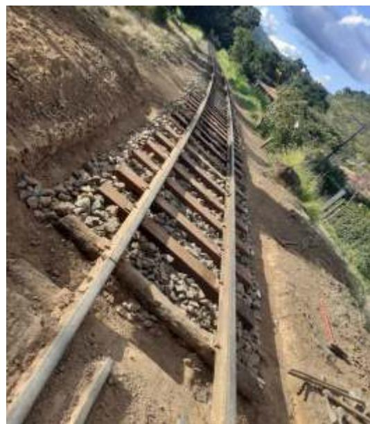
◆ Obras no km 32+050: substituição de dormentes e descontaminação do lastro.
