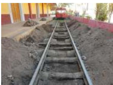
◆ Antes e durante as obras: trecho em frente à estação de Soledade sendo descontaminado; dormentes serão todos substituídos e novo lastro será aplicado.
