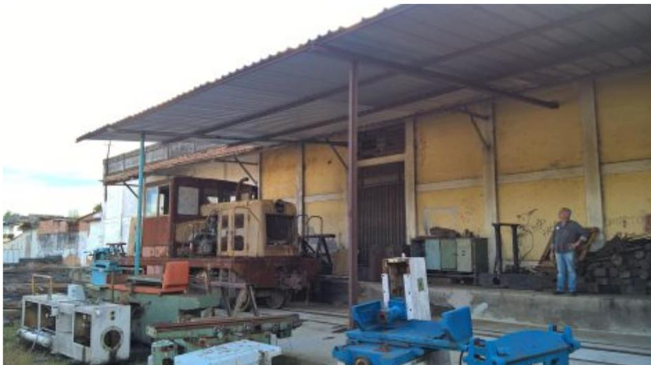
+ Cobertura da área externa da oficina já com a ampliação e piso de concreto
