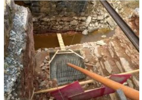
**+ Trabalhos de limpeza e escavação para a confecção de novas sapatas de apoio. Concretagem de uma das sapatas; essa veio a ser a fundação para um novo pilar de concreto armado para apoiar a superestrutura de aço e proteger o caixão de aterro.**
