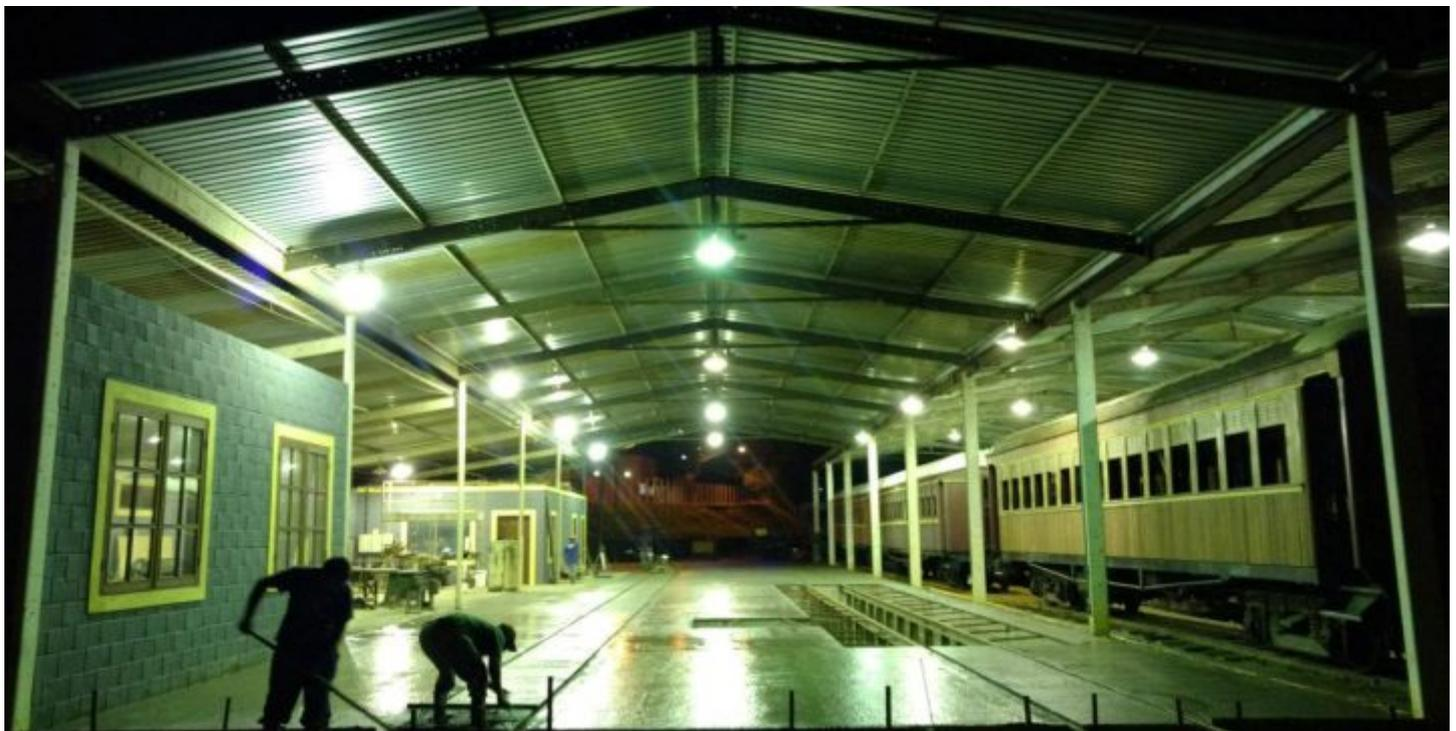
+ O piso sendo concretado: grande melhoria para a reforma e manutenção de material rodante
