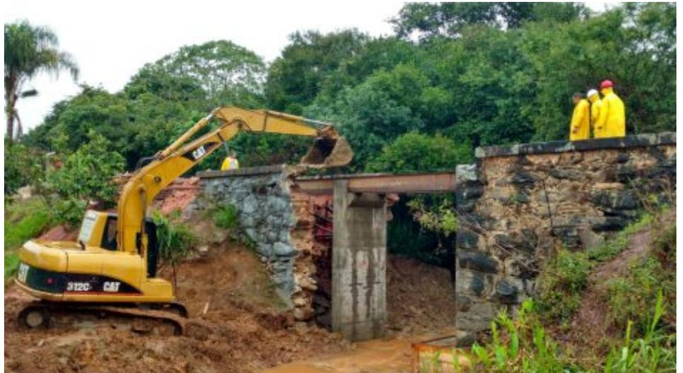
**+ Instalação das novas vigas de aço, maiores e mais robustas do que as antigas; para além, são mais longas, permitindo melhor distribuição da carga no terreno; foram construídas mais duas novas sapatas de concreto armado dentro do caixão de aterro, garantindo melhor apoio e estabilidade para a estrutura.**
