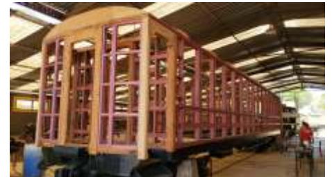
+ A nova estrutura de madeira do carro SD-01 montada, pronta para receber revestimento
