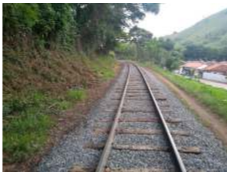
+ Aspecto de trecho após obras
