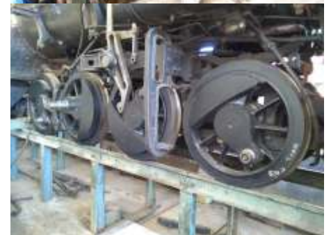
+ As rodas com aros novos já instaladas na locomotiva.
