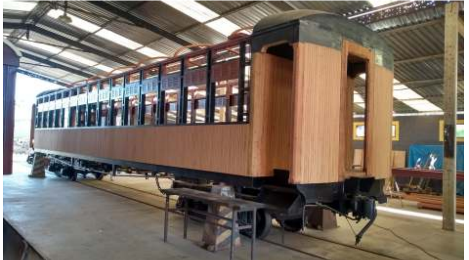
+ O carro SD-01 em reforma nas oficinas de São Lourenço, em dezembro de 2019
