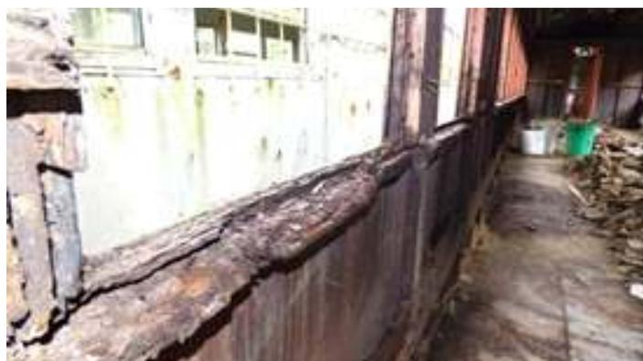
♦ *Retirada do revestimento interno e situação de como se encontrava os beirais das janelas*
