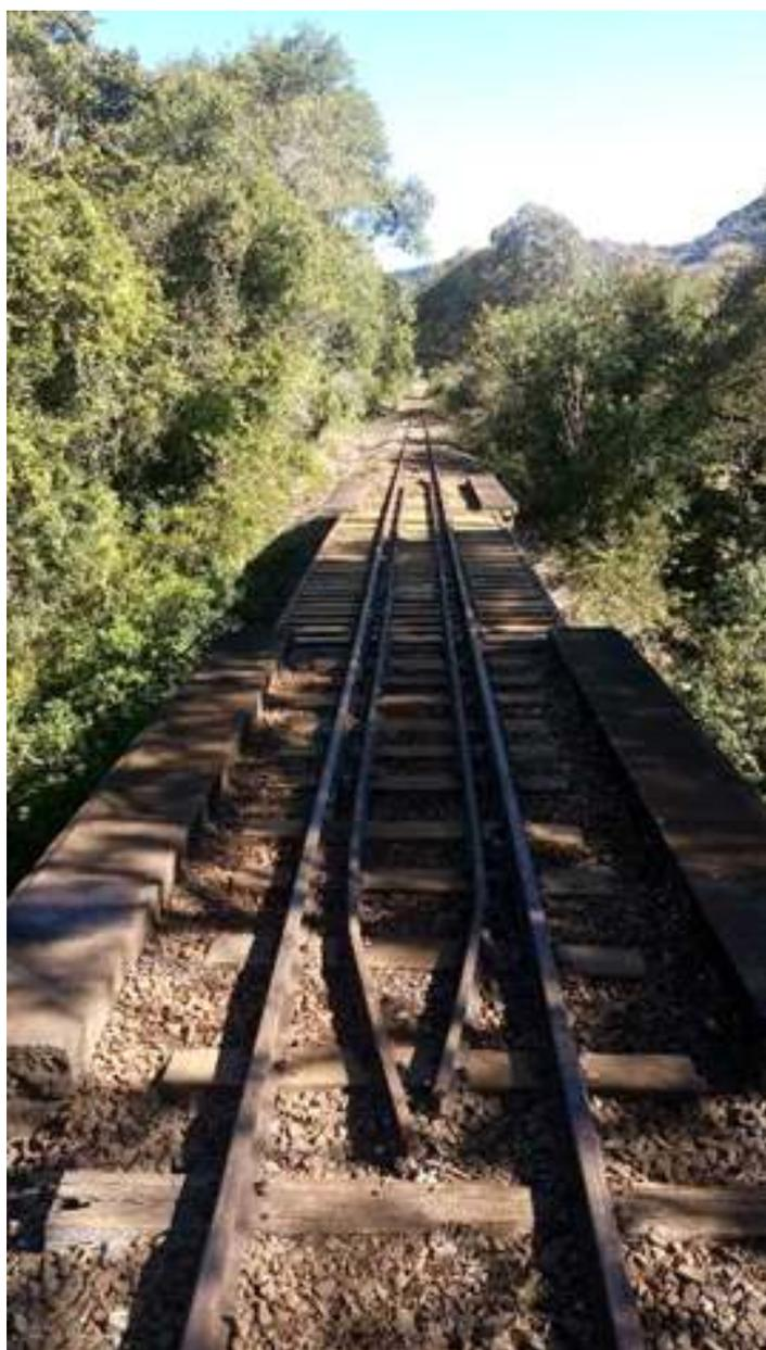
♦ Antes e depois: Substituição dos dormentes de ponte no Km 850,300
