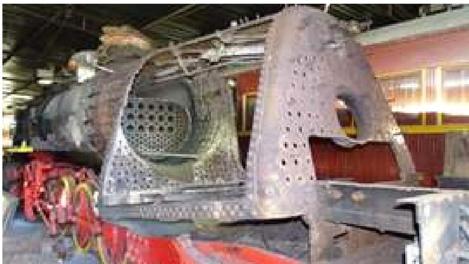
♦ Locomotiva Mikado nº 156 com todas as partes da fornalha que serão substituídas já removidas
