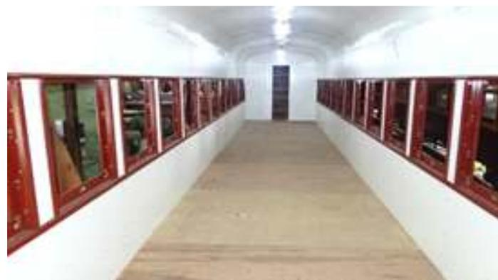
♦ Finalização da instalação do forro e início da instalação das janelas e ripamento já com as travas e fixadores
