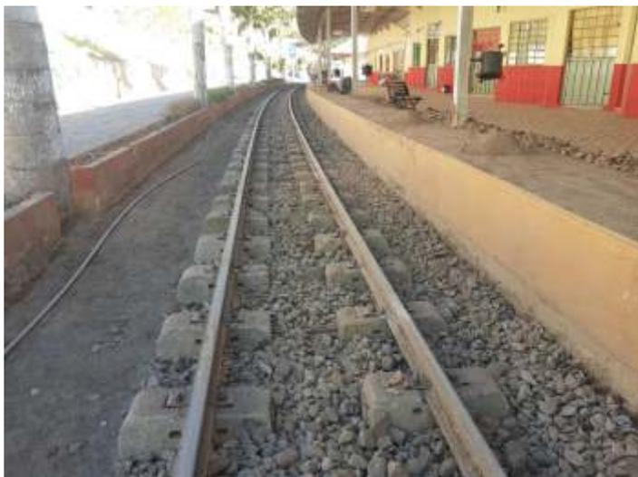
♦ Aspecto do trecho em frente a plataforma de desembarque, já com dormentes bi-bloco de concreto, nivelamento e alinhamento e início de aplicação de lastro
