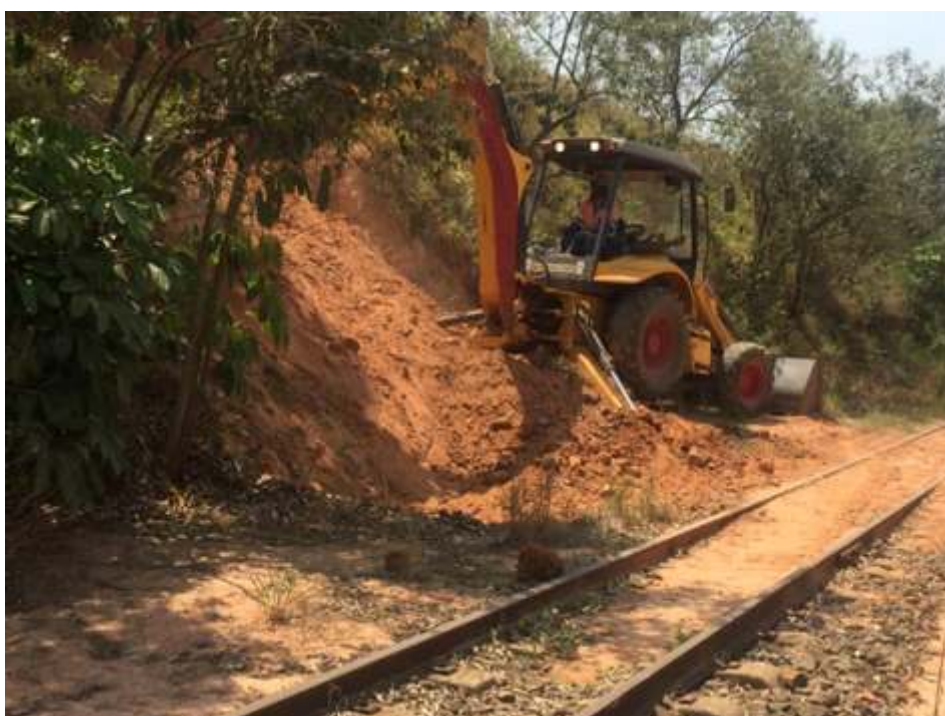
♦ Retroescavadeira retirando terra que caiu sobre a margem da via no início do ano, durante o período chuvoso.
