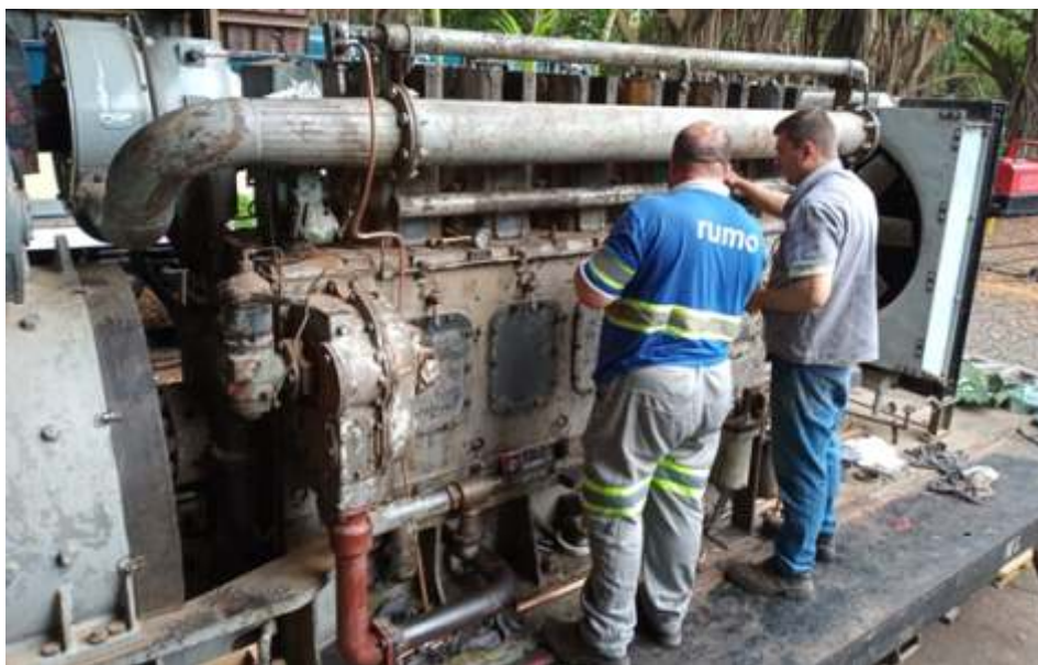
♦ Rodrigo Fernando e Luiz Milani na montagem para funcionar o motor da GE
