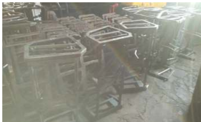
◆ Estruturas dos bancos sendo reparadas nas oficinas
