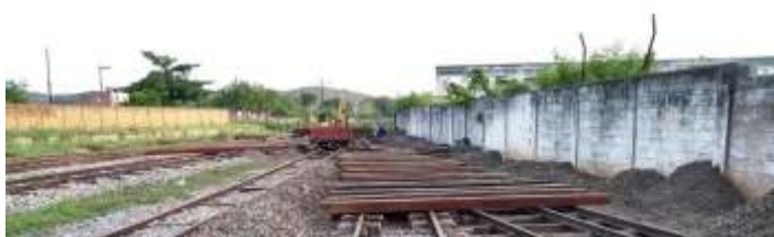
♦ Reforma das vias em Cruzeiro: limpeza, descontaminação de lastro e substituição de dormentes
