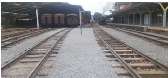
♦ Serviço de aplicação de lastro novo: antes e depois
