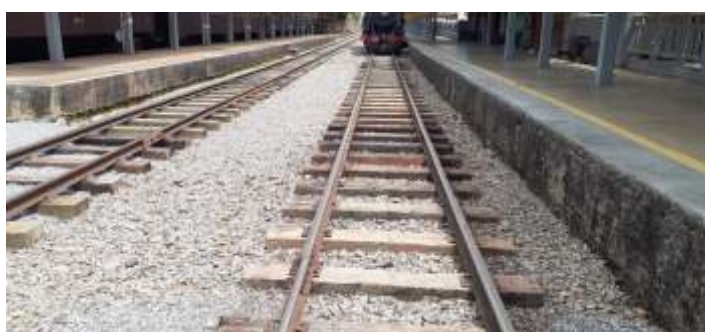
♦ Serviço de aplicação de lastro novo; antes e depois
