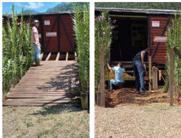
◆ Início do desmonte da rampa de acesso ao vagão bilheteria com o colaborador Ricardo Degracia e reparação do terreno para edificação da nova rampa de acesso ao vagão bilheteria com Ricardo Degracia e Otávio Georg Junior. Autoria de Priscila Jesani dos Santos
