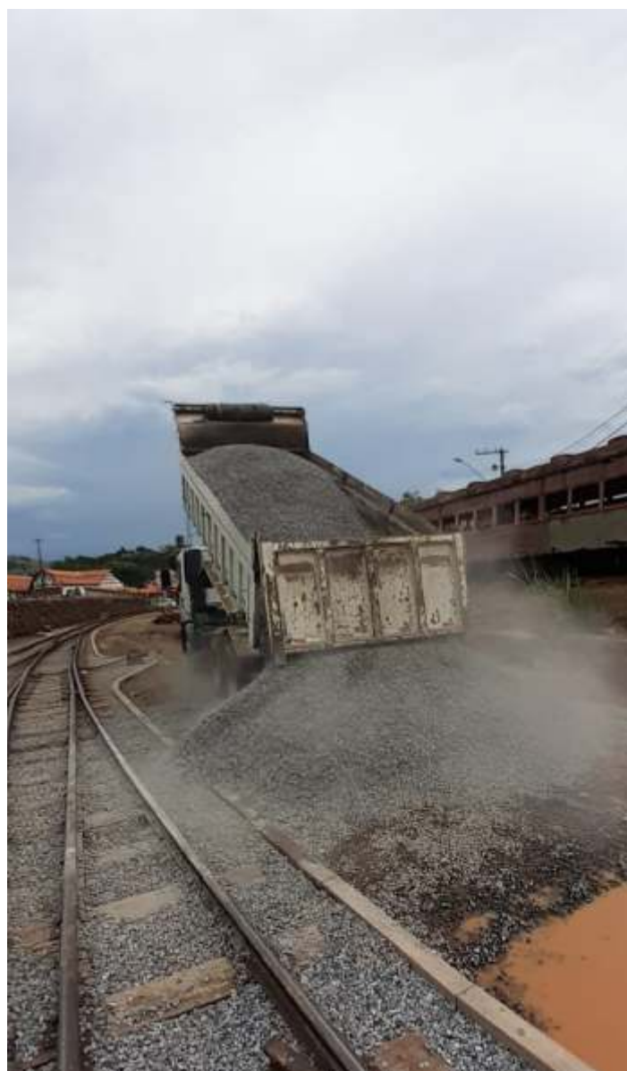
♦ Várias cargas de lastro chegaram ao pátio da estação de São Lourenço
