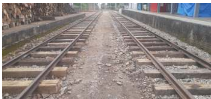
♦ Serviço de aplicação de lastro novo: antes e depois
