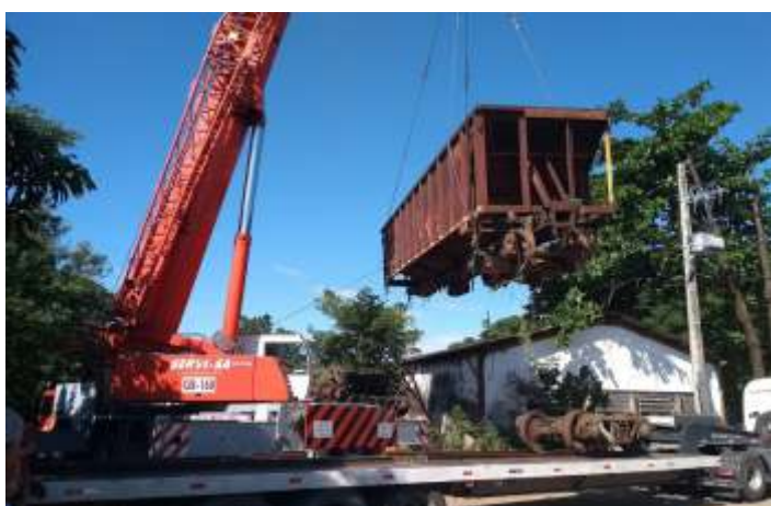
◆ Íçamento do vagão hopper
