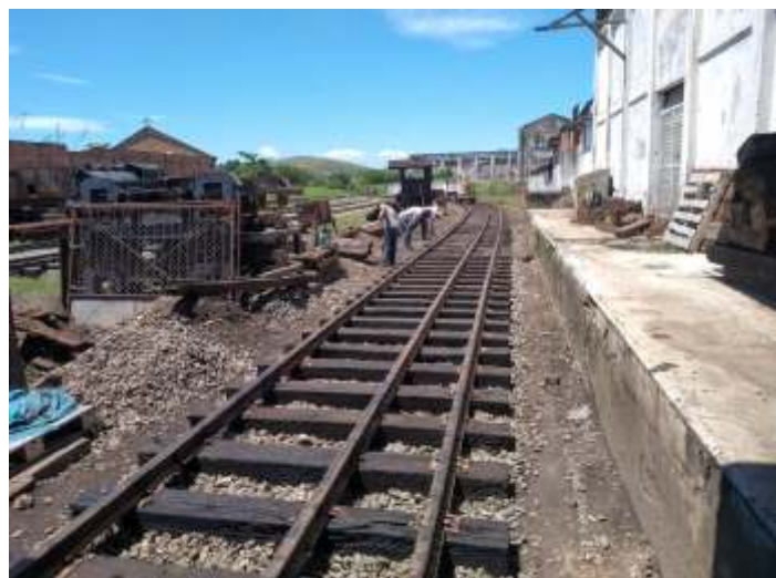
♦ Reforma das vias no pátio de Cruzeiro/SP
