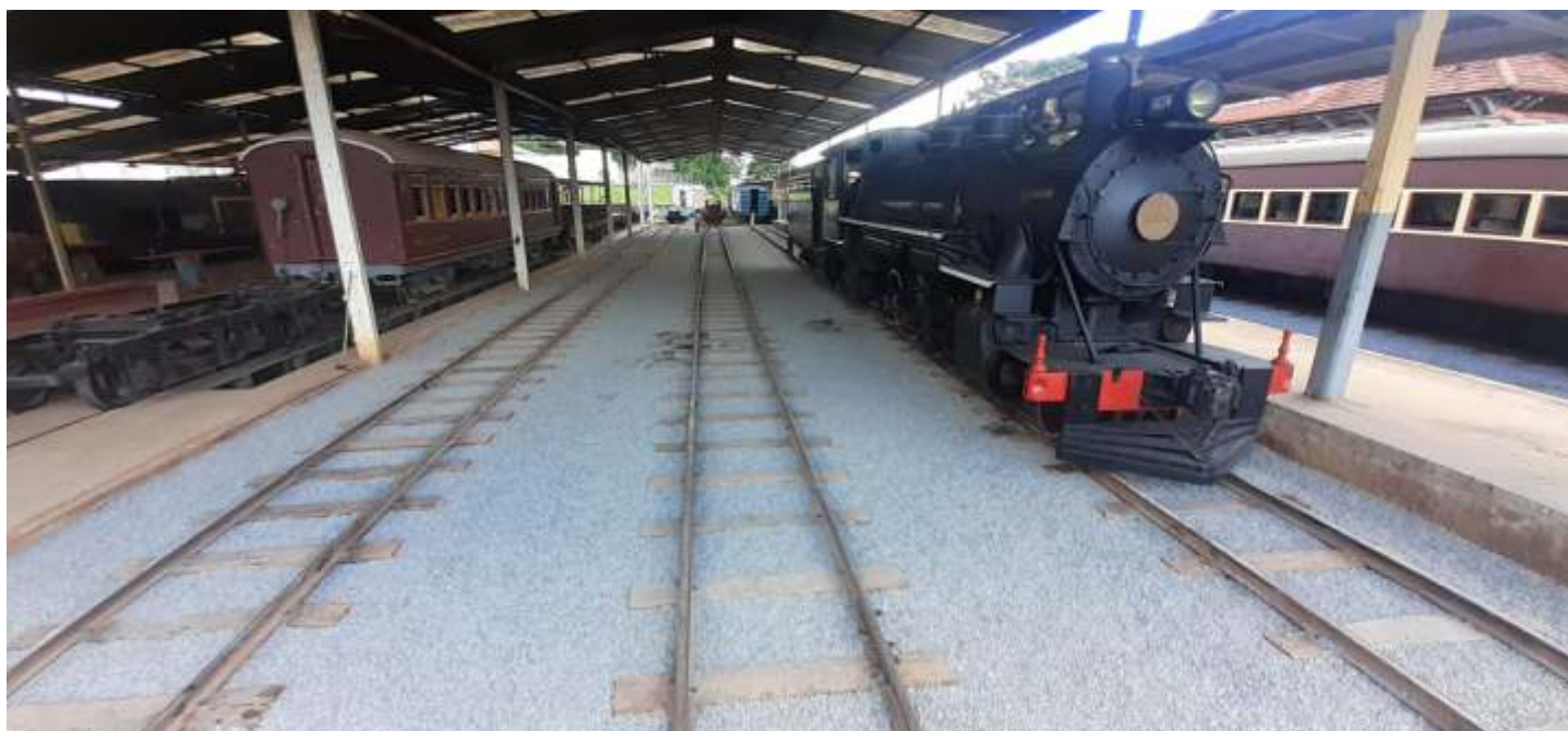
♦ As vias dentro do galpão de material rodante já reformadas e com lastro novo aplicado
