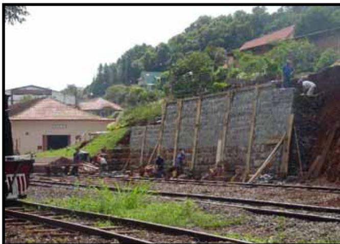
Acima: Construção de muro de contenção na estação de Piratuba-SC.
