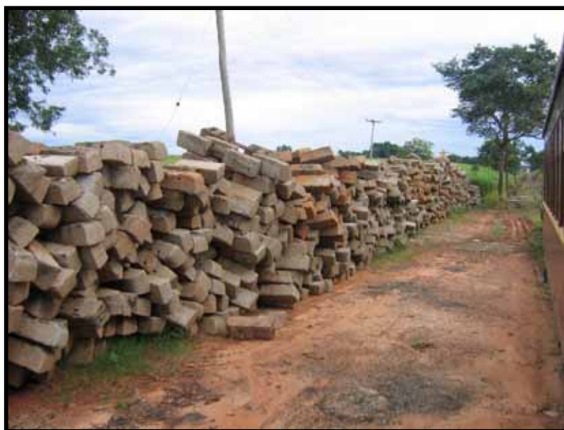
Dormentes de concreto doados pela FCA-VALE aguardando instalação na linha da VFCJ. Foto: Helio Gazetta Filho em fevereiro de 2008.
