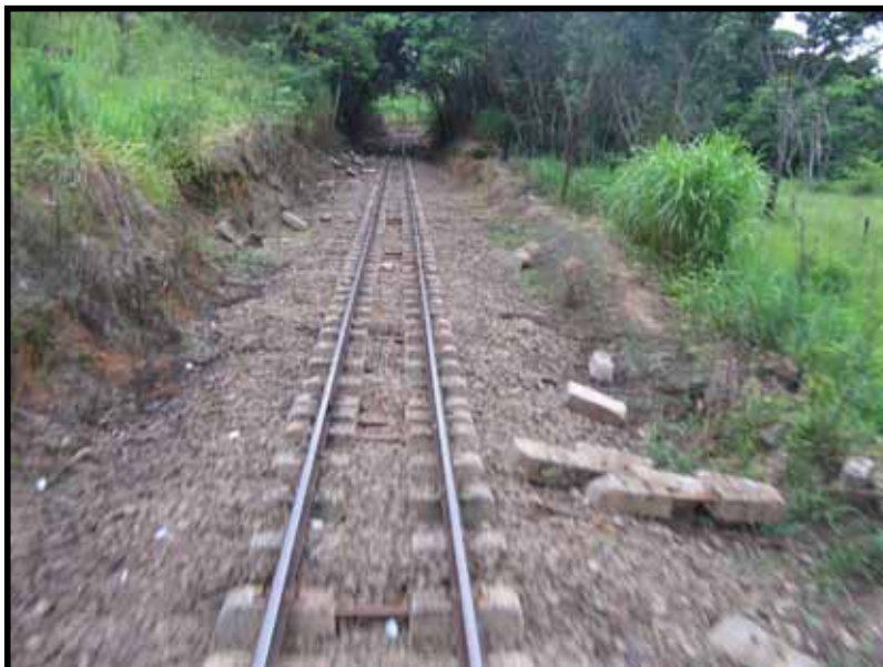
Trecho da linha da VFCJ no qual dormentes de concretos doados pela FCA-VALE estão sendo instalados. Foto: Helio Gazetta Filho em fevereiro de 2008.
