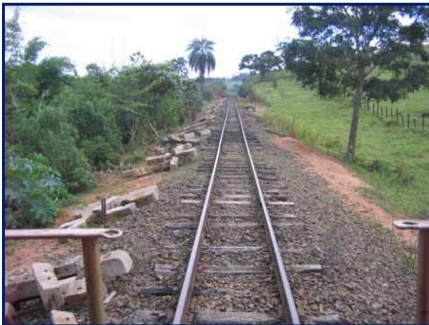
Acima: Dormentes de concreto distribuídos ao longo da linha para substituir os dormentes de madeira.
