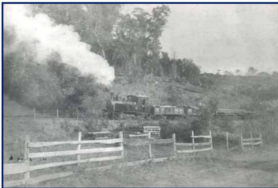
As primeiras movimentações da Macuca em Blumenau em 1908, km 4 de Blumenau, empurrando material de construção até o final da linha. Notem que o compartimento de combustível, na parte posterior da cabine ainda está aberto, procedimento geralmente utilizado para uso de carvão mineral, que assim teria seu carregamento facilitado. Autor desconhecido. Acervo histórico: José Ferreira da Silva – Blumenau-SC
