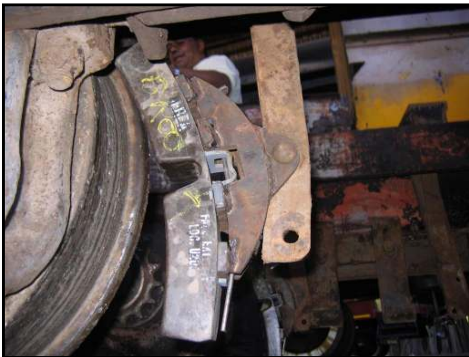
Instalação de sapata de freio na locomotiva Brookville da ABPF-Campinas, realizada pelo associado Antônio Edson Laurindo. Foto: Helio Gazetta Filho em junho de 2008.
