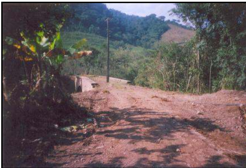
Aspecto do leito da EFSC, já limpo, no trecho que passa sobre o viaduto de dois arcos. O poste ali plantado foi retirado durante o mês de agosto. Foto Luiz Carlos Henkels em julho de 2008.
