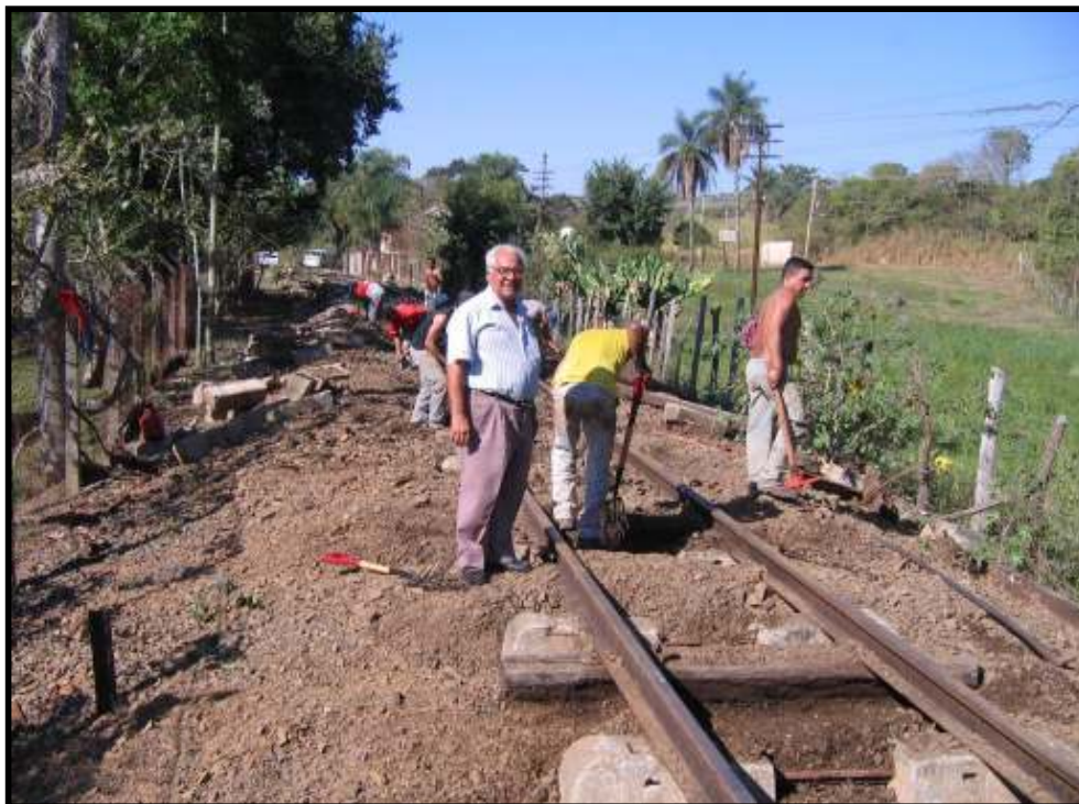
Associado Ivo Arias acompanha trabalho de troca dos dormentes de madeira pelos dormentes de concreto doados pela FCA-VALE. Foto: Helio Gazetta Filho em agosto de 2008.
