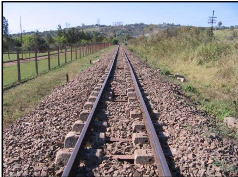
Trecho de linha da VFCJ com dormentes de concreto no aguardo de nivelamento da linha e soca da brita. Foto: helio Gazetta Filho em agosto de 2008.
