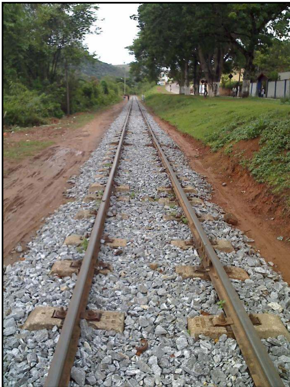
Trecho da linha de São Lourenço-MG que recebeu lastro novo. Foto: Felipe Sanches em outubro de 2008.
