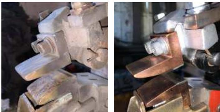
♦ Detalhe para o contato de "prata" substituído por um novo; todos esses contatos serão substituídos por novos
