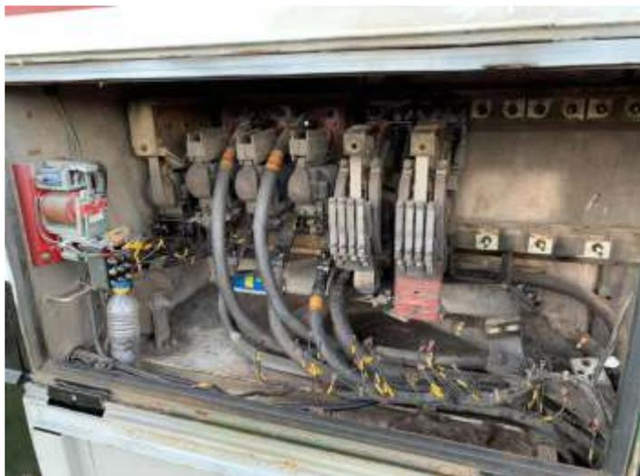
◆ Contadoras sendo removidas para reparação
