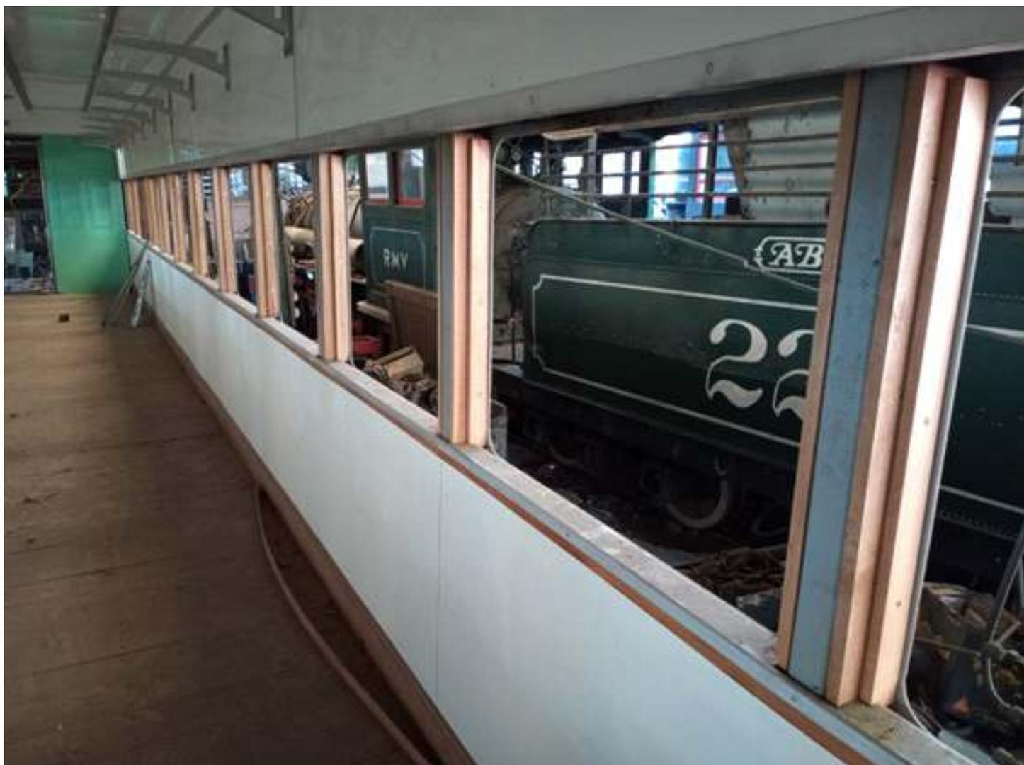
♦ Colocação dos sarrafos para a fixação das correções das janelas
