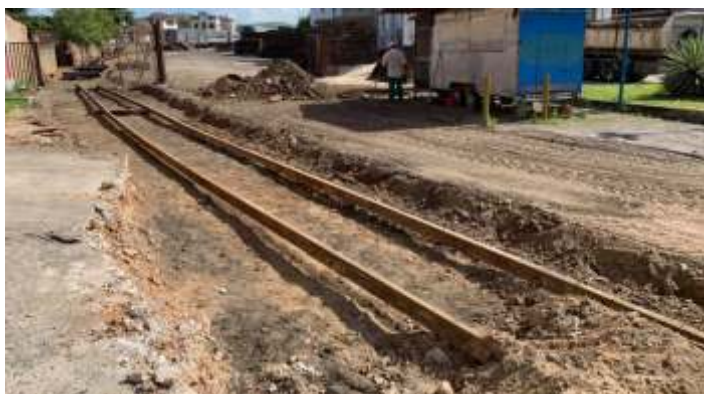
♦ Trabalhos no km 0+100; do início do desaterramento da via a limpeza, instalação de novos dormentes e pregação
