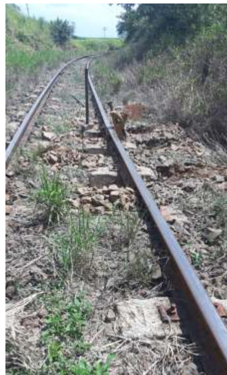
◆ Nivelamento próximo a junta dos trilhos! Foto do Márcio Silva.
