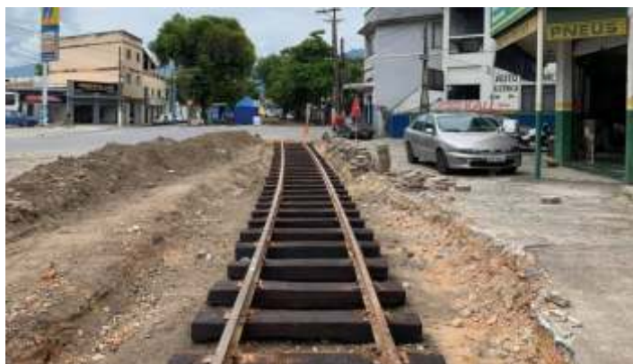
♦ Trabalhos no km 0+300: antes, durante a limpeza e já com a nova dormentação instalada
