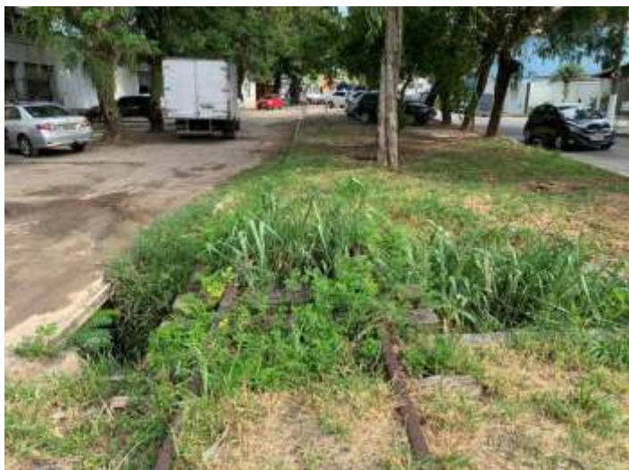
♦ Km 0+300 antes e depois da limpeza: próximo passo é remover o que restou dos dormentes e instalar novos
