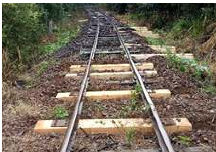
♦ Aplicação de dormentes em diversos pontos no trecho Piratuba/SC a Marcelino Ramos/RS
