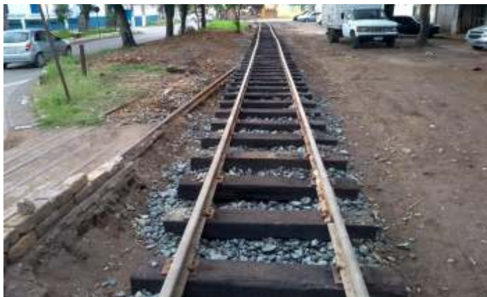
♦ Trabalho de instalação de novos dormentes passando a pn da rua 3
