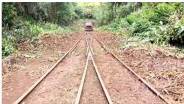
♦ Limpeza do triângulo de reversão no distrito de Uruguai interior de Piratuba
