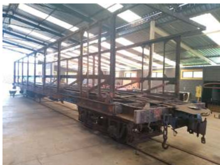
♦ Aspecto da estrutura metálica do carro Busch após a remoção de todo o madeiramento
