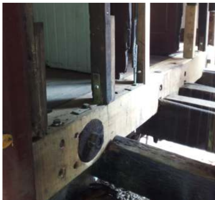
◆ Viga transversal já perfeitamente encaixada e fixada. Autoria de Otávio Georg Junior
