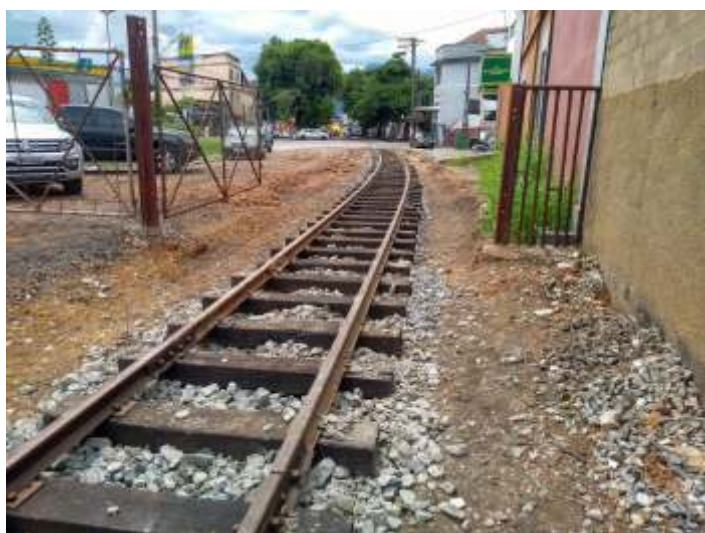
◆ Finalizando nivelamento e alinhamento do km 0+100 ao 0+250
