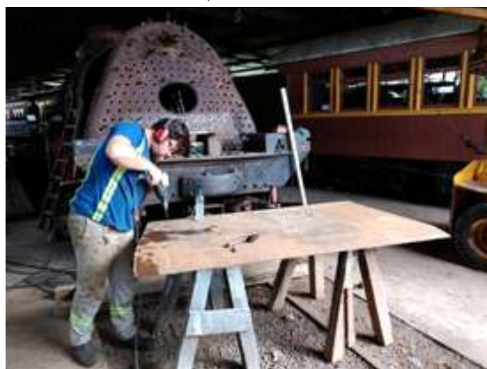
♦ Furação dos estais na chapa do lado direito interno da locomotiva Mikado nº 156
