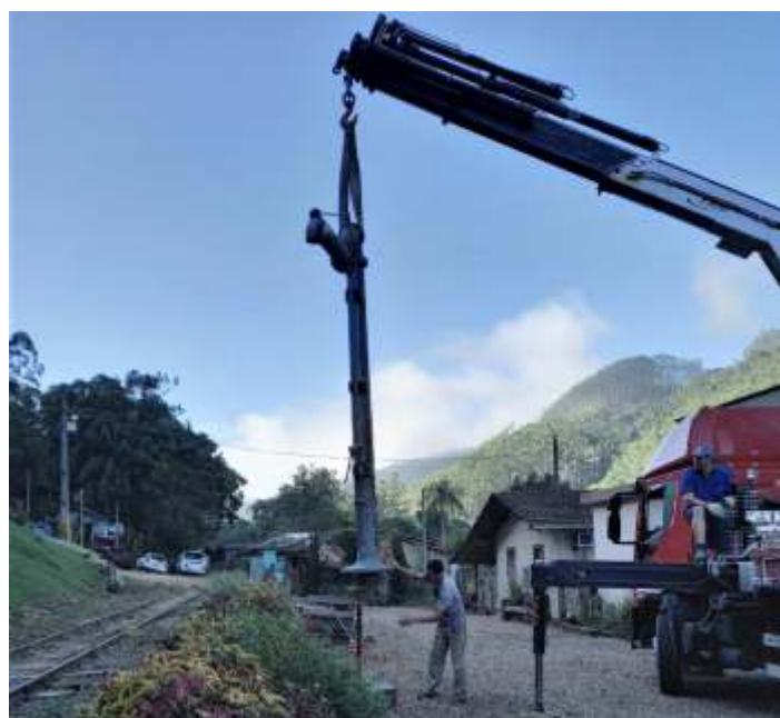
◆ Fixação da adutora de água com braço de abastecimento. Autoria de Priscila Jesani dos Santos
