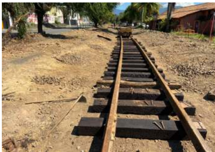
♦ Um trecho em três etapas: logo após a escavação; início da instalação dos dormentes novos e após a instalação da dormentação nova
