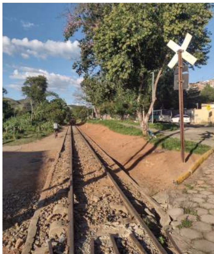
♦ Limpeza na faixa de domínio do km 80+200
