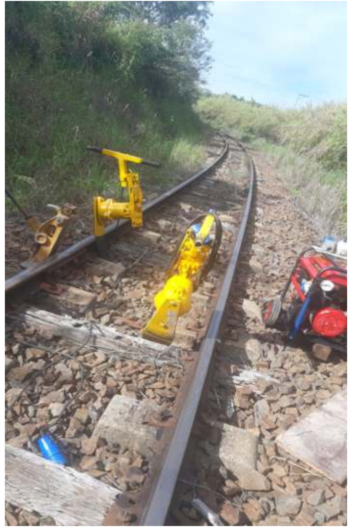
◆ Detalhe do gerador e os famosos pés de pato, para a socaria dos dormentes.
