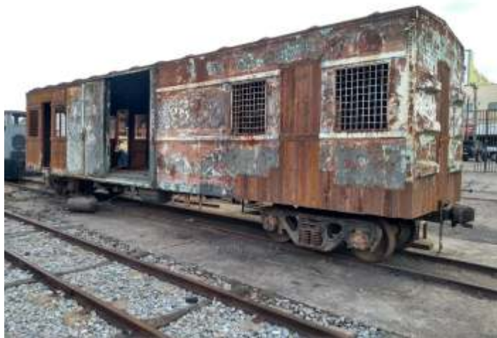
◆ Início dos trabalhos no antigo bagageiro da Leopoldina
