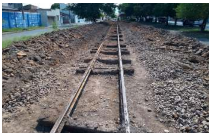
♦ Trabalho de escavação já avançado em direção a pn da rua 7
