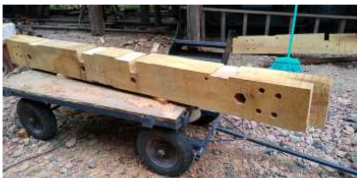
◆ Viga substituta já trabalhada e adaptada para o encaixe; trabalho perfeito do carpinteiro Dierres Ferreira Freitas. Autoria de Otávio Georg Junior
