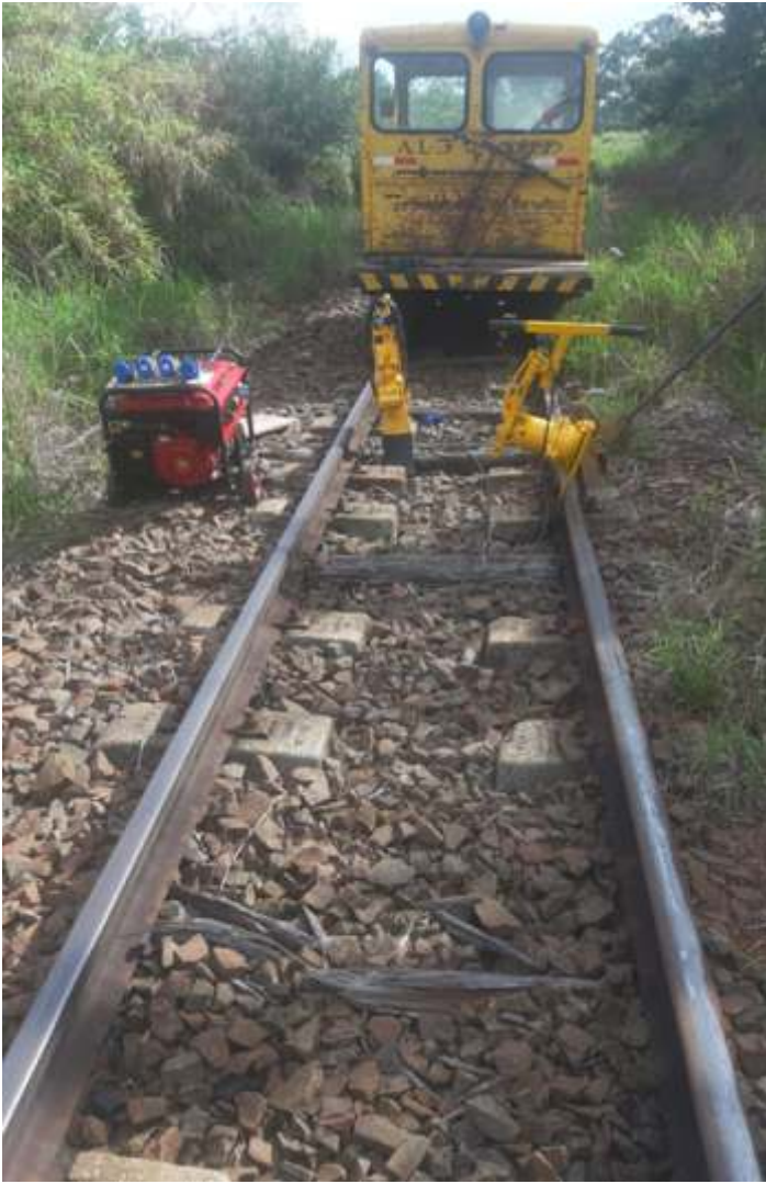
◆ Nivelamento de alguns pontos, após substituição dos velhos dormentes de madeira.
