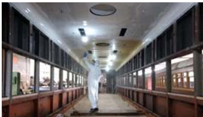
♦ Início da pintura do teto no interior do carro Cacique
