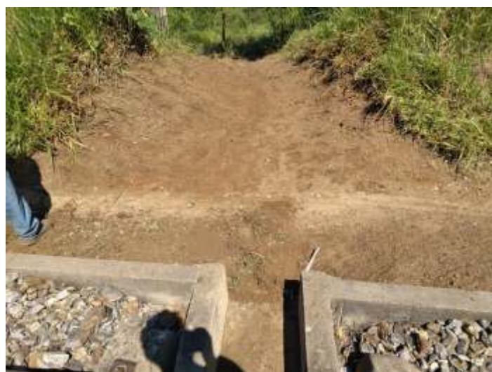
♦ Limpeza do sistema de drenagem da via
