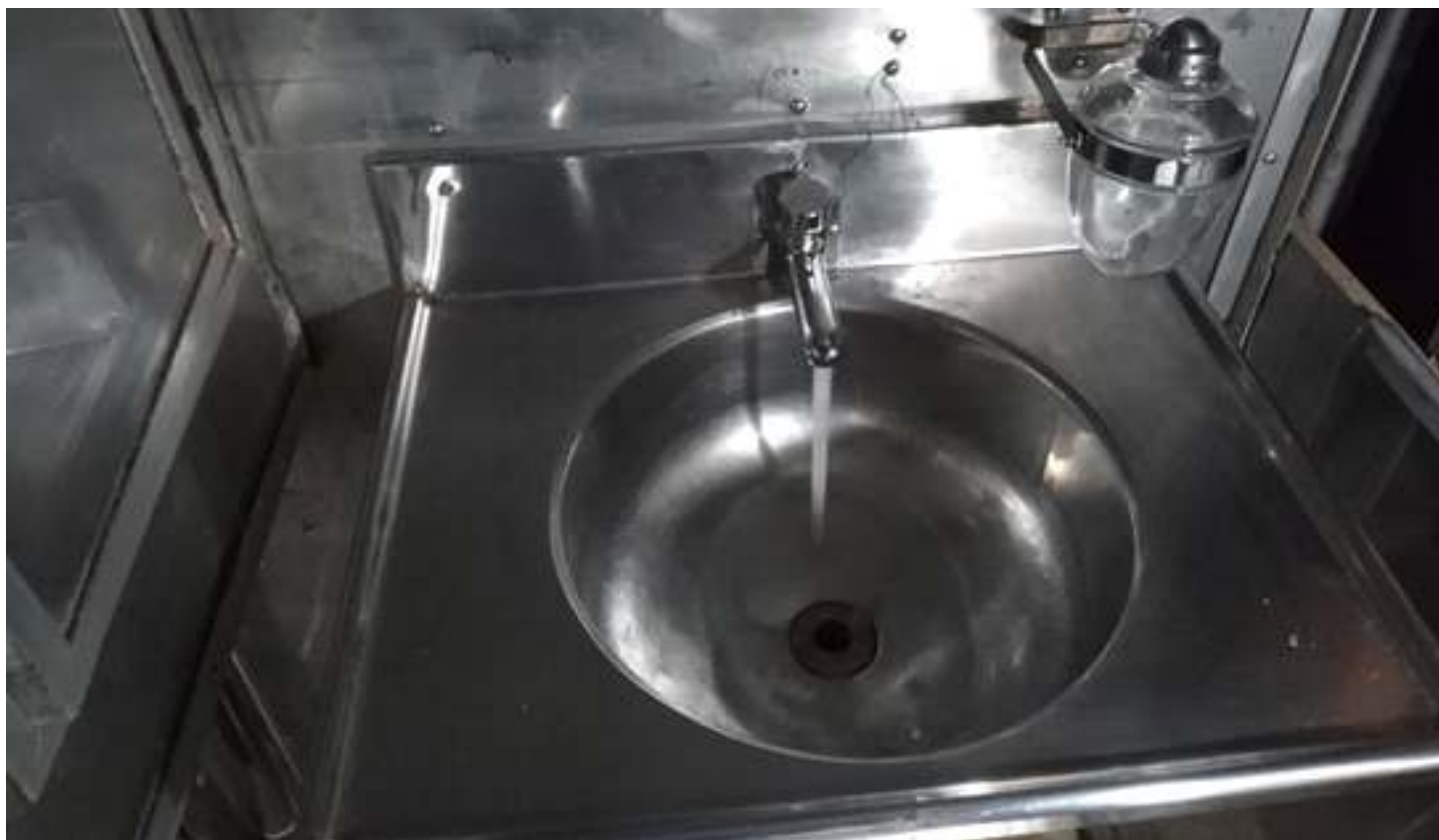
♦ Lavatório original do carro sendo reinstalado – Foto Helio Gazetta Filho
