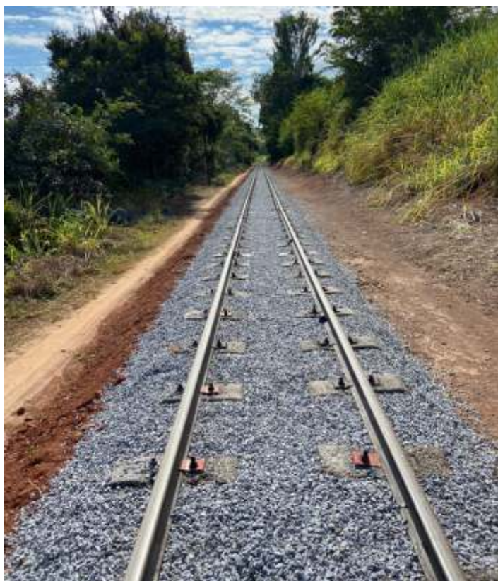
♦ Limpeza e complementação de lastro no km 85
