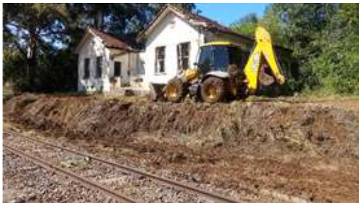
♦ Limpeza no entorno do antigo prédio do pernoite de Uruguai no Km 857 + 500
