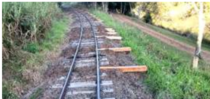
♦ Aplicação de dormentes no Km 838 + 500
