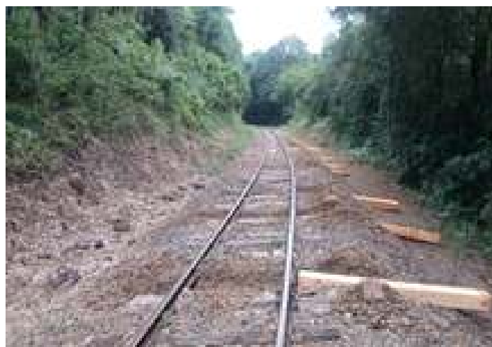
♦ Trabalhos na via na aplicação de dormentes
