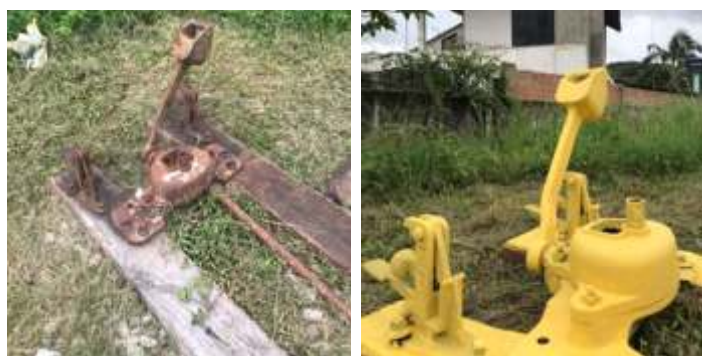
♦ Pintura e limpeza dos aparelhos de mudança de via no pátio da estação de Antonina
