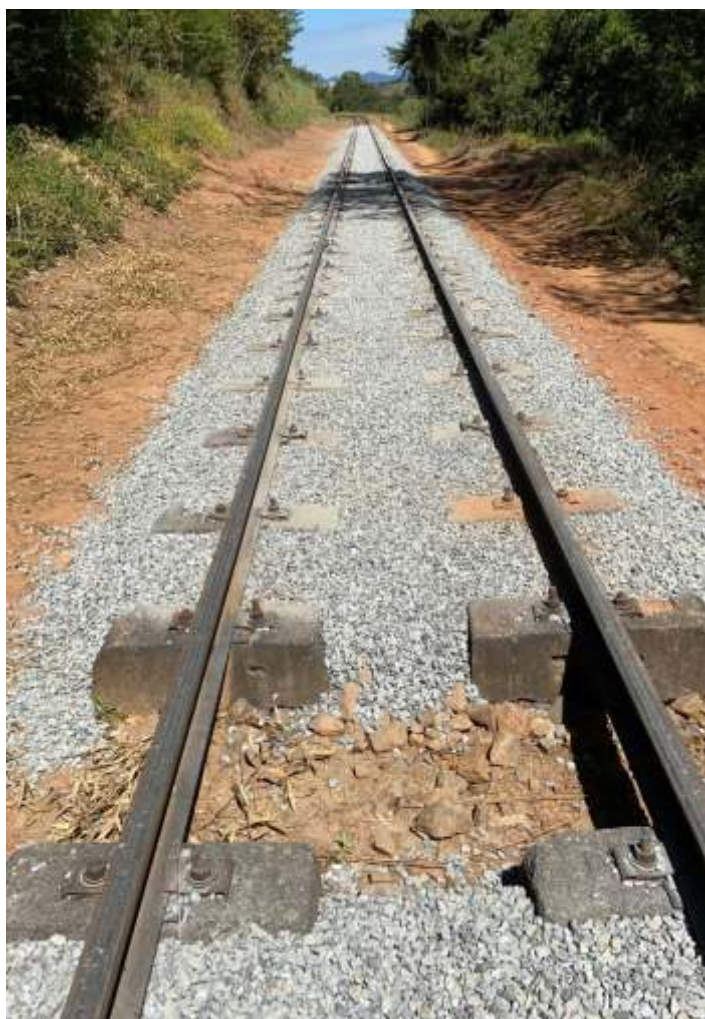
♦ Complementação de lastro km 85: antes e depois
