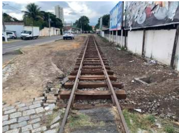
♦ Trecho entre as Ruas 7 e 8: aspectos de antes, durante e após as obras, restando agora somente a complementação de lastro para estar 100% pronto
