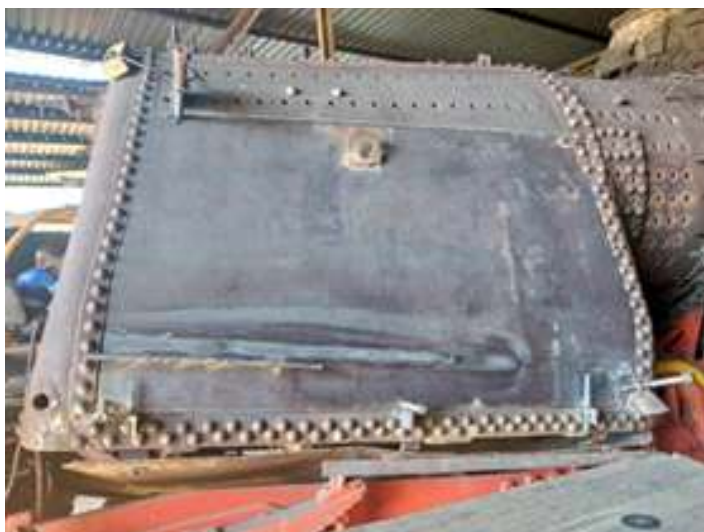
♦ Preparação da chapa externa do lado direito já na posição do corte
