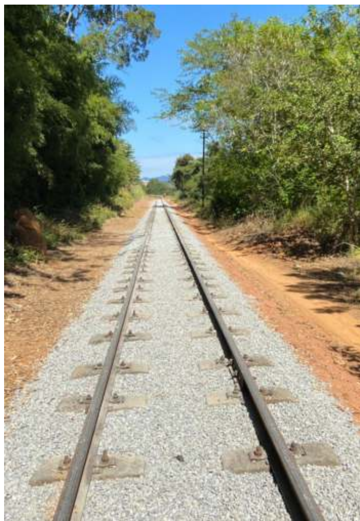
♦ Complementação de lastro km 85: antes e depois
