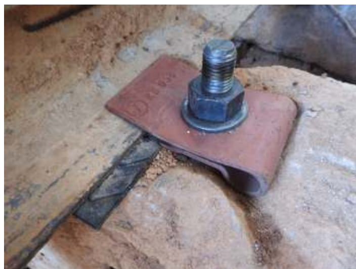
♦ Conjunto de fixação nova sendo instalado. Foto de Vanderlei Zago
