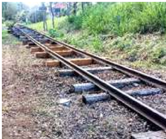
♦ Montagem de rampa para o carregamento da nº 235
