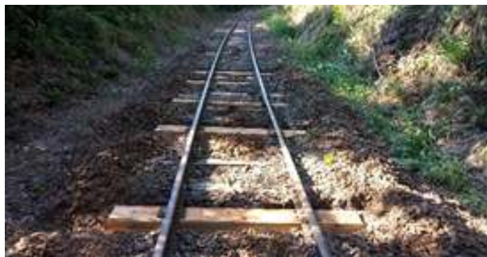
♦ Aplicação de dormentes no Km 838 + 100
