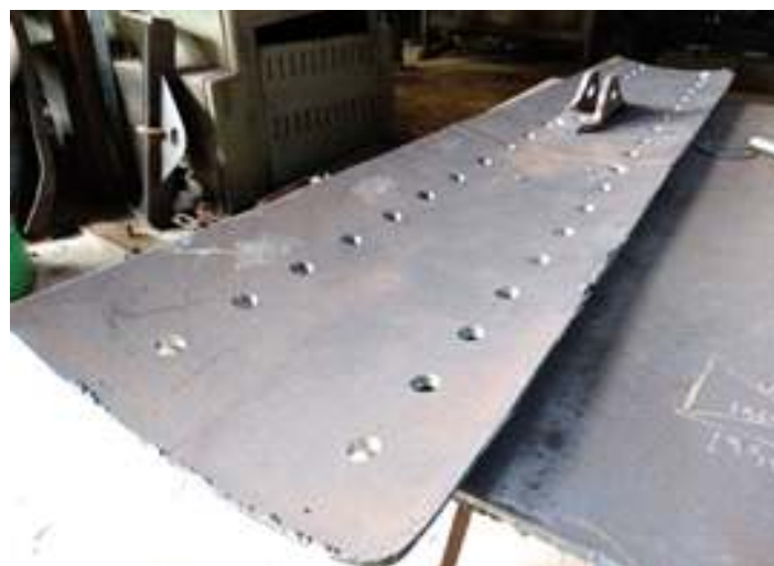
◆ Instalação da chapa interna do lado esquerdo e finalização das soldas
