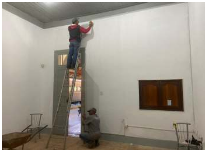
♦ Obras na bilheteria: reparação e lixamento do piso; pintura da alvenaria, das esquadrias e do forro do teto
