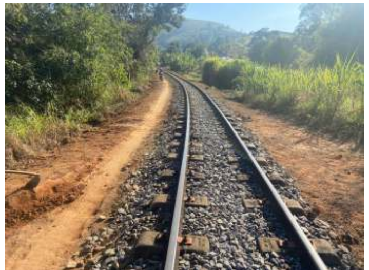
◆ Limpeza da faixa de domínio no km 87+900
