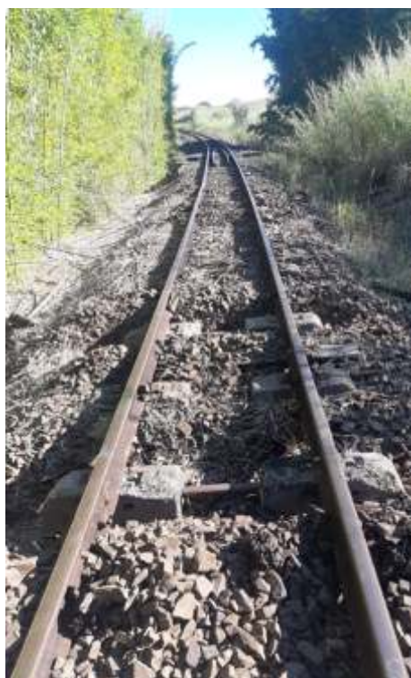
♦ Troca de dormentes de madeira por de concreto no Km 16. Foto - Marcio Silva
