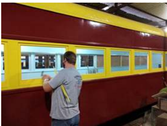
♦ Colocação dos vidros
