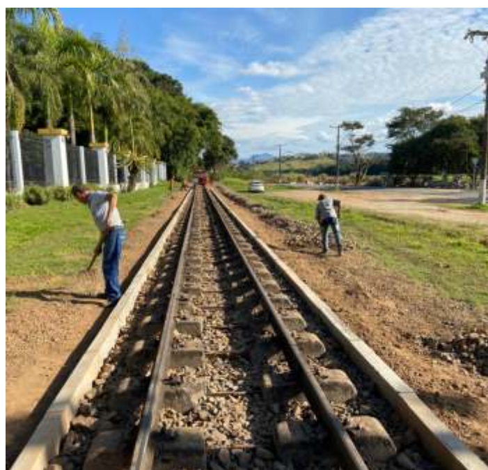
♦ Obras no km 84+300: antes e durante; meio-fios para contenção do lastro já foram instalados; a via foi alinhada e nivelada e o lastro descontaminado e aguarda agora complementação do lastro para finalização.
