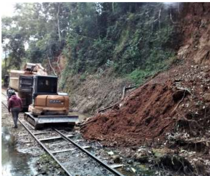
♦ Terraplanagem Pereira retirando uma das barreiras. Autoria de Otávio Georg Junior
