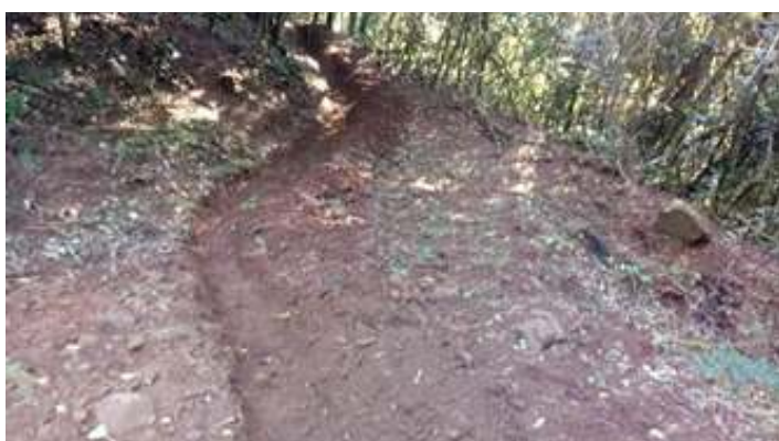
♦ Trabalhos de limpeza de vala de contenção no Km 849+200
