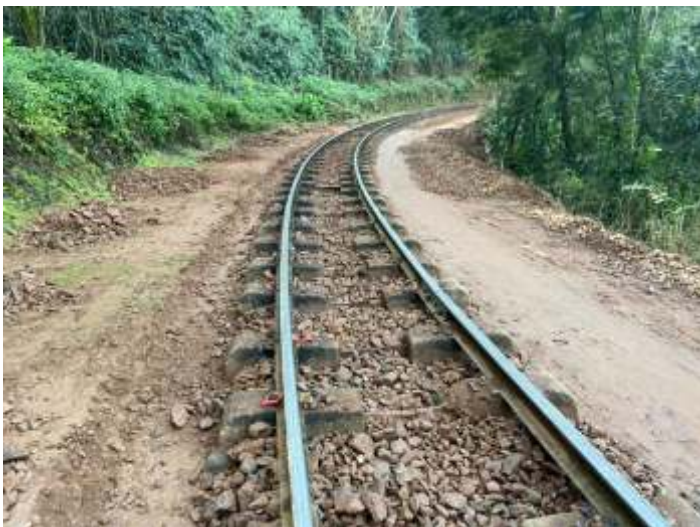
◆ Obras no km 88+900 antes e depois: a via foi alinhada e nivelada e o lastro descontaminado e aguarda agora complementação do lastro para finalização.
