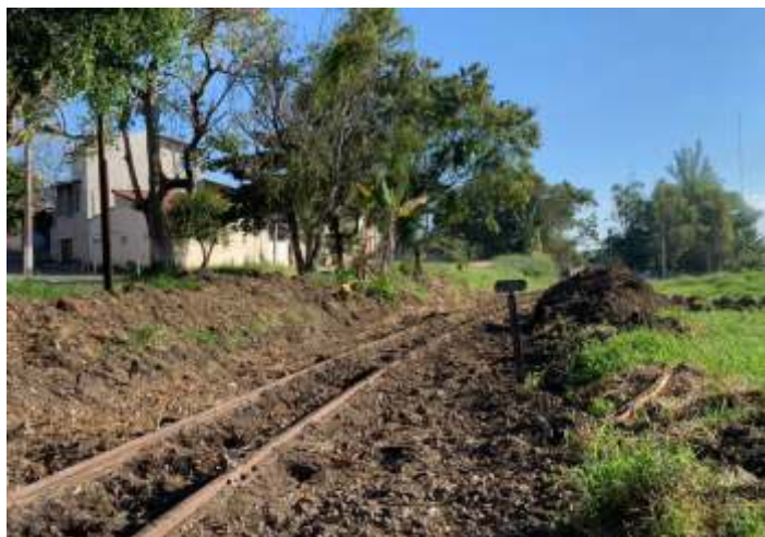
♦ Aspectos do antes e após limpeza no km2+000
