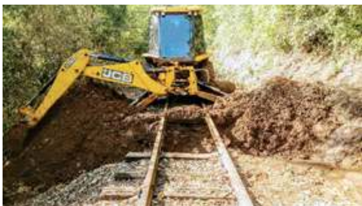
♦ Trabalhos de instalação de um novo ponto de drenagem do Km 849+200
