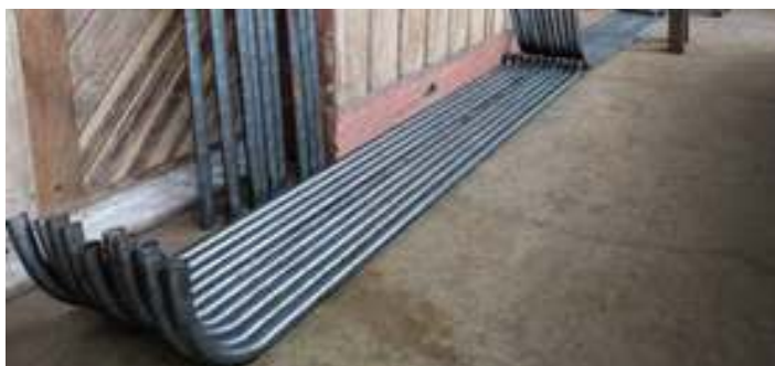
♦ Os antigos tubos do super aquecedor e a pré-montagem dos novos tubos do super aquecedor
