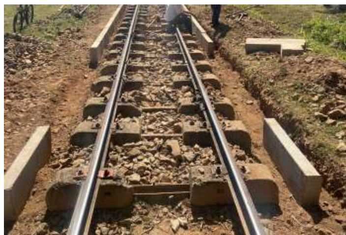
♦ Alinhamento, nivelamento e complementação de lastro no km 87+150
