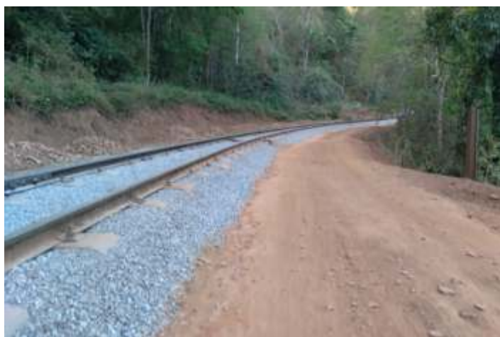
♦ Limpeza e complementação de lastro no trecho
