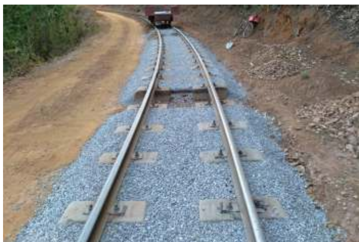
♦ Antes e depois: limpeza e complementação de lastro
