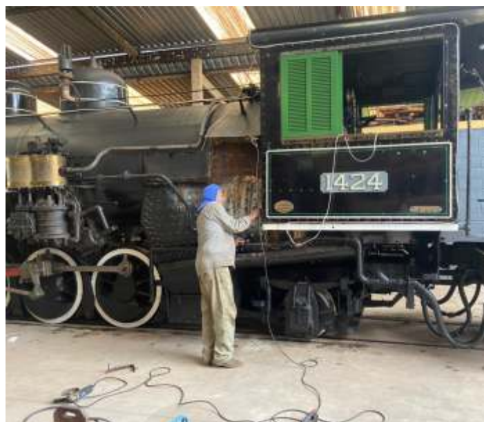
♦ Trabalhos na caldeira da locomotiva 1424.
