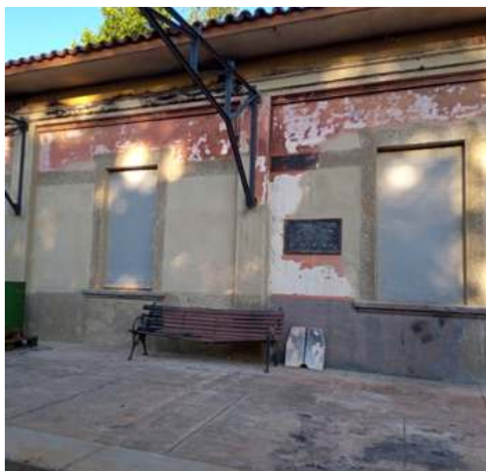
♦ Beiral do telhado e reboco, parcialmente concluídos
