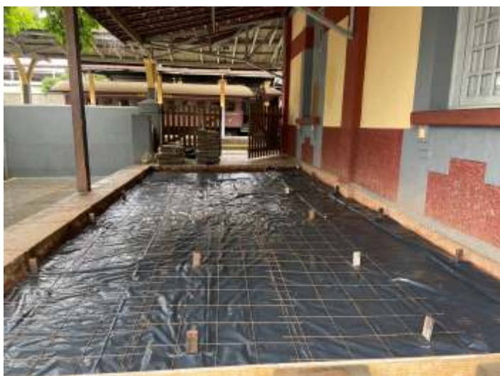
♦ Instalação da malha de aço para concretagem.
