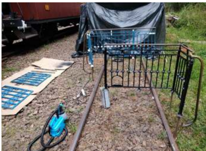
♦ Varanda já desmontada para restauração e pintura.
