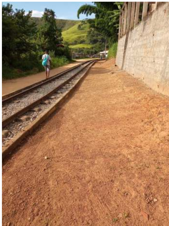
♦ Serviço de capina e limpeza da faixa de domínio da ferrovia entre São Lourenço e Soledade de Minas.
