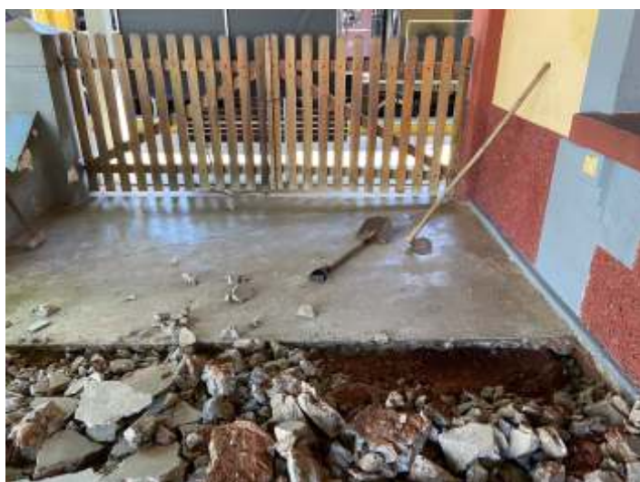
◆ Remoção do piso da plataforma lateral esquerda da estação de São Lourenço
