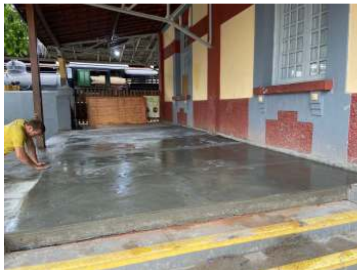
♦ Finalização do novo piso.
