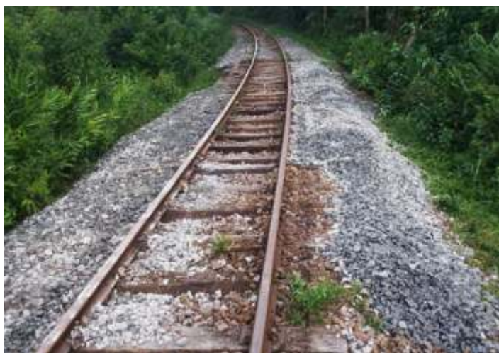
♦ Trabalhos de nivelamento da via permanente.
