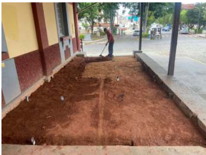
♦ Reaterro e nivelamento.
