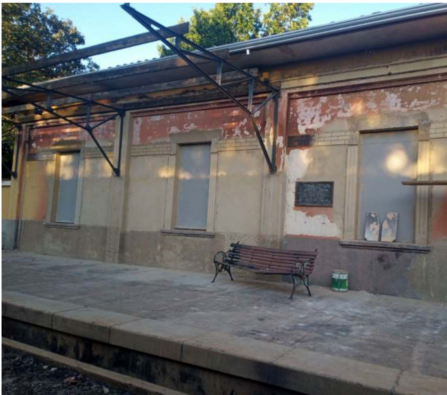
◆ Detalhe da fachada de Carlos Gomes e calhas novas instaladas – Foto H.G.F.
