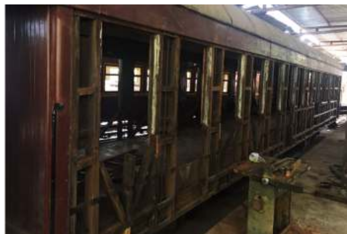
♦ Carro PD-43 já com o madeiramento interior e exterior removido
