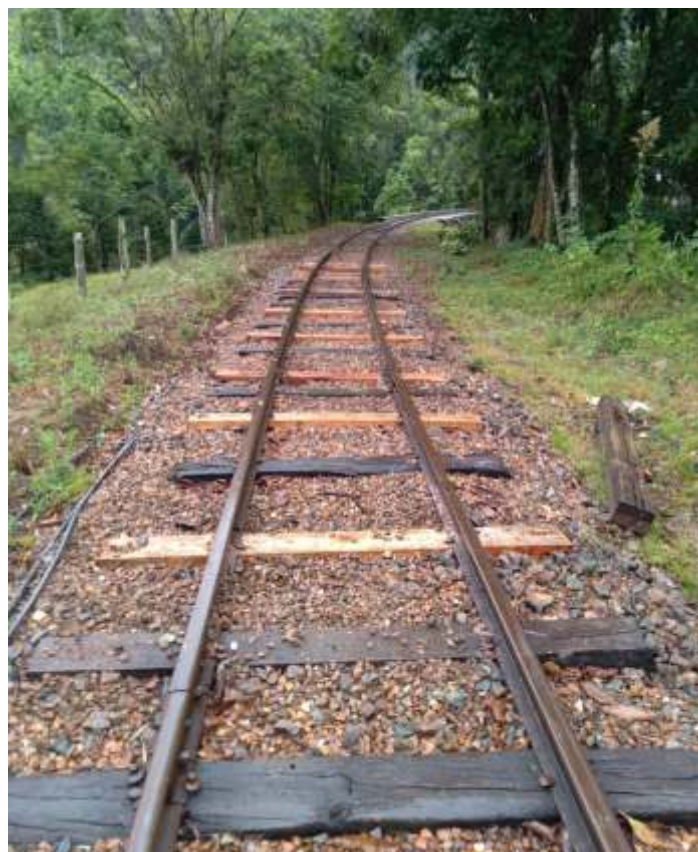
♦ Dormentes novos em direção ao viaduto de dois arcos.
