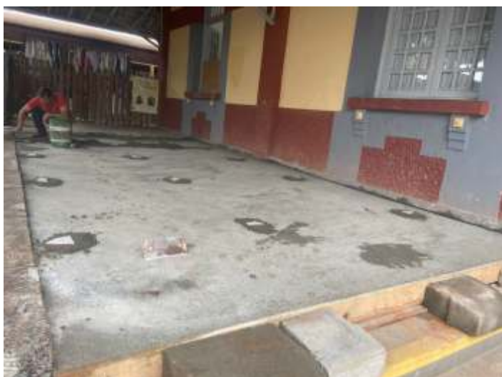
♦ Contra-piso concluído, já na fase de preparação para receber o piso.
