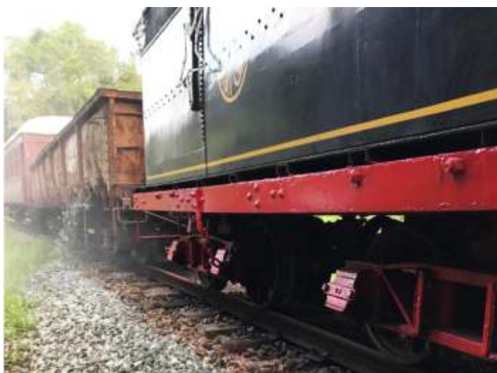
♦ Descarga de britas de lastro para nivelamento da ferrovia.
