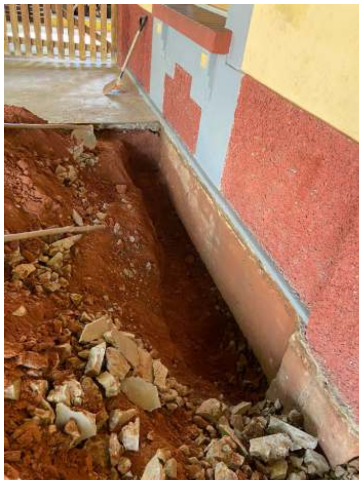
◆ Abertura de acessos para verificação das fundações da estação.
