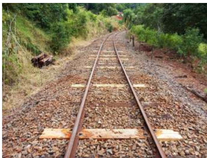
♦ Troca de dormentes e manutenção da via permanente.
