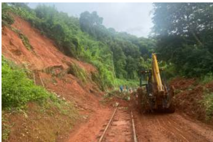
◆ Remoção da terra que caiu sobre a linha.
