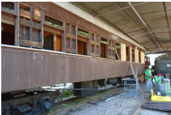
◆ O carpinteiro Dierres Ferreira Freitas na restauração externa do A11. A autoria de Luiz Carlos Henkels.
