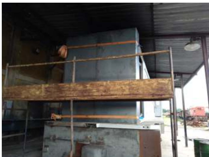
♦ Chapas colocadas no lugar para serem realizados os trabalhos de formatação e criação das aberturas.
