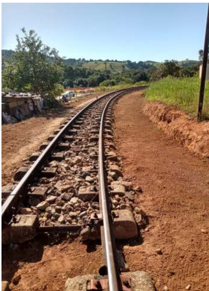
♦ Limpeza, alinhamento e nivelamento da via.
