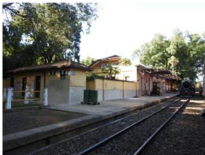
♦ Detalhes dos serviços na alvenaria e telhado – Vanderlei Zago.
