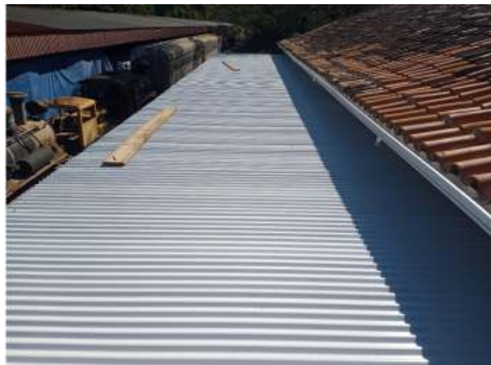
♦ Novas telhas da plataforma de Carlos Gomes – Foto H. Gazetta
