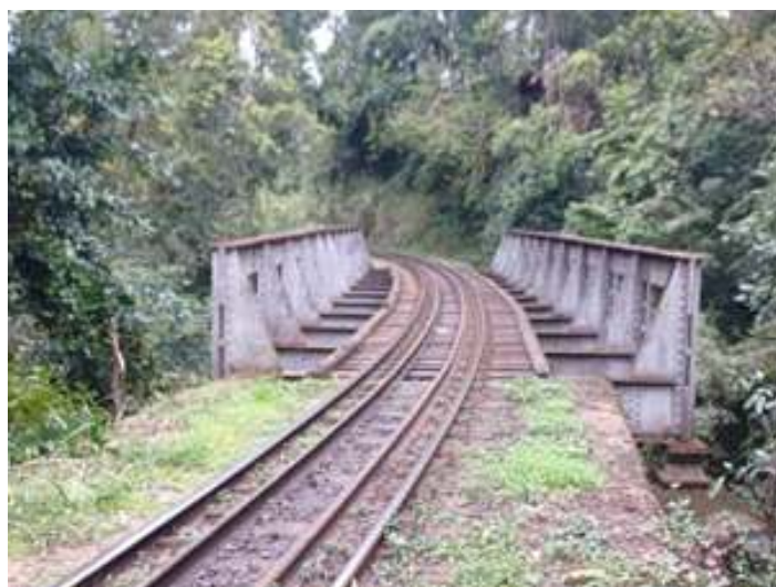
◆ Aspecto da ponte sobre o Rio Mandioca após roçada na via e limpeza da cabeceira.
