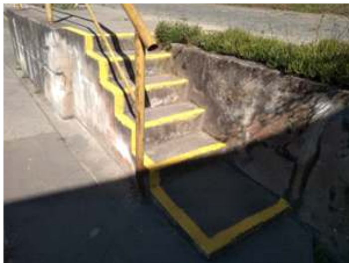
♦ Pintura em amarelo da chave dos AMVs e dos degraus de acesso à estação ferroviária.
