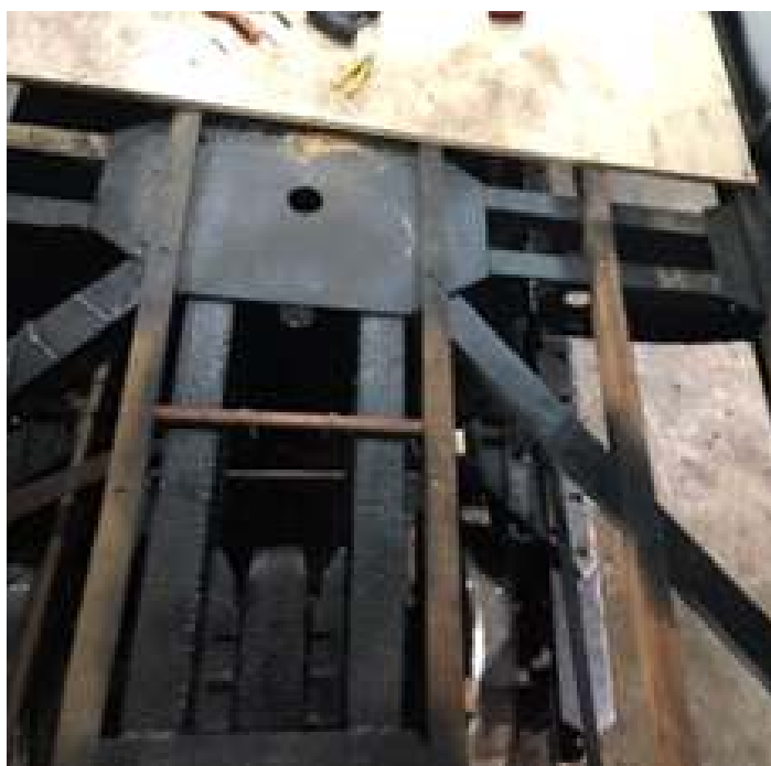
♦ Reconstrução do assoalho do carro PC-60.
