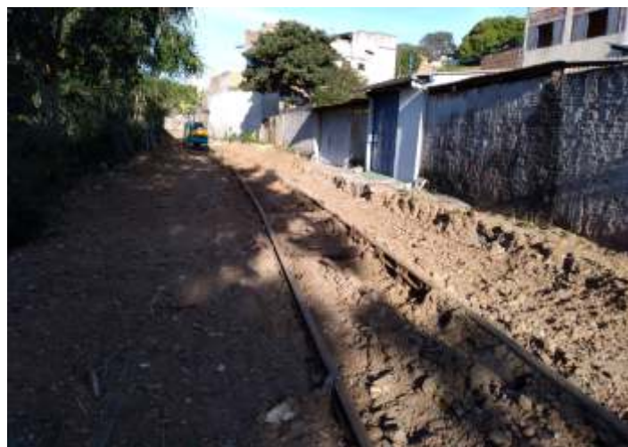
♦ Aspecto das obras ao longo do km 4.
