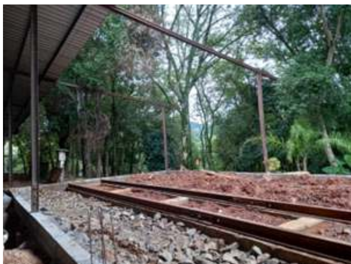
♦ Obras de construção da vala para manutenção de material ferroviário.
