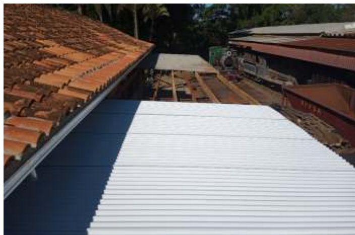
♦ Reconstrução do telhado da plataforma de Carlos Gomes – Foto de H. Gazetta.
