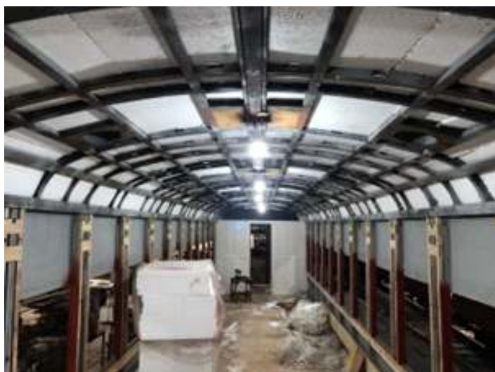
♦ Aplicação de isopor para isolamento termoacústico.
