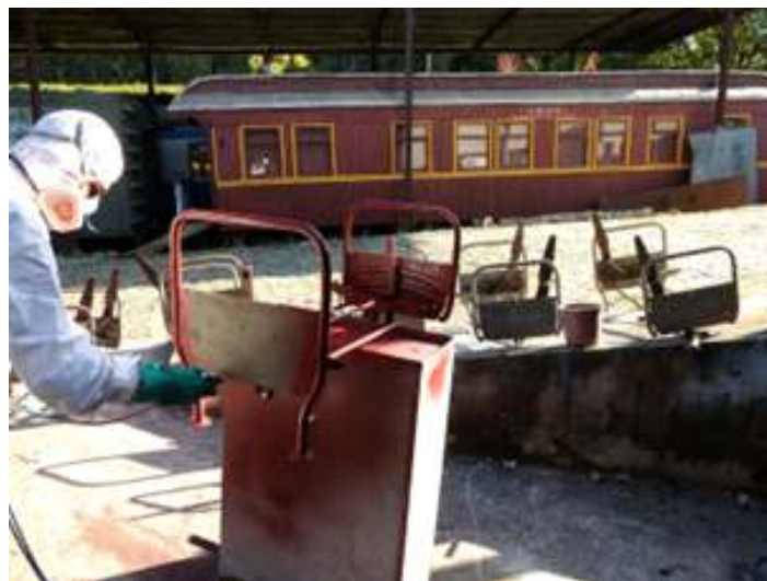
♦ Pintura final da estrutura metálica das poltronas do carro de passageiros PC-60.
