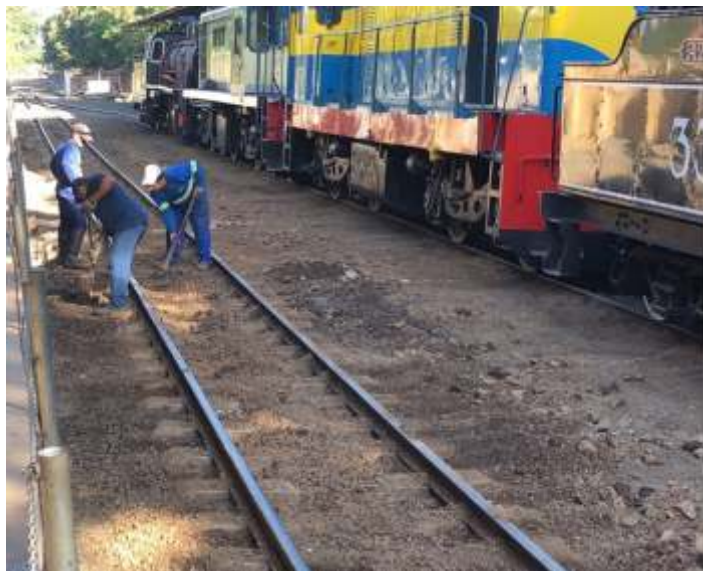
♦ Serviços de troca de dormentes em Anhumas – Foto de Vanderlei Zago.
