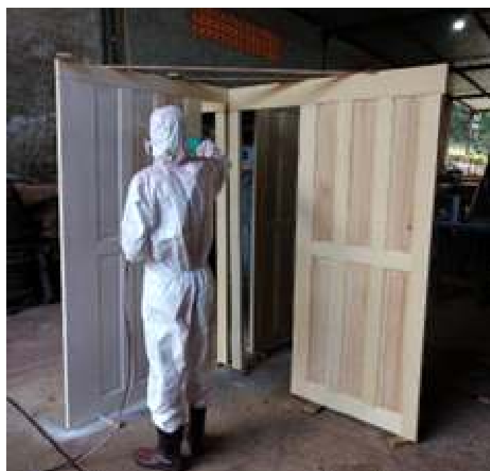
♦ Pintura das paredes de divisória dos sanitários do PC-60.
