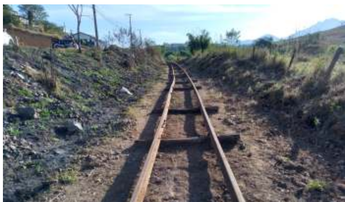
♦ Aspecto das obras ao longo do km 4.
