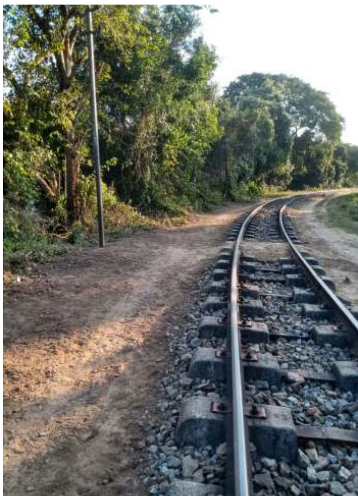
♦ Limpeza, alinhamento e nivelamento da via.
