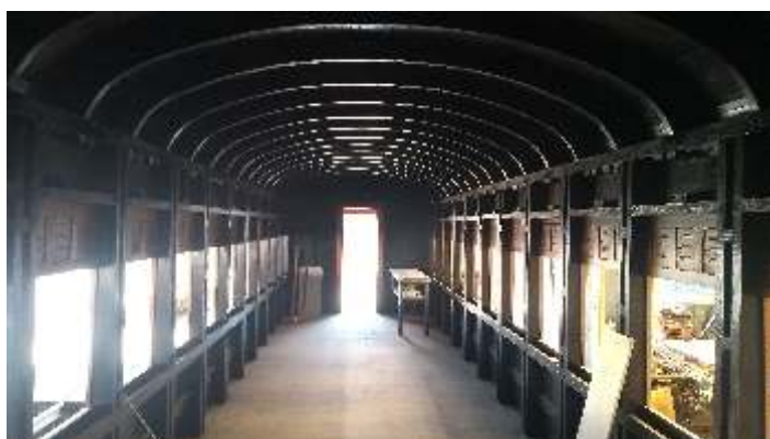
♦ Aspecto da parte interna, pronta para o revestimento.
