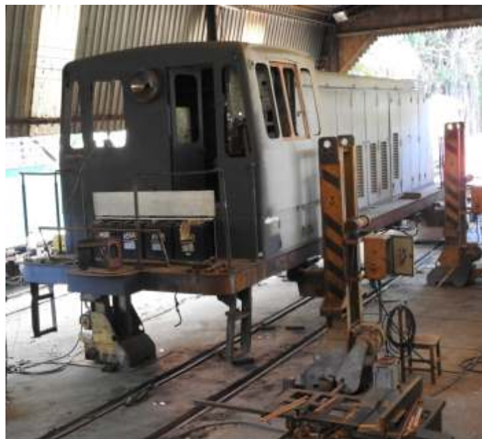
◆ GE suspensa para retirada de truques- Fotos de Vanderlei Zago.
