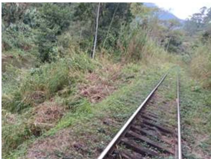
◆ Roçadas de limpeza da via ao lado das corredeiras do Rio Hansa Humboldt.
