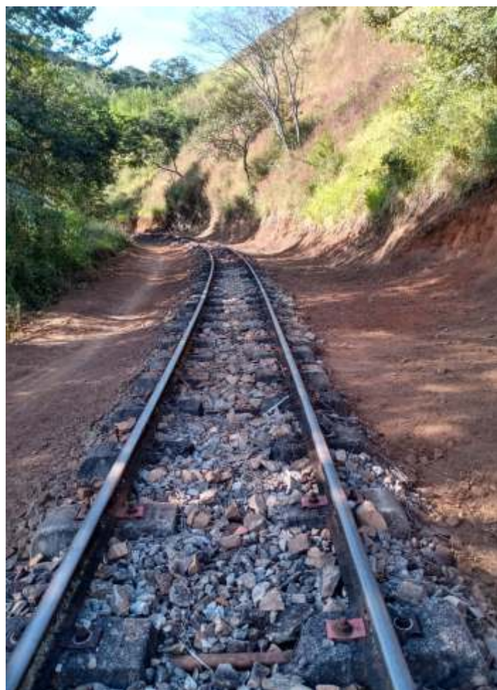
♦ Limpeza, alinhamento e nivelamento da via.
