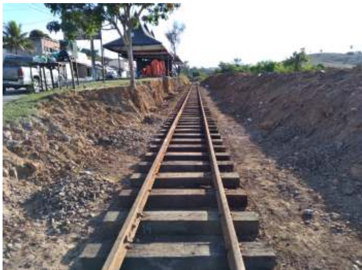
♦ Aspecto do antes e depois no km4.
