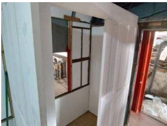
♦ Paredes de divisórias dos sanitários já instaladas no carro de passageiros PC-60.
