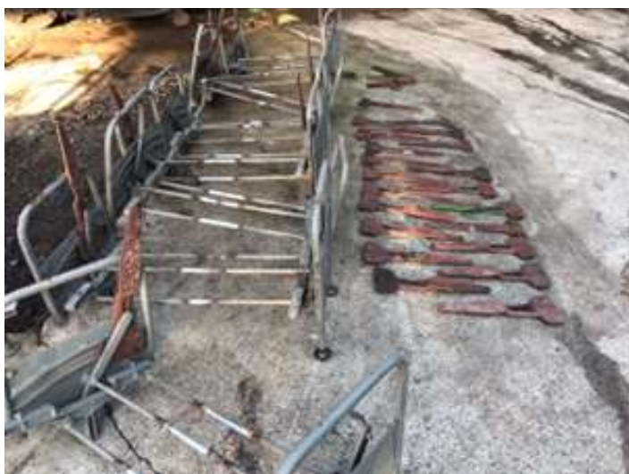
♦ Desmontagem da estrutura metálica das poltronas do carro de passageiros PC-60.
