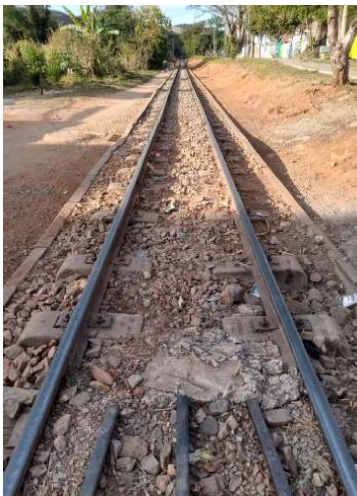
♦ Limpeza, alinhamento e nivelamento da via.
