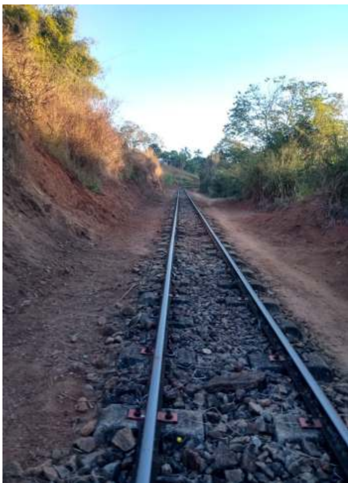
♦ Limpeza, alinhamento e nivelamento da via.
