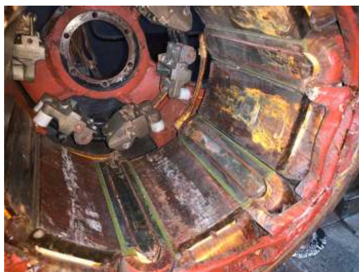
♦ Desmontagem do gerador principal.
