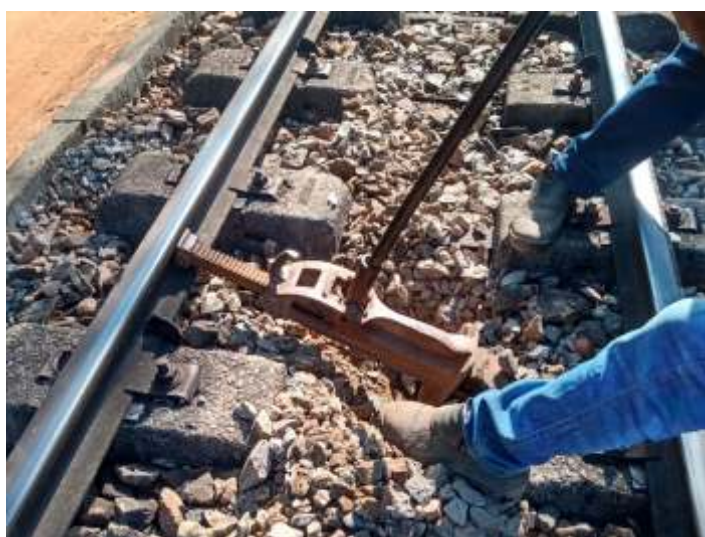
♦ Serviço de alinhamento da via.
