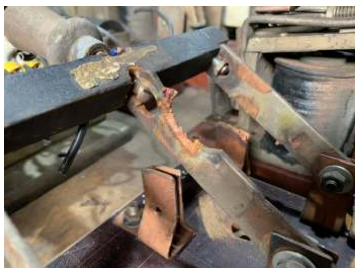
♦ Componentes elétricos muito deteriorados.
