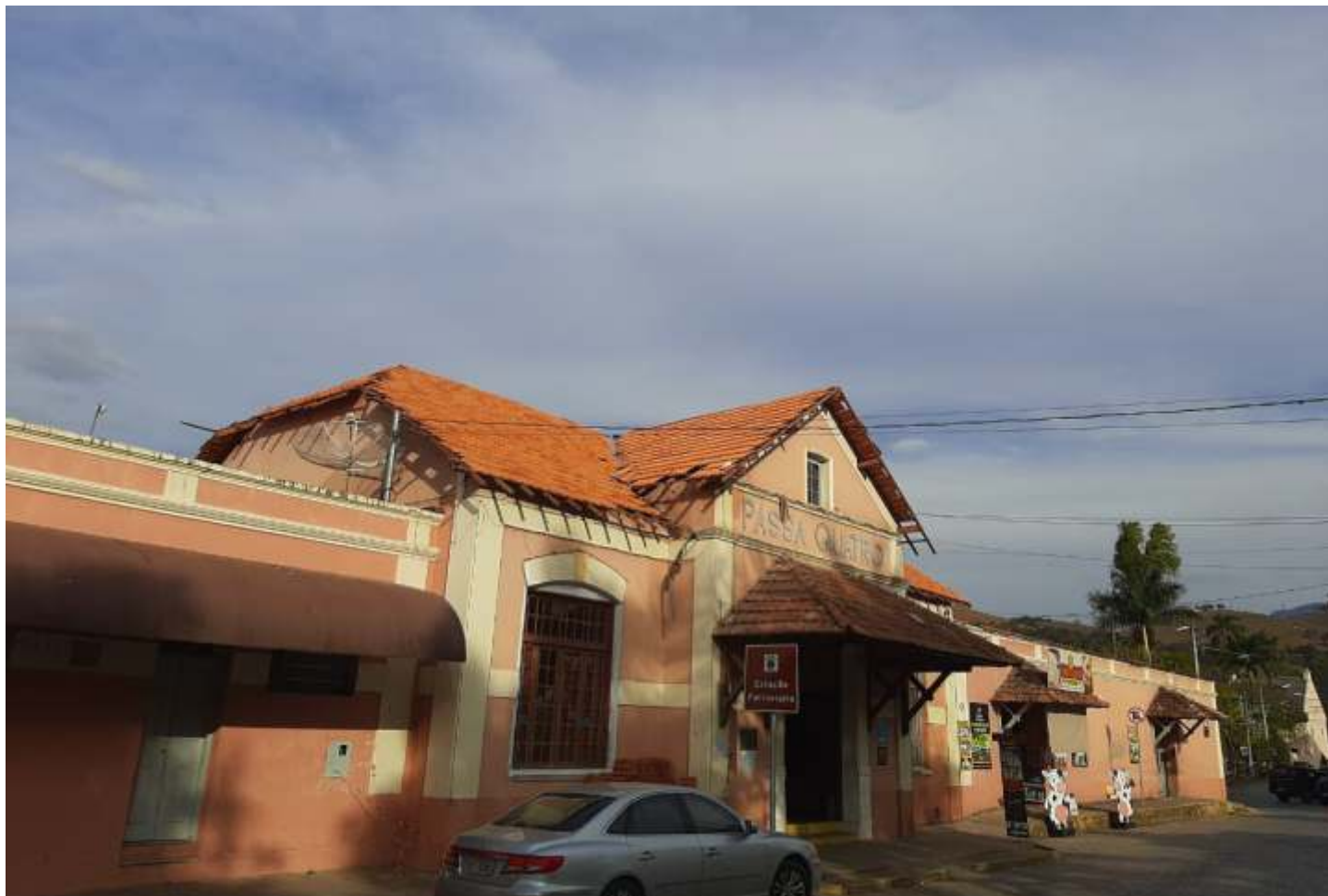
♦ O novo telhado em fase final de montagem.
