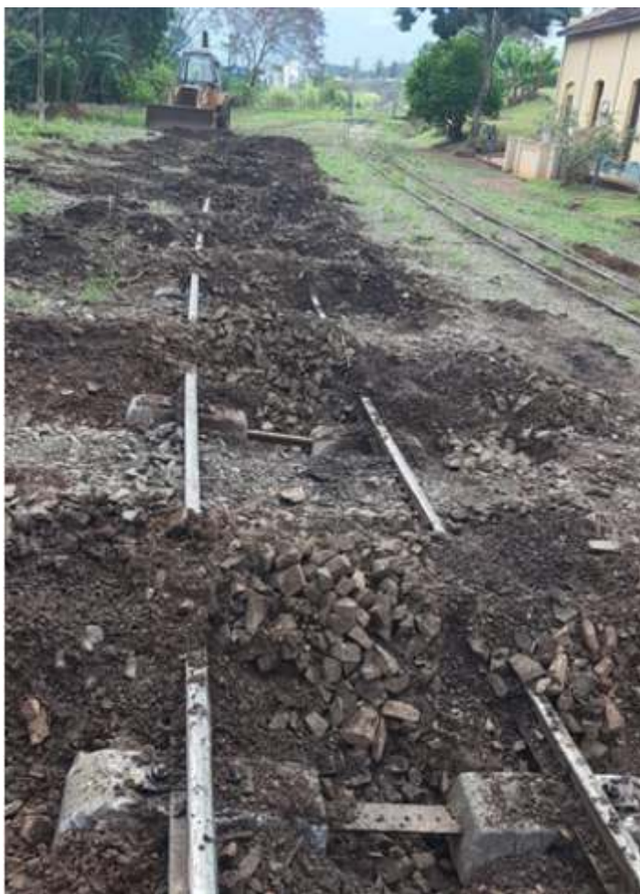
♦ Substituição de dormentes com ajuda da retro escavadeira.
