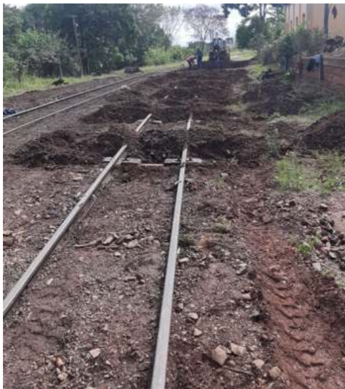
◆ Substituição de dormentes no pátio de Anhumas – Foto de Márcio Silva
