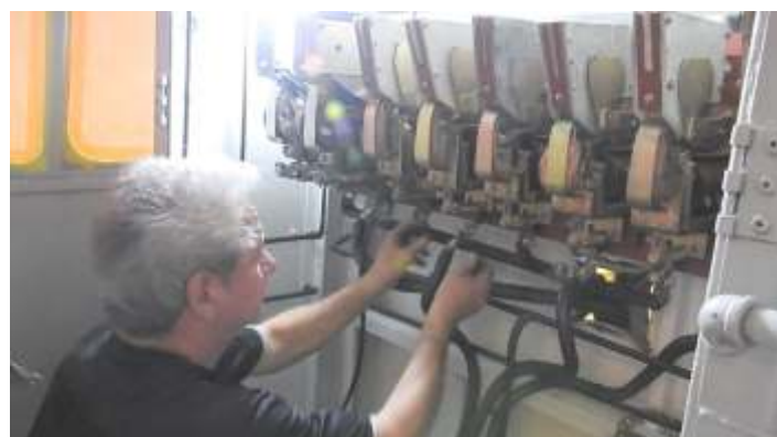
◆ Detalhe do painel sendo montado pelo Eletricista Leonel Martins.
