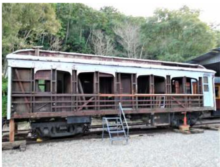
♦ Carro AM6 ao finalizar do dia 27 de agosto, já com a parte superior do caixilho das janelas recolocadas. Autoria de Luiz Carlos Henkels.
