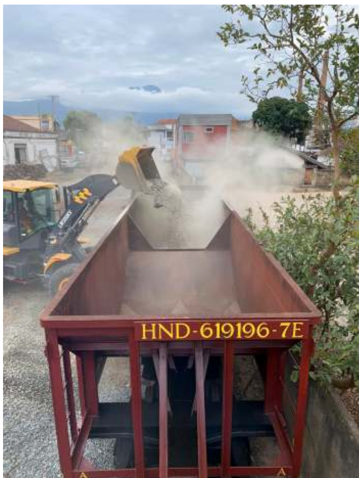
♦ Primeiro carregamento do vagão hopper com lastro.
