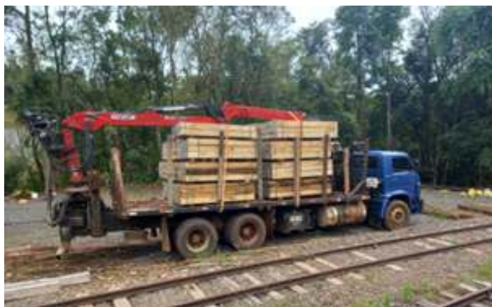
♦ Recebimento do lote de dormentes novos para substituição na via permanente
