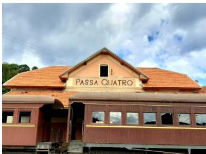
♦ Novo telhado da estação de Passa Quatro.
