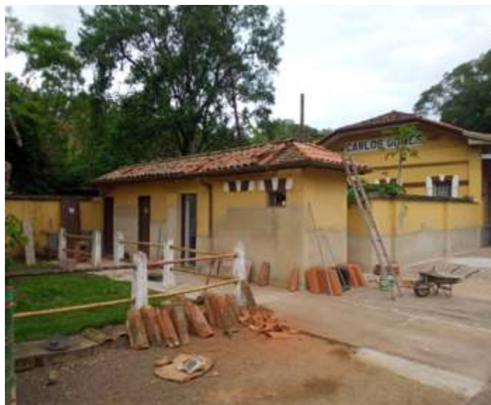
♦ Reforma geral dos sanitários da estação Carlos Gomes. Foto HGF.
