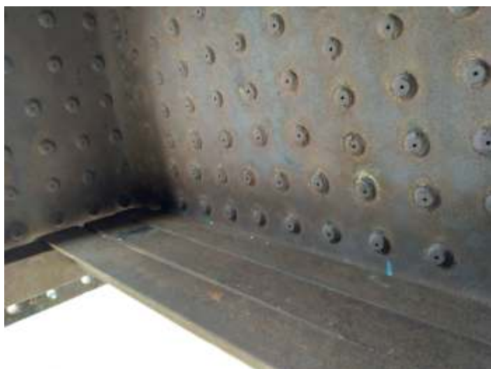
♦ Construção de nova grelha.
