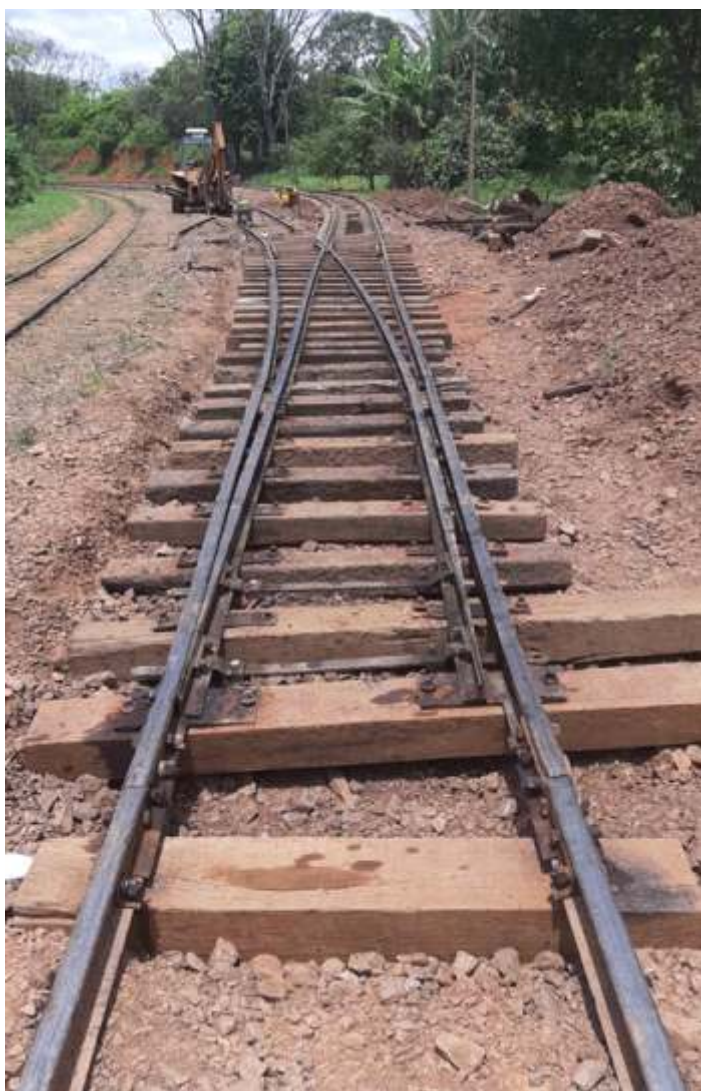
♦ O mesmo AMV em instalação no local onde era na época Mogiana. Foto Márcio Silva.
