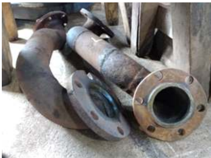
♦ Remoção dos tubos condutores de vapor.
