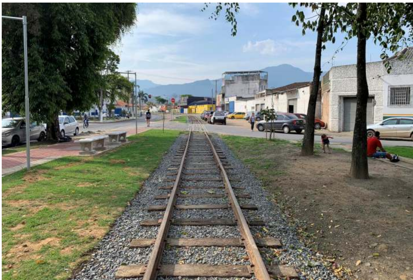
♦ Aspectos do antes e depois dos trabalhos de recuperação da via no km 0+400.
