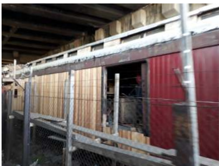
♦ Trabalhos no carro bagageiro nº 1032 ex. SPR.
