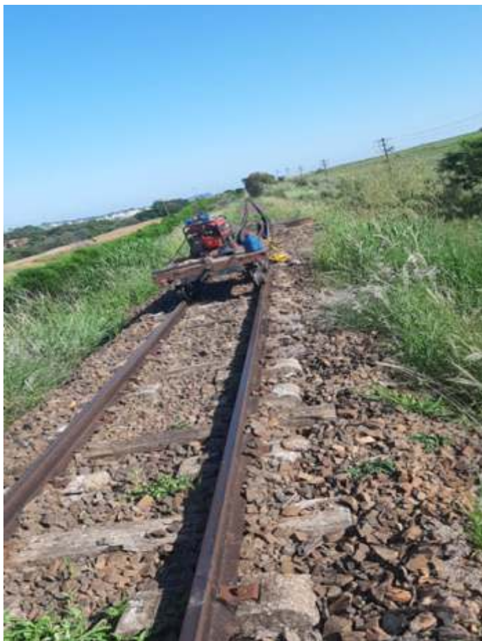
◆ Reparos na via, correção do nivelamento. Foto de Márcio Silva.
