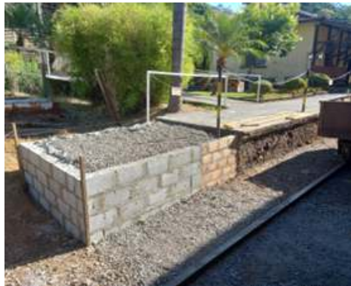
♦ Obras de extensão da plataforma da estação de Piratuba.
