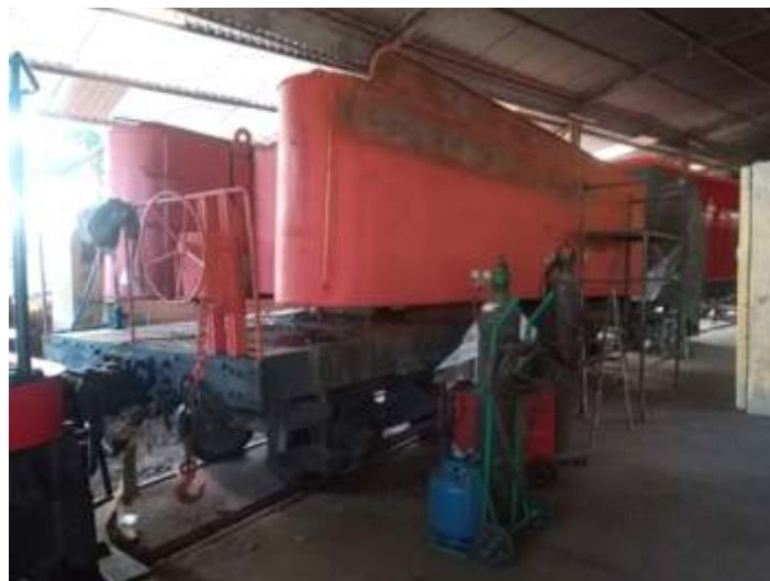
◆ Pequenos consertos antes de receber nova pintura. – Foto HGF
