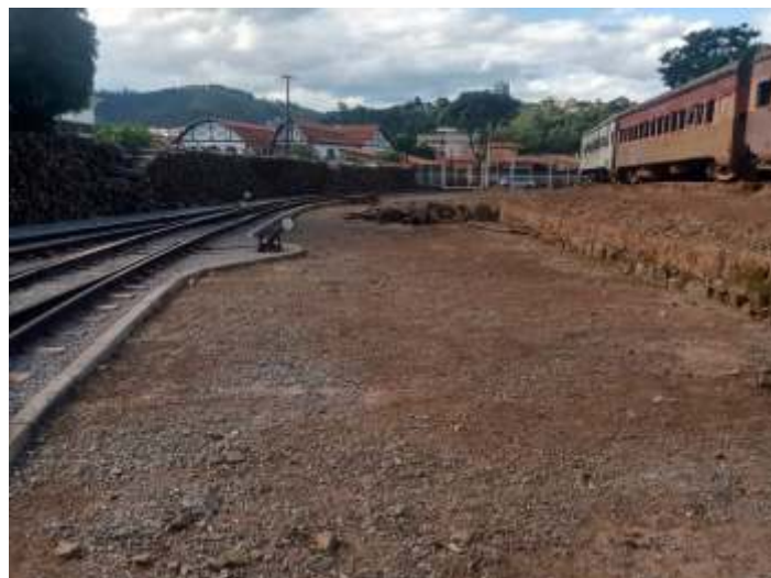
♦ Serviço de limpeza no pátio de São Lourenço.
