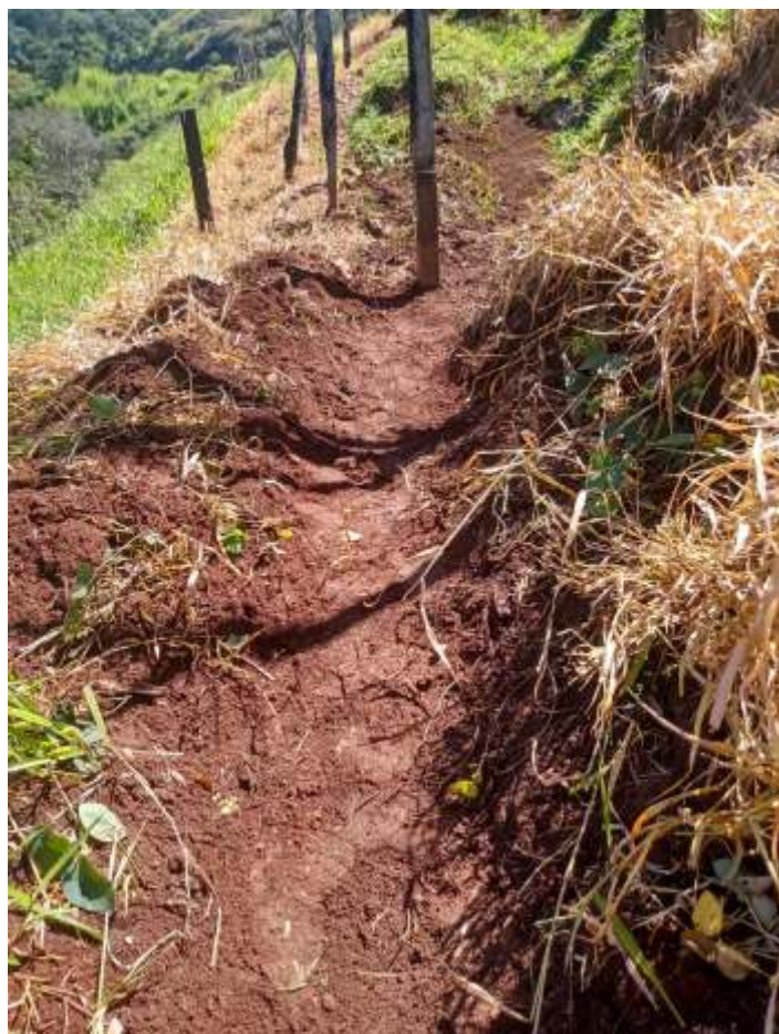
♦ Limpeza e melhorias no sistema de captação de água.
