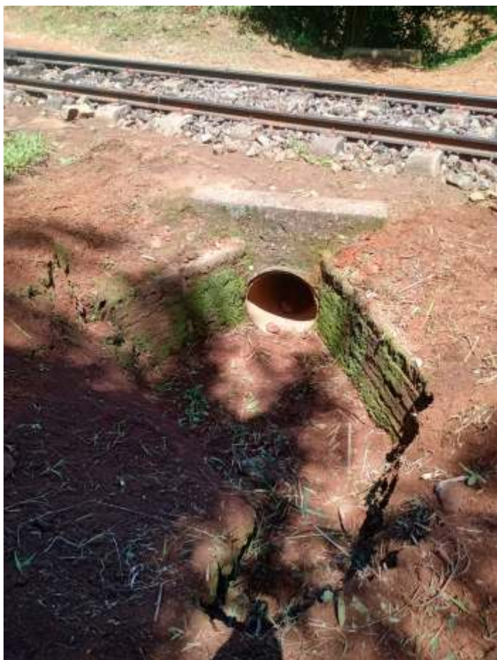
♦ Sistema de drenagem passou por limpeza.
