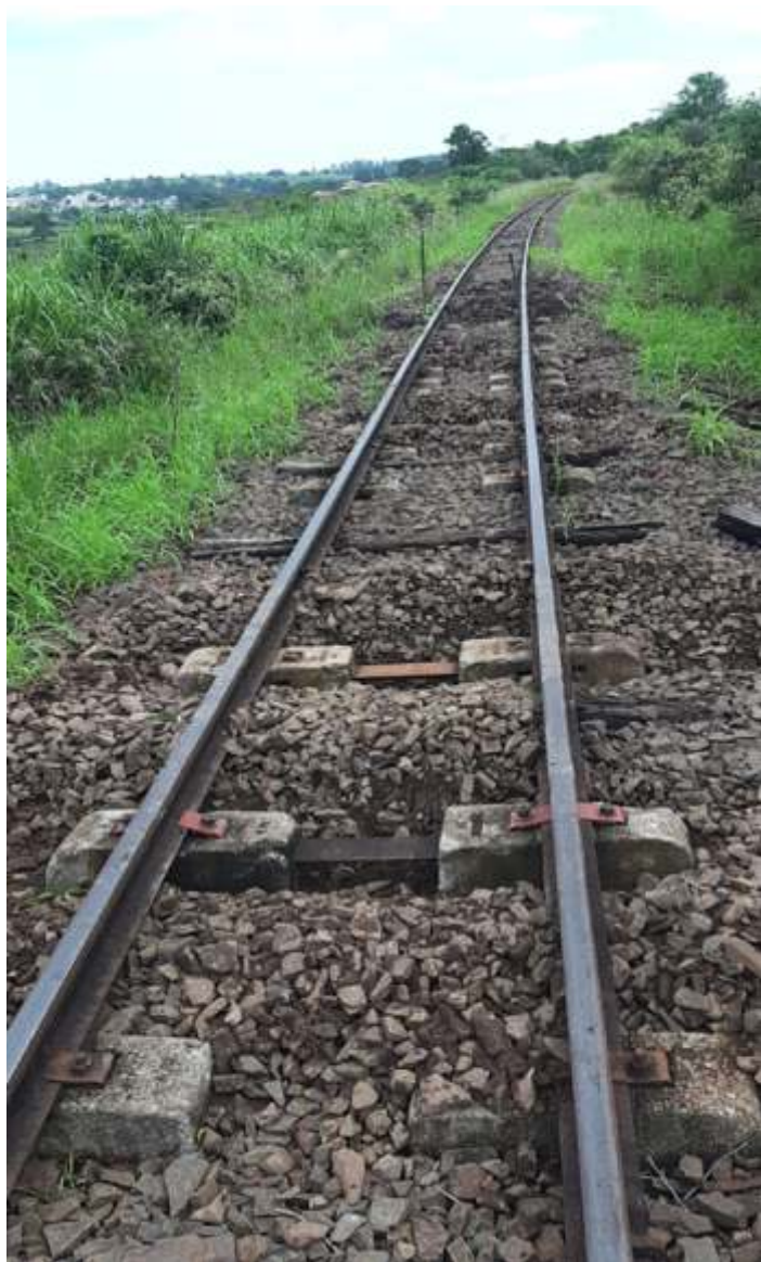
♦ Substituição dos velhos dormentes de madeira por concreto. Foto de Márcio Silva.
