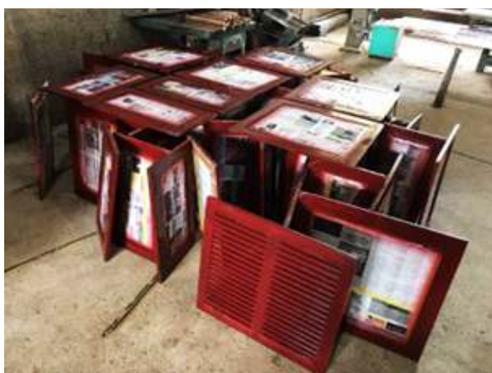
♦ Pintura dos caixilhos de janela, portas e acabamentos internos.
