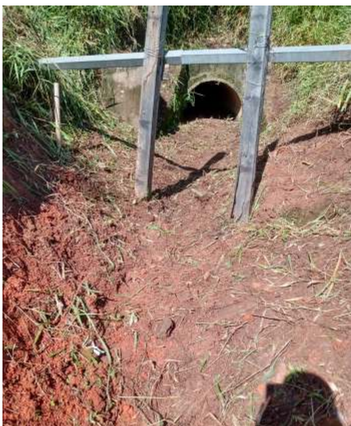
◆ Serviço de capina e limpeza do sistema de drenagem.
