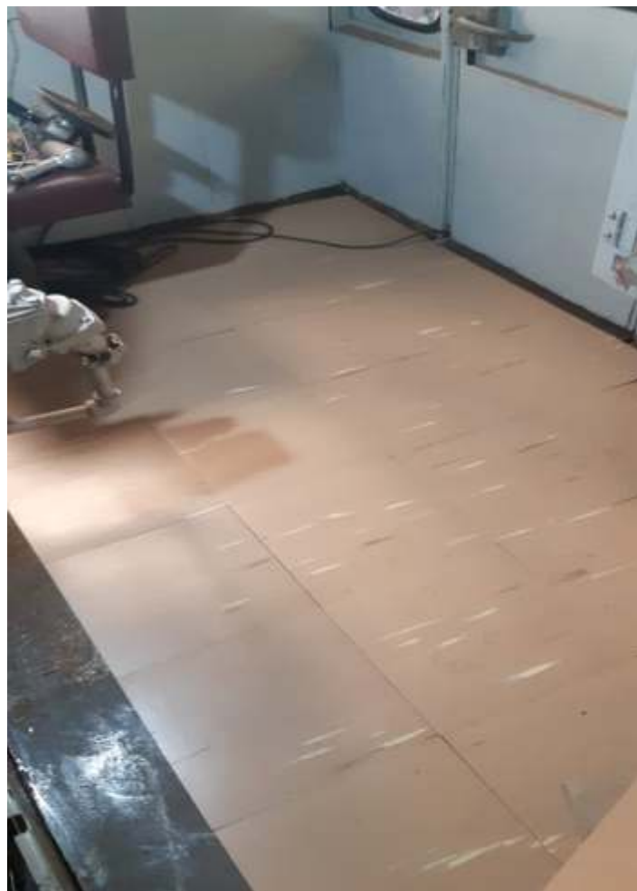
♦ Novo piso assentado na cabina da 3104. Foto de André Luis.
