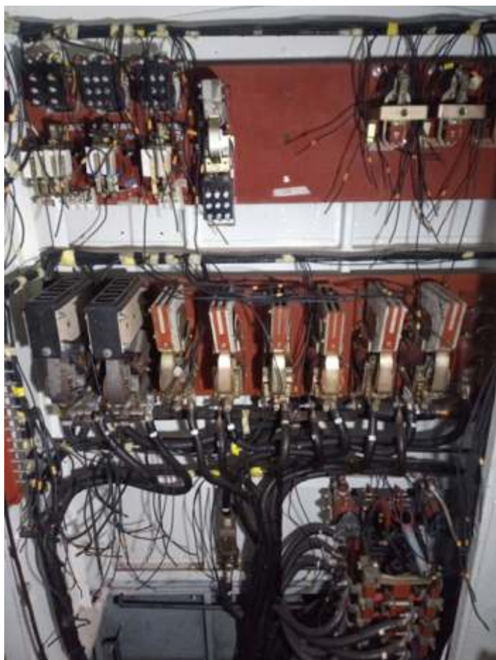
♦ Painel elétrico da 3104 em fase final de reconstrução. Foto H.G.F
