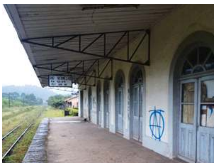
♦ Antes (em cima) e depois (em baixo) da limpeza da fachada na plataforma da Estação Ferroviária de Rio Vermelho.
