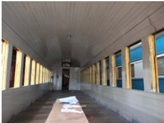
♦ Aspecto interior do carro de passageiros PD-42, após a pintura.
