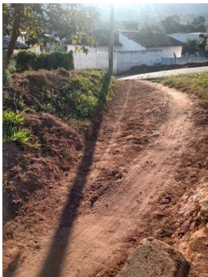
◆ Serviço de capina e limpeza do sistema de drenagem.
