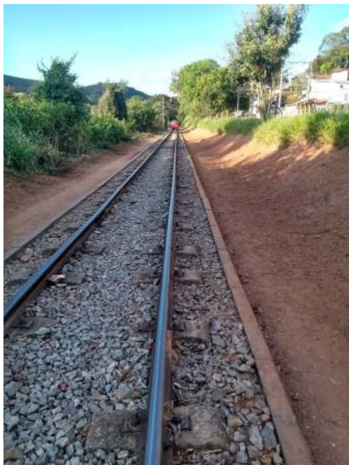
◆ Serviço de capina e limpeza da faixa de domínio.
