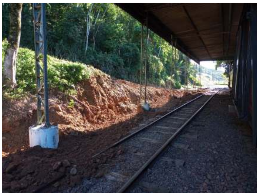
♦ Desbaste e ajuste de barranco lateral à gare. Autoria das fotos: Otávio Georg Junior.
