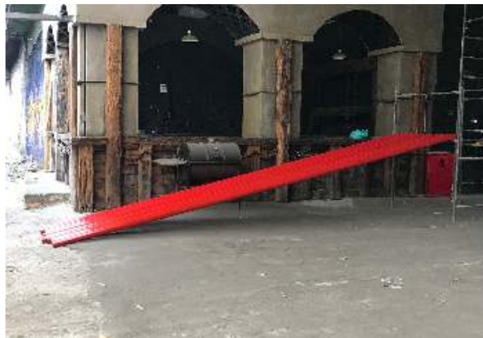
♦ Tubos preparados para instalação do sistema de combate a incêndio nas dependências da ABPF na Mooca.
