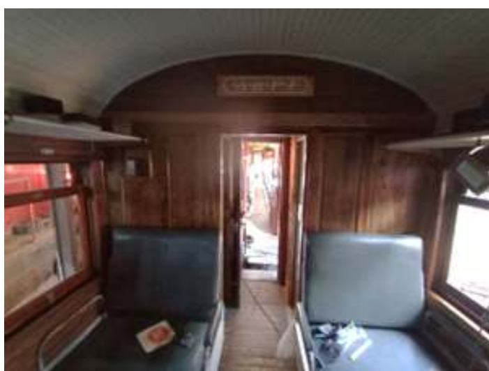
♦ Divisórias do banheiro e depósito já finalizadas no carro de passageiros PD-44.
