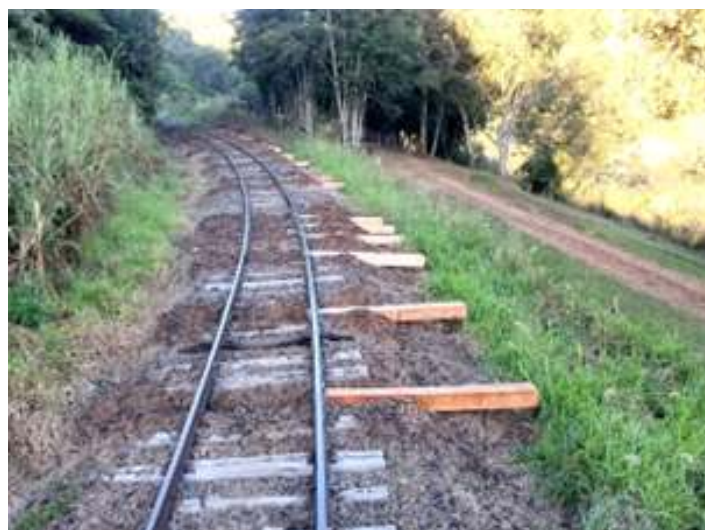
♦ Compra de dormentes e aplicação na via permanente.
