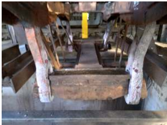
♦ Desmontagem e revisão dos truques do carro de passageiros PC-50.
