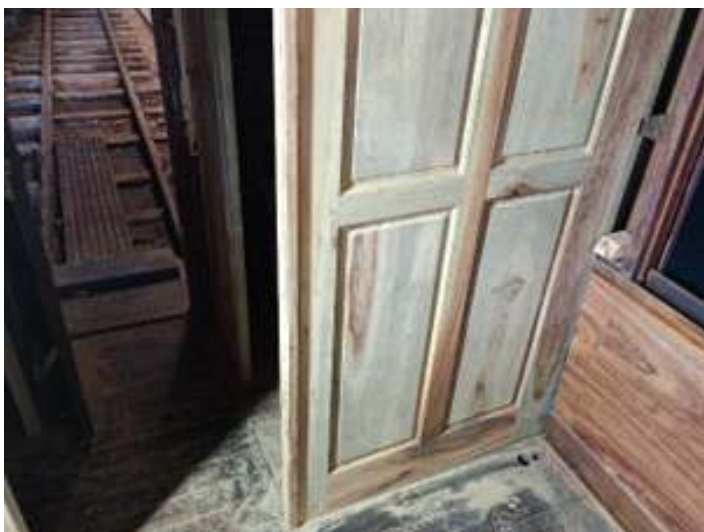
♦ Novas divisórias do banheiro e depósito parcialmente instaladas no carro de passageiros PD-44.
