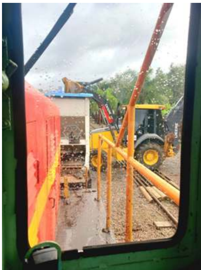
♦ Carregamento de dormentes e pedras de lastro para a via permanente.
