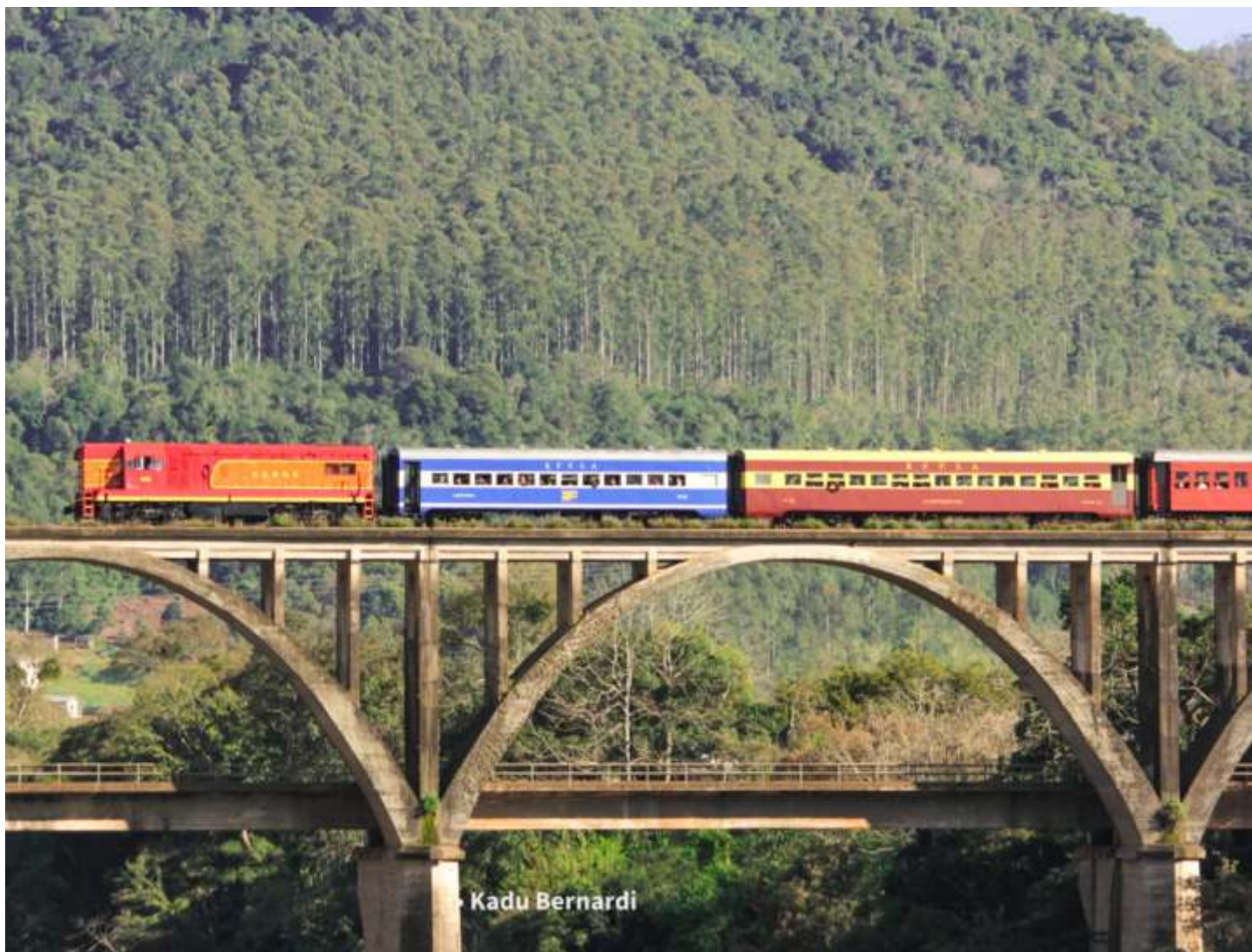
♦ Passagem da composição sobre o viaduto Brochado da Rocha, em Muçum-RS. Foto: Kadu Bernardi.
