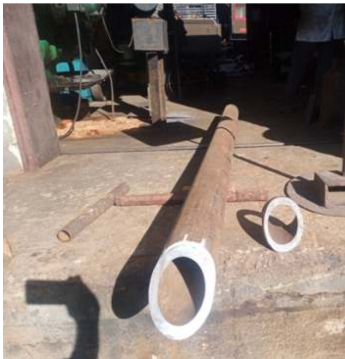
♦ Fabricação de novo condutor da 215. Foto HGF.
