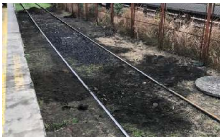
♦ Aspecto da via após a troca dos dormentes.
