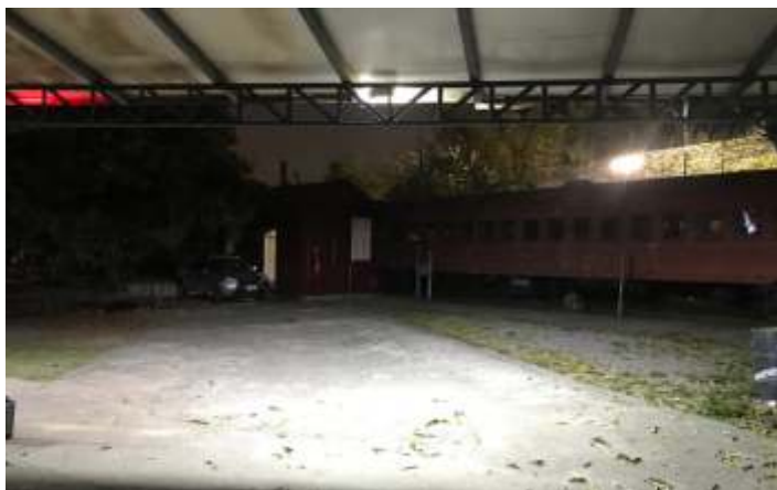
♦ Novos pontos de iluminação instalados no pátio.
