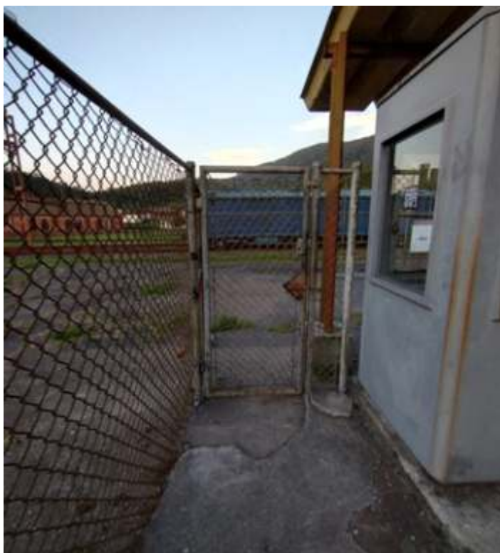
♦ Serviço de reparação do portão de acesso.
