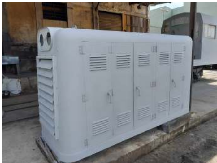
♦ O capô já preparado para receber a nova pintura.
