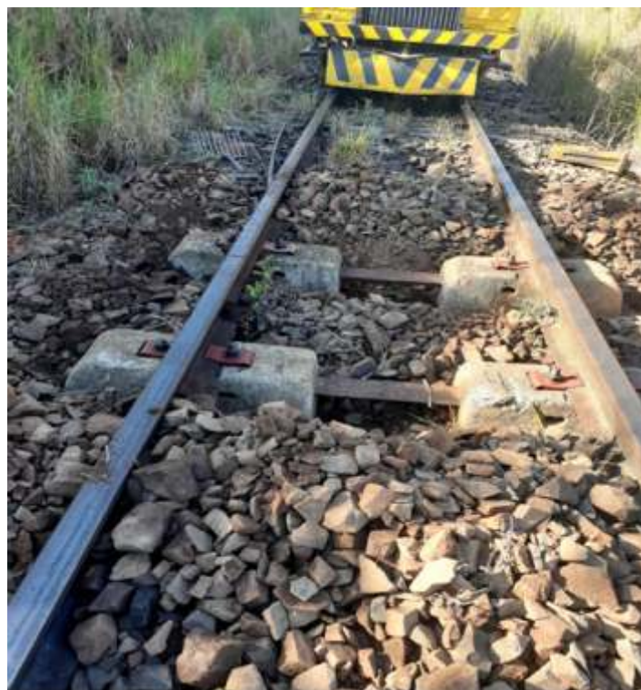
♦ Substituição de dormentes. Foto Edvaldo S. Silva.
