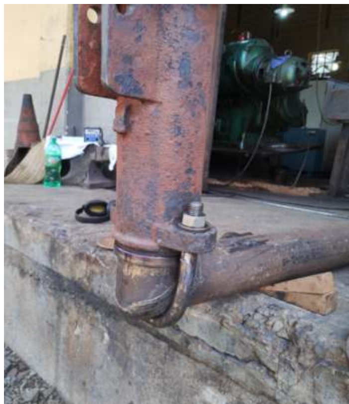
♦ Detalhe da montagem do novo tubo condutor. Foto Vanderlei Zago.
