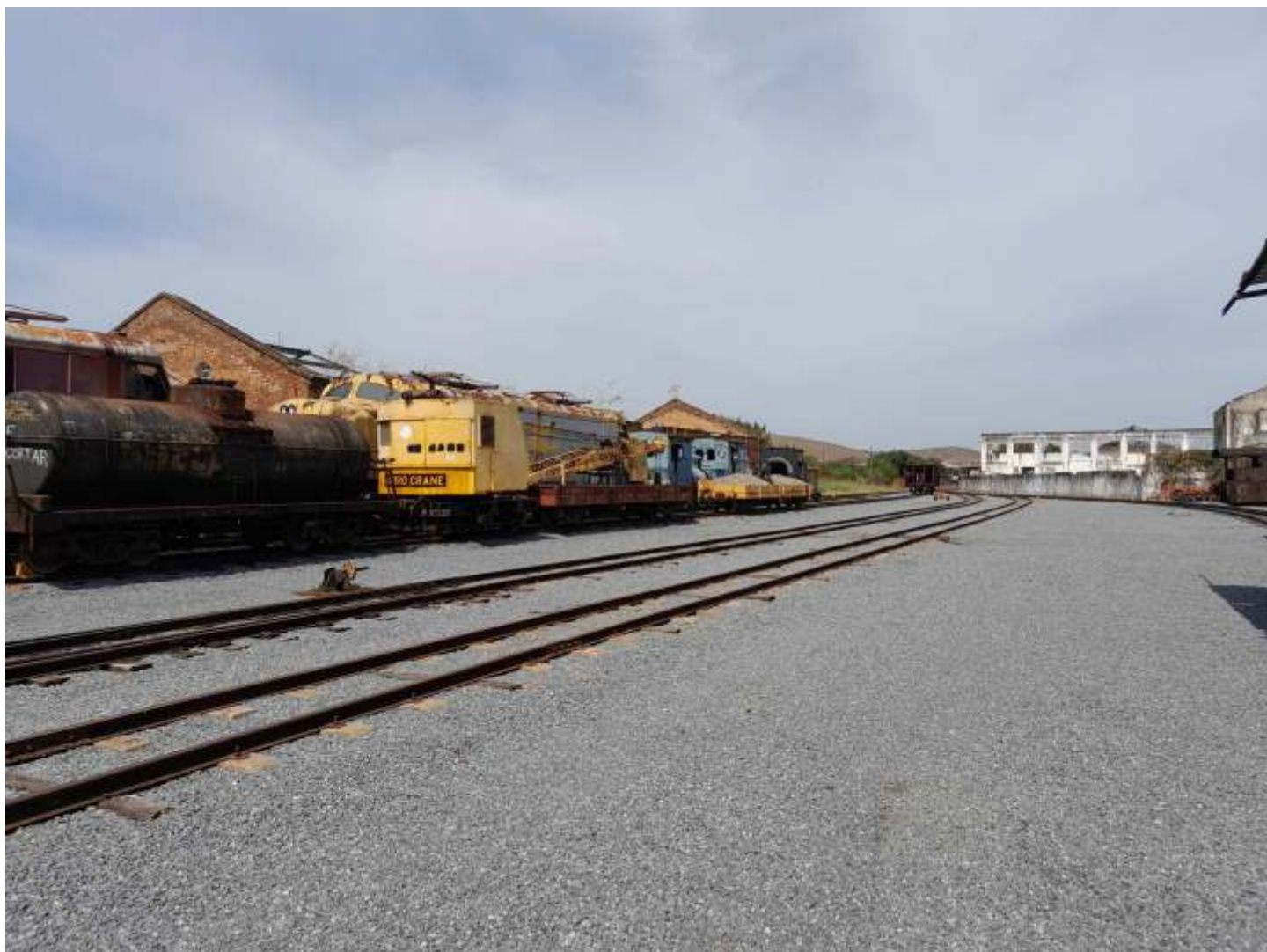
♦ Vista geral do pátio de Cruzeiro após conclusão dos trabalhos de limpeza, organização e aplicação de lastro.
