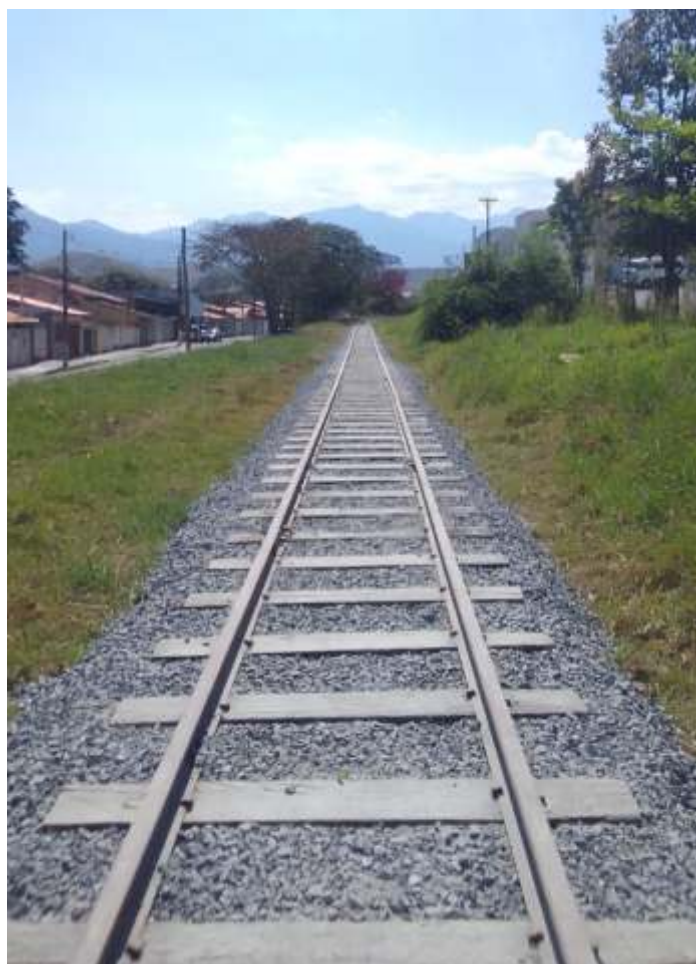
◆ Aplicação de lastro ao longo do km 1+800 e 1+900: aspecto do antes e depois da conclusão dos trabalhos.
