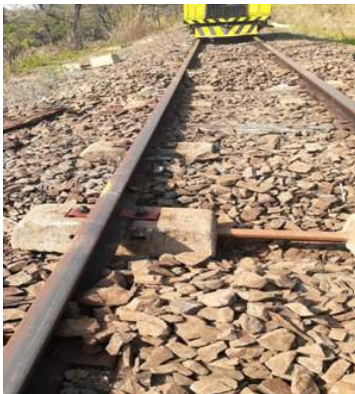
♦ Substituição de dormentes. Foto de Edvaldo S. Silva.
