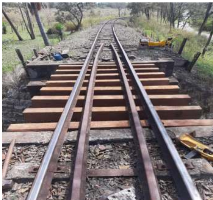
♦ Pontilhão com os novos dormentes sendo instalados. Foto Márcio Silva.
