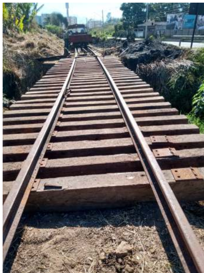
♦ Aspectos do antes e depois da troca dos dormentes da ponte no km 3+200, que agora permite o tráfego dos trens de VP.
