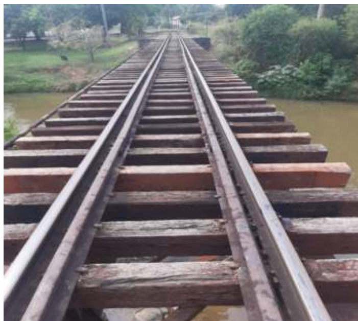
♦ Repregação dos contra trilhos na ponte do Rio Atibaia. Fotos de Márcio Silva.
