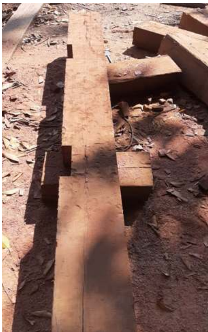
♦ Preparação de dormentes para ponte. Foto Marcio Silva.
