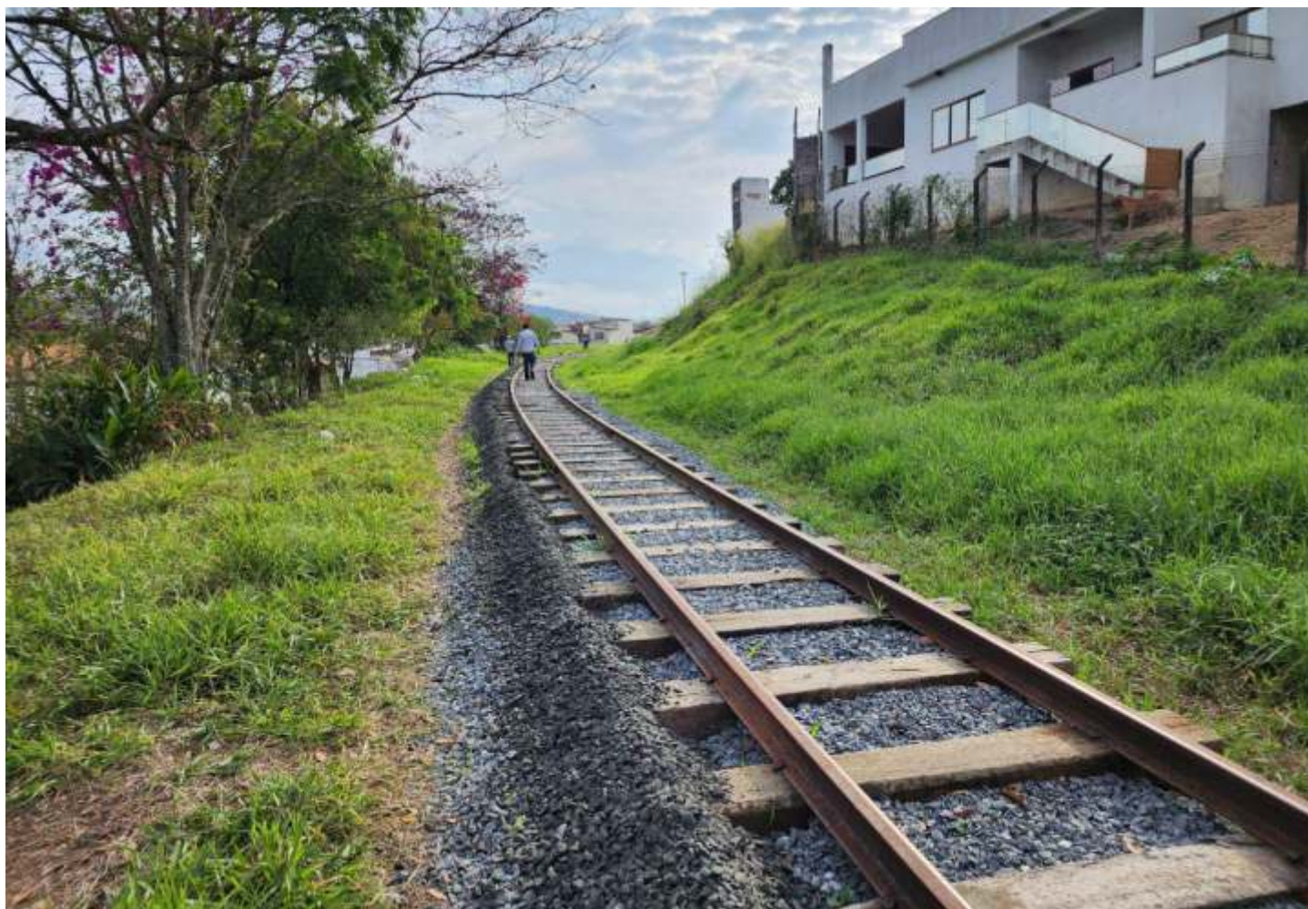
♦ Aspecto do km 1+800 durante a aplicação de lastro, feita com o nosso vagão hopper.
