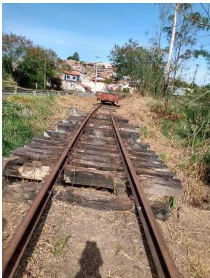
♦ Aspectos do antes e depois da troca dos dormentes da ponte no km 3+200, que agora permite o tráfego dos trens de VP.
