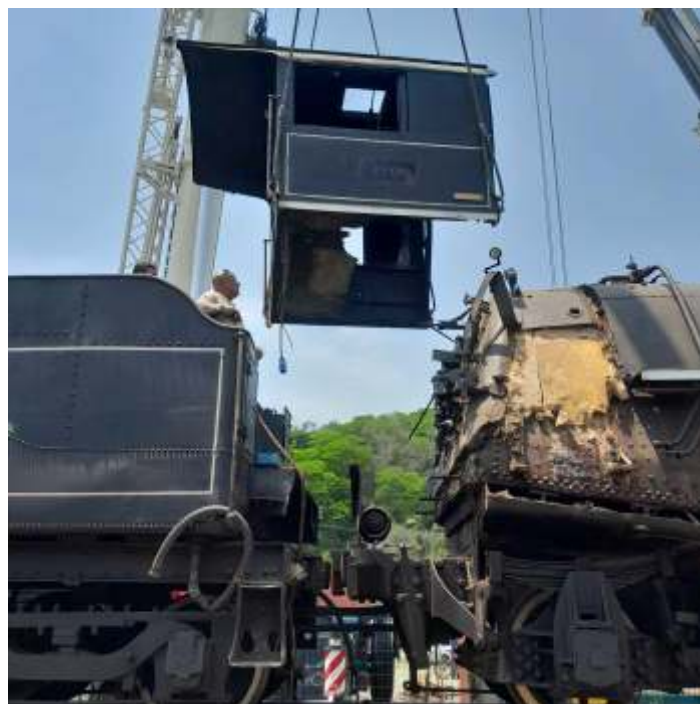
♦ Remoção da cabine.
