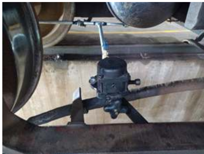
◆ Manutenção do expurgo da locomotiva Ten-Wheel #311.
