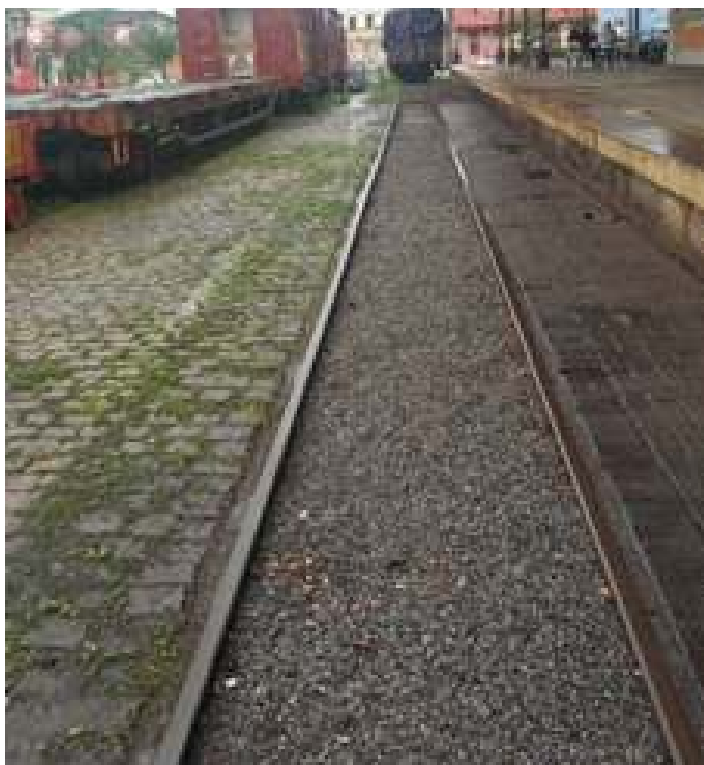
♦ Limpeza do pátio da estação ferroviária de Antonina.
