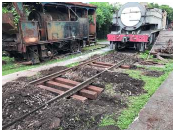
◆ Serviço de troca de dormentes da via-permanente.
