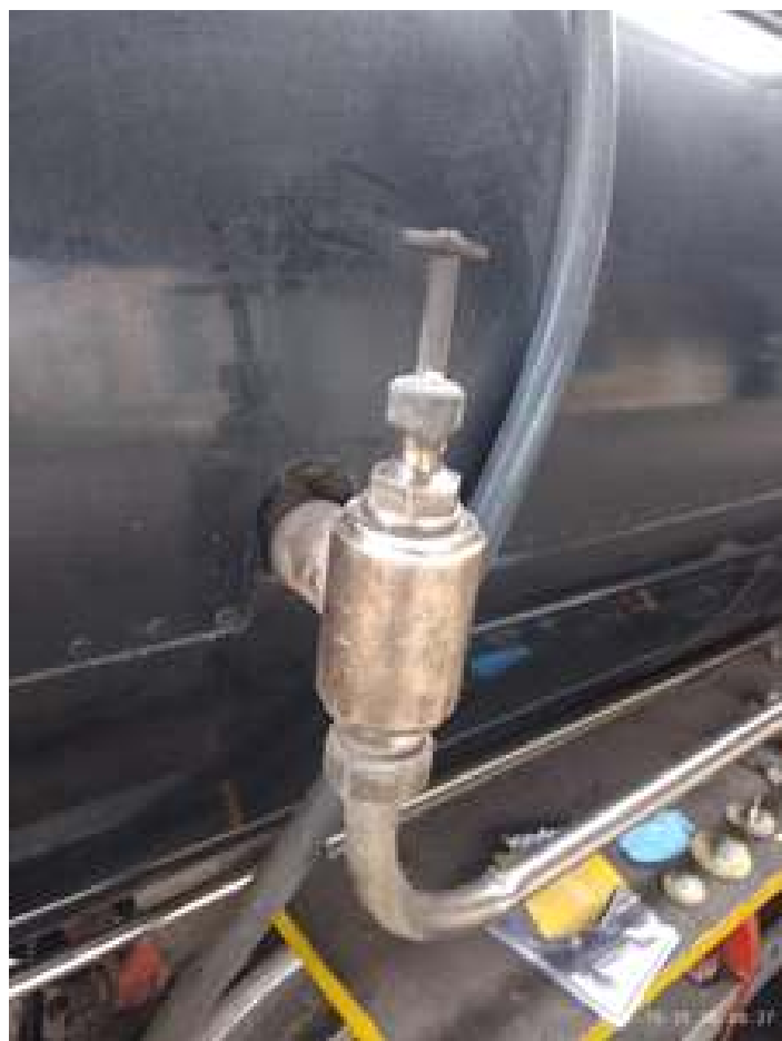
♦ Aspecto de Antes e Depois da limpeza e polimento da válvula de retenção do injetor juntamente com seu respectivo encanamento.
