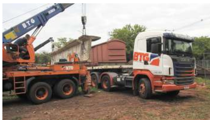
♦ Içamento de uma das longarinas, para desocupar área do futuro Museu ferroviário. Foto de Eric Gazetta.
