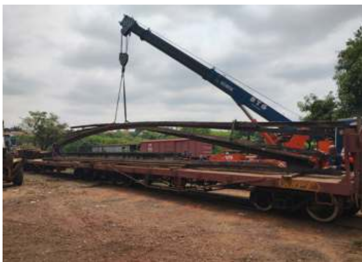
♦ Remoção de algumas barras de 18 metros de TR-45 - Foto HGF.
