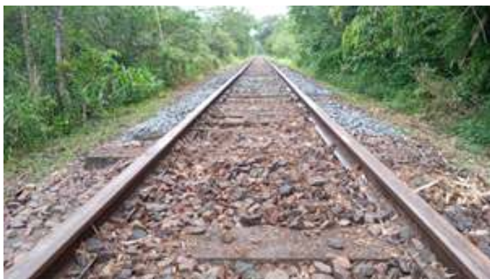
♦ Nivelamento da via permanente e encaixe de pedras.
