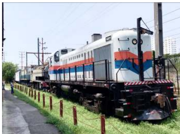
◆ Graças ao apoio da CPTM, foi possível movimentar o material rodante para que fosse possível realizar a troca de dormentes da via-permanente.
