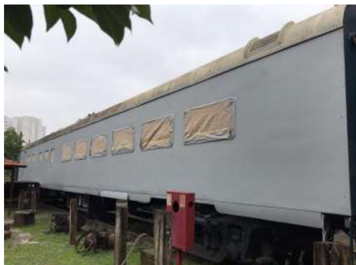
♦ Aplicação de Primer no carro de aço.
