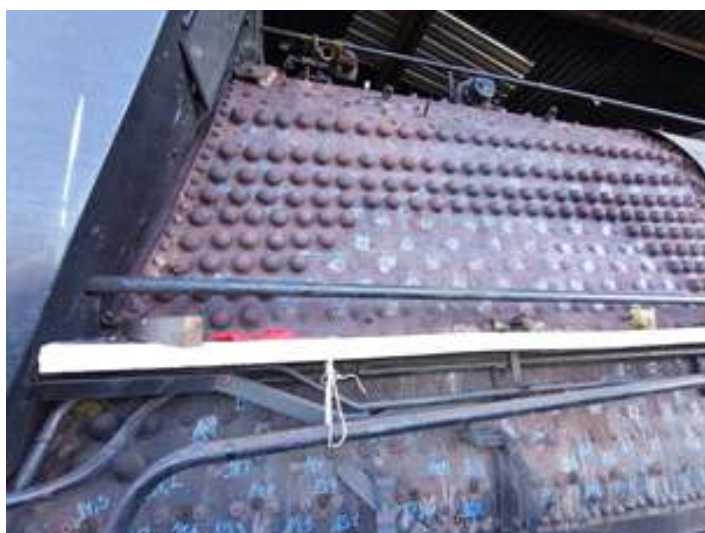
♦ Trabalhos de ultrassom na caldeira da locomotiva Mikado #761.
