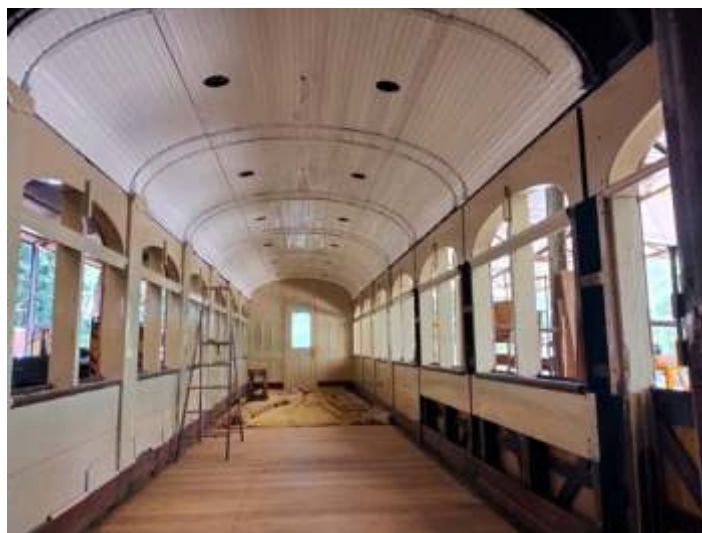
◆ Interior do carro NOB em restauração. Foto HGF.
