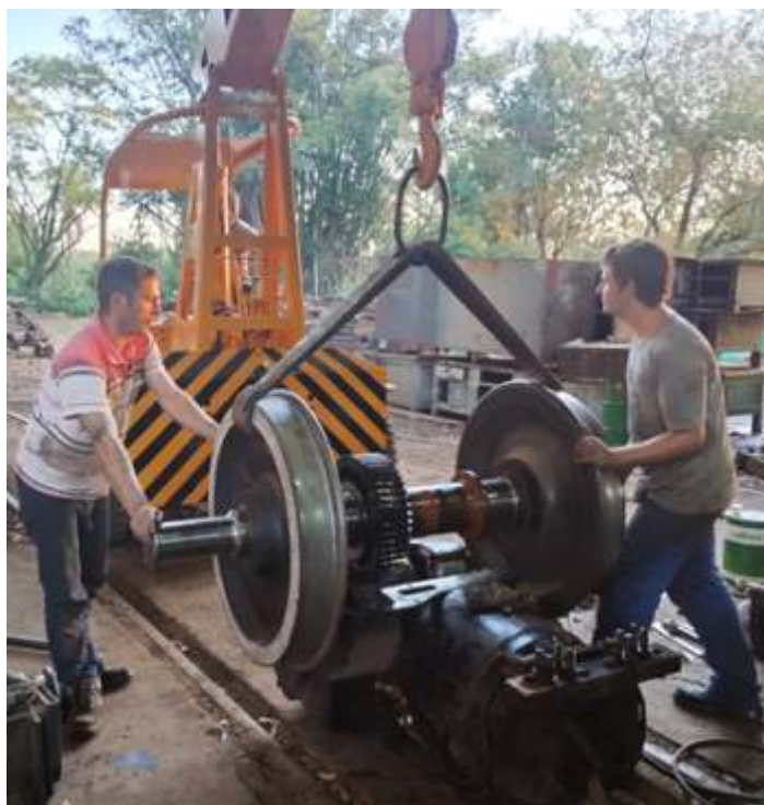
♦ Desmontagem de motores de tração da 3104. Foto HGF.
