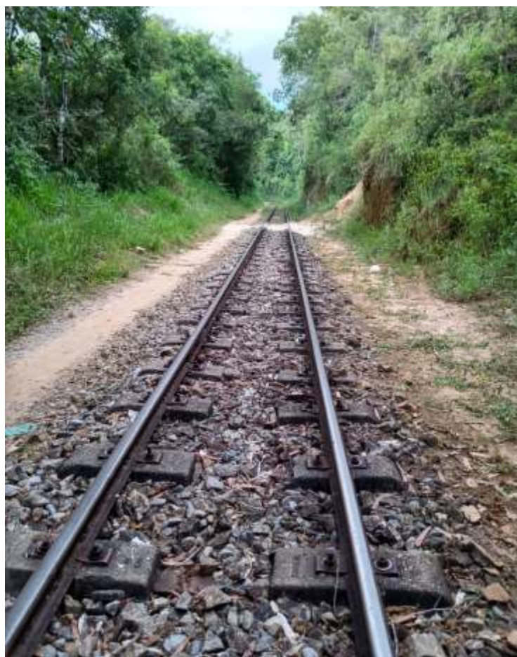
◆ Serviço de capina e limpeza da via.
