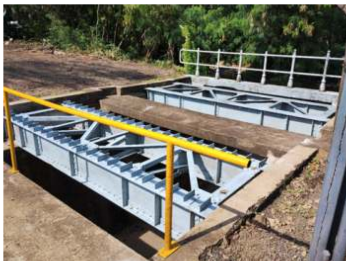
◆ Primeira fase da repintura dos pontilhões. Foto HGF.
