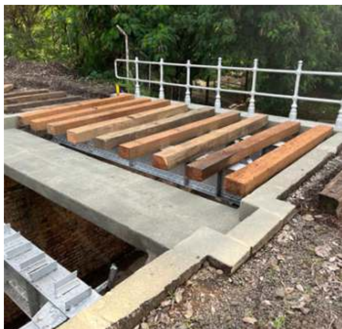
◆ Início colocação dos dormentes. Foto HGF
