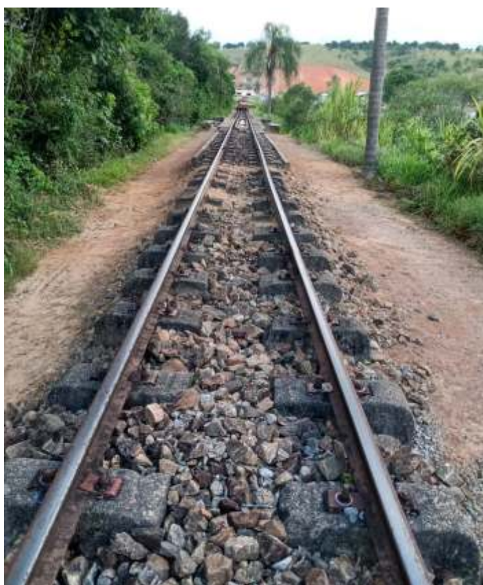
♦ Serviço de capina e limpeza da via.
