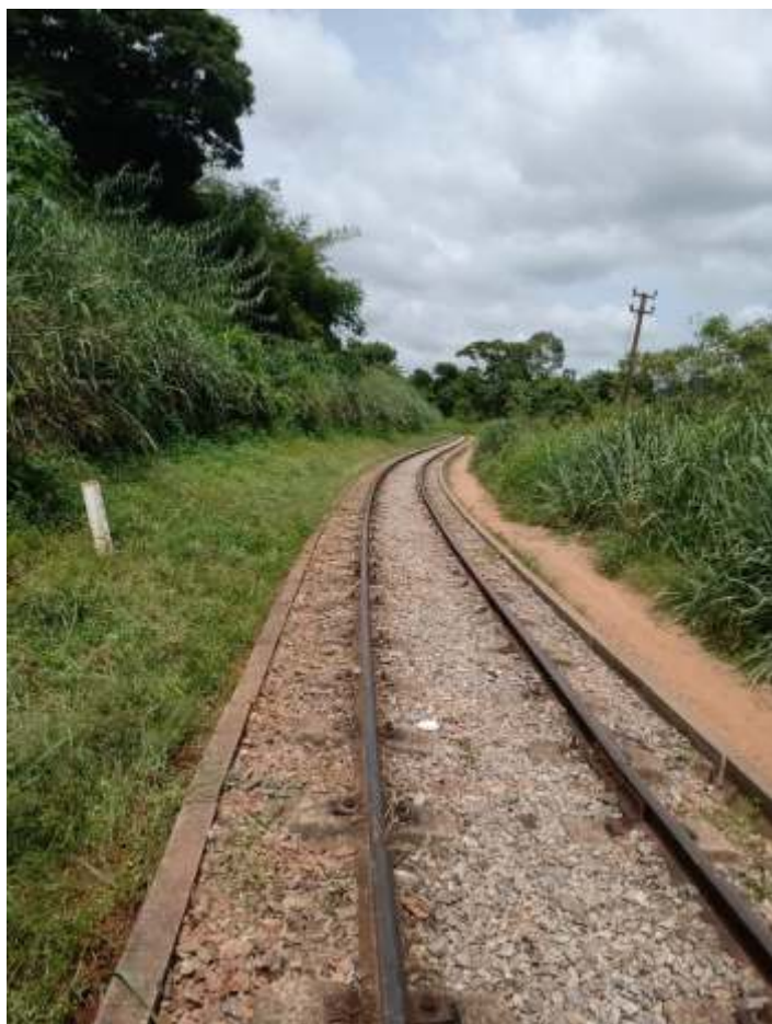
◆ Serviço de capina e limpeza da via.
