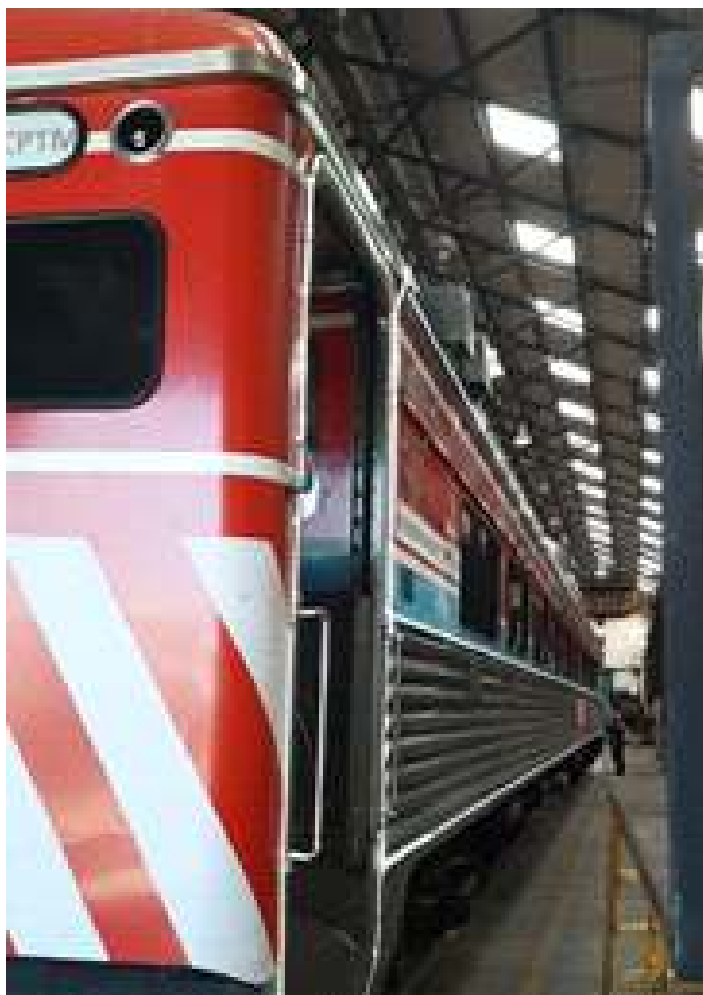
◆ Instalação dos LED's em andamento na Oficina Lapa da CPTM.
