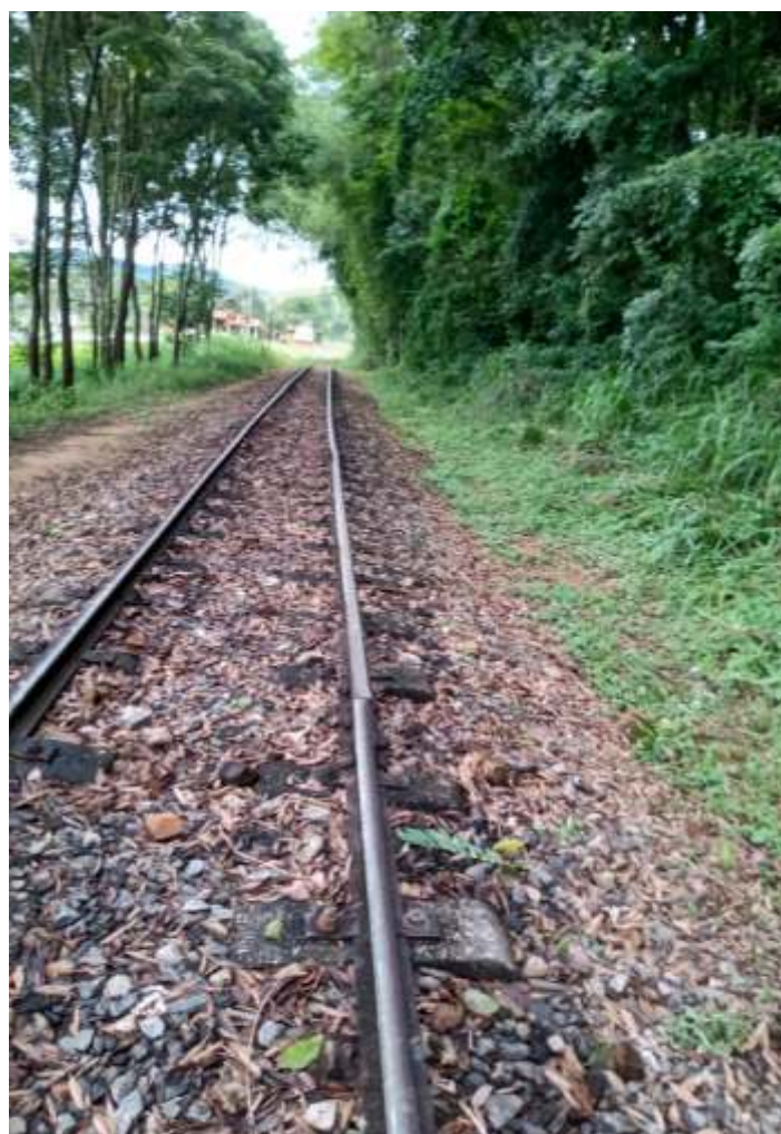
♦ Serviço de capina e limpeza da via.
