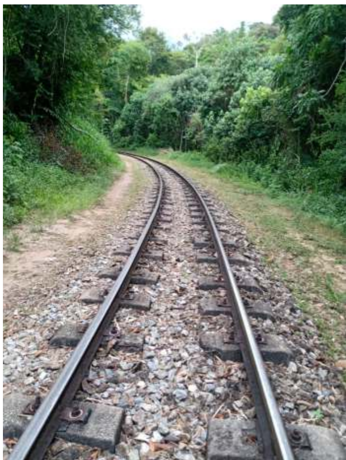
◆ Serviço de capina e limpeza da via.
