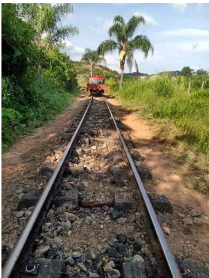
◆ Serviço de capina e limpeza da via.
