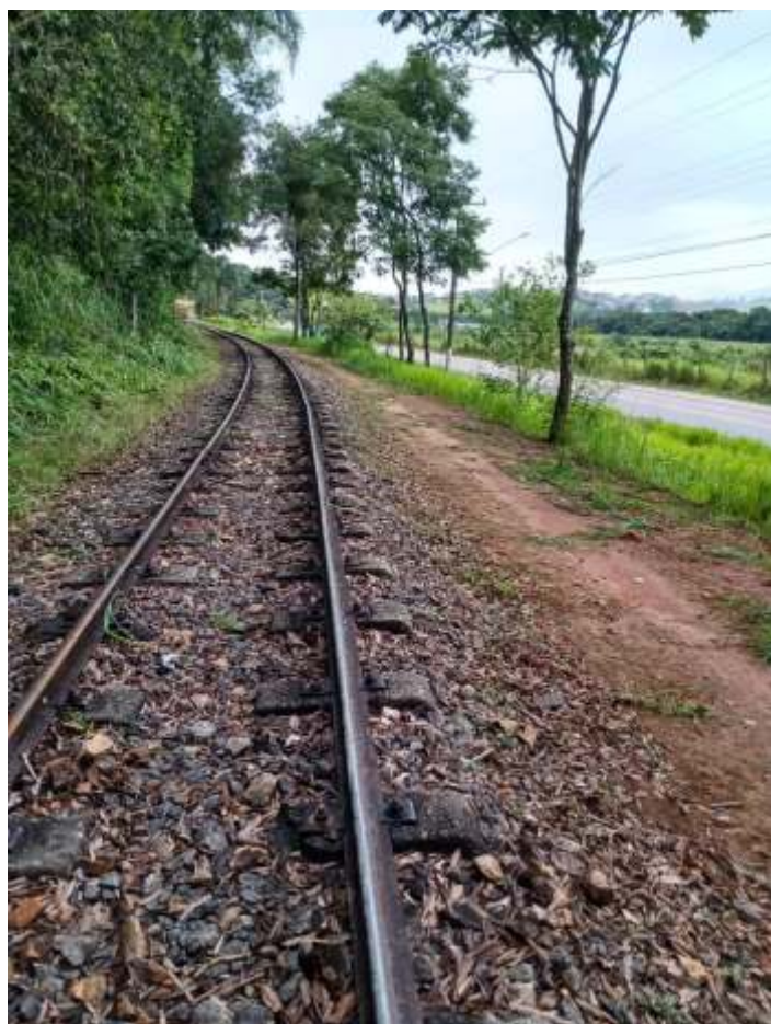
◆ Serviço de capina e limpeza da via.
