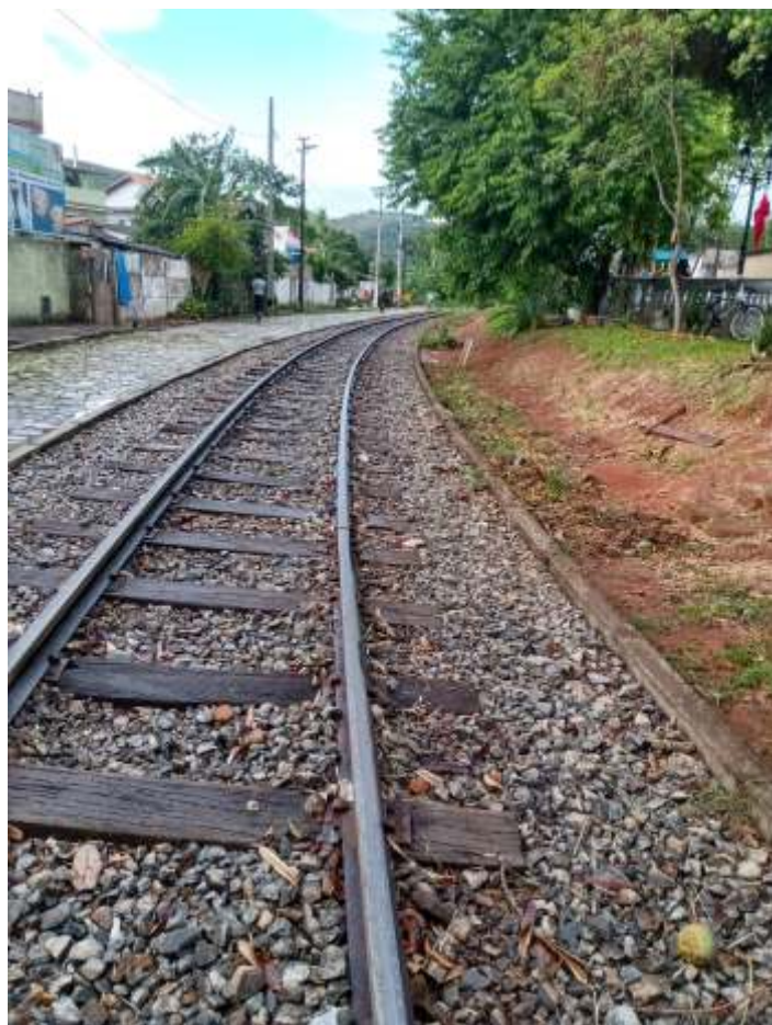
◆ Serviço de capina e limpeza da via.
