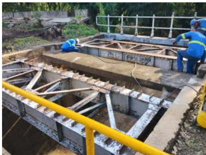
◆ Reforma das alvenarias e repintura das estruturas. Foto Eric Gazetta.
