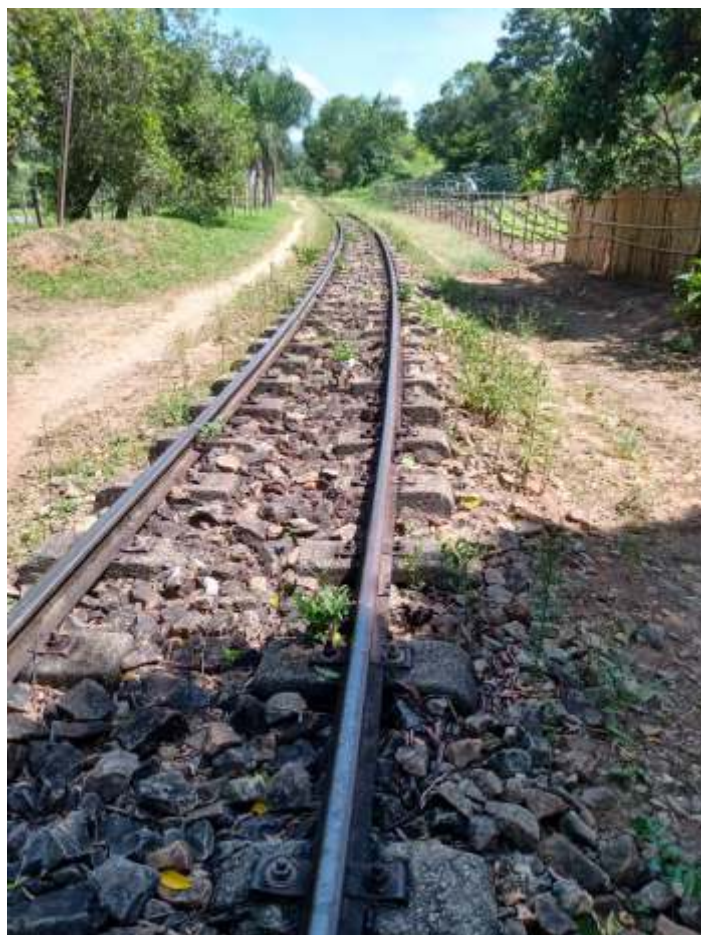
◆ Serviço de capina e limpeza da via.
