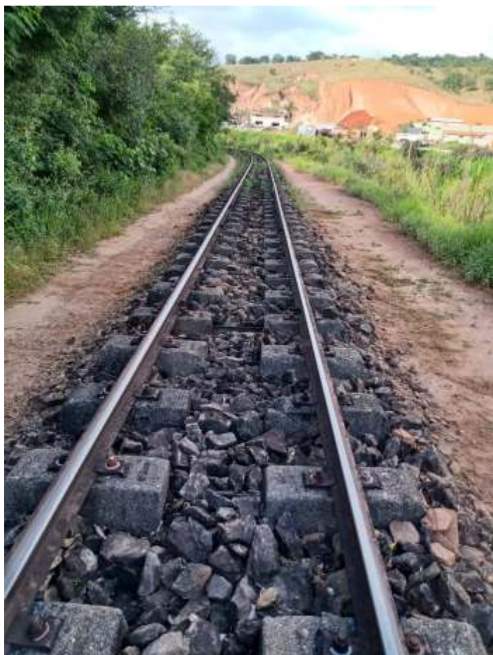
◆ Serviço de capina e limpeza da via.
