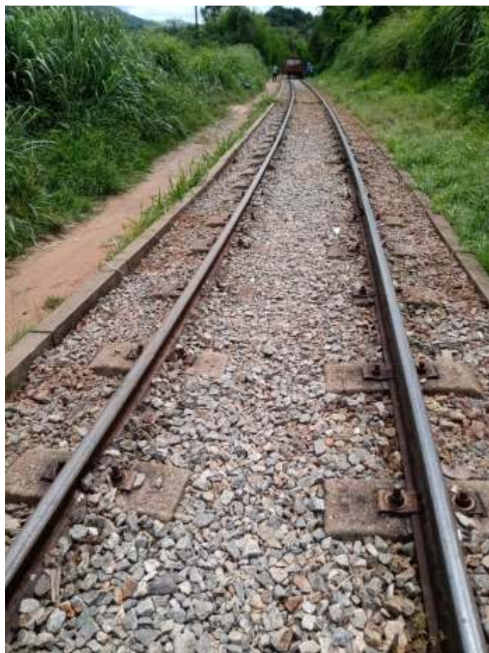
◆ Serviço de capina e limpeza da via.
