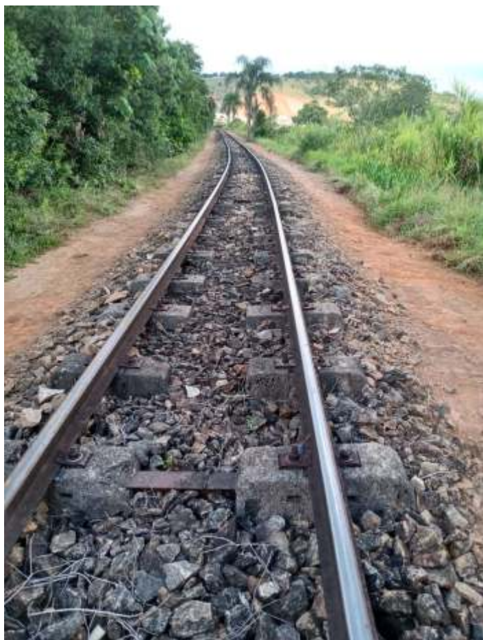
◆ Serviço de capina e limpeza da via.
