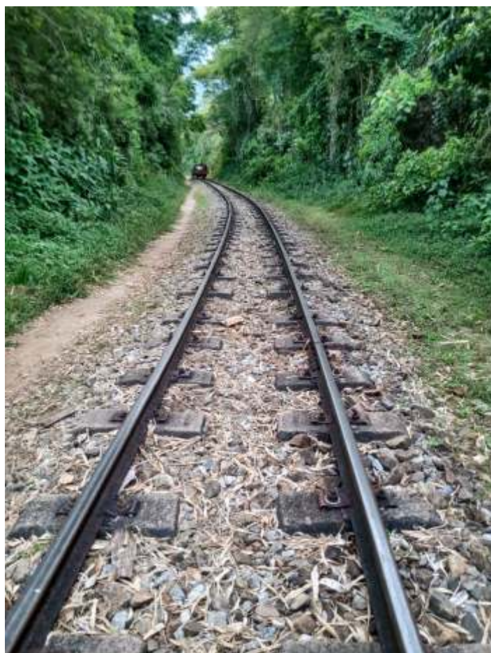
◆ Serviço de capina e limpeza da via.
