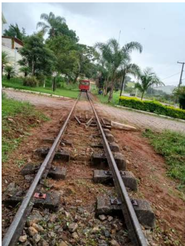
◆ Serviço de capina e limpeza da via.
