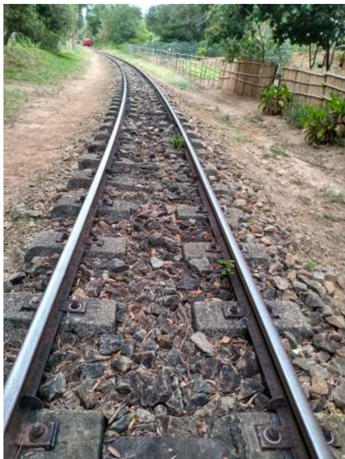
◆ Serviço de capina e limpeza da via.
