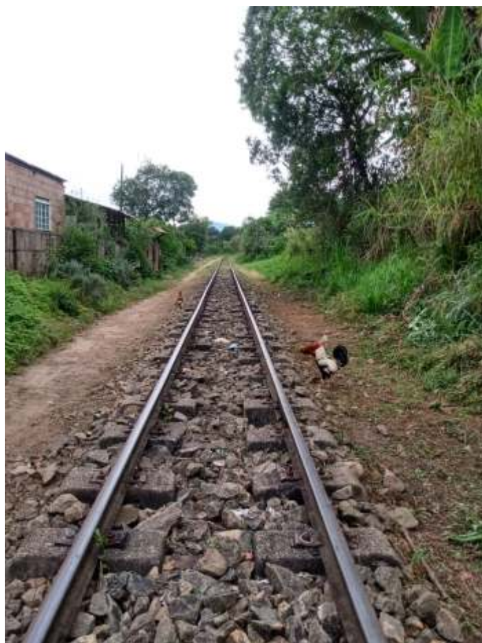
◆ Serviço de capina e limpeza da via.
