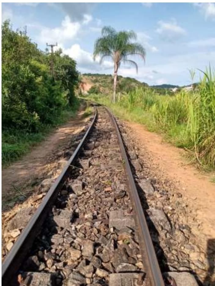
◆ Serviço de capina e limpeza da via.
