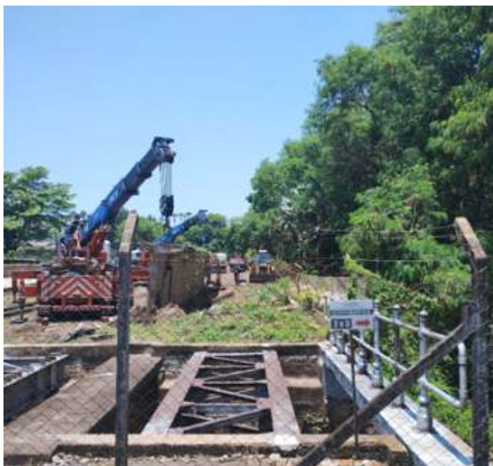
◆ Retirada das longarinas do local do prolongamento das linhas. Foto HGF.
