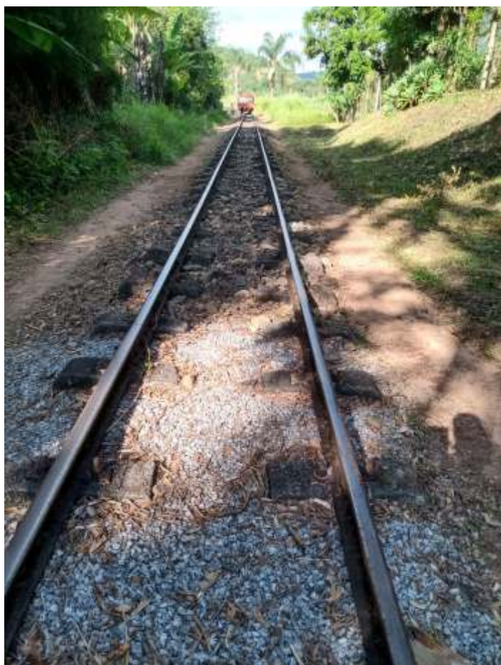
◆ Serviço de capina e limpeza da via.
