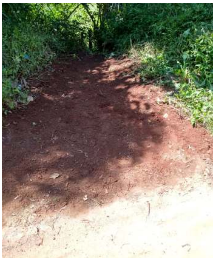
◆ Serviço de limpeza do sistema de drenagem da via.
