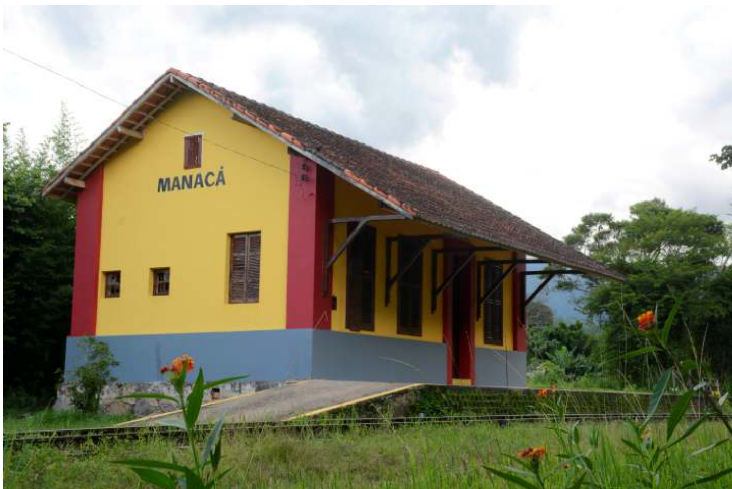
♦ Aspecto da estação Manacá após a conclusão do serviço de pintura.
