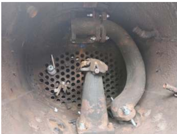
◆ Caixa de fumaça da 215 sendo remontada após troca do tubo condutor.
