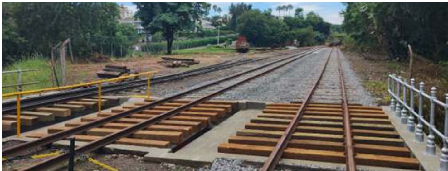
◆ Dois novos desvios do futuro Museu Ferroviário de Campinas. Foto HGF
