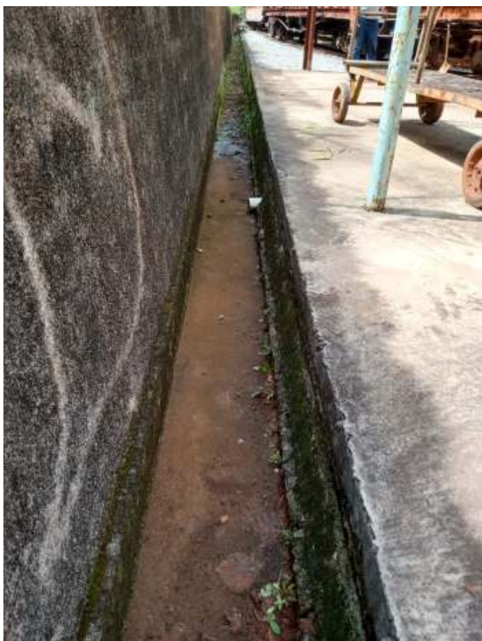
◆ Serviço de limpeza do sistema de drenagem do pátio.
