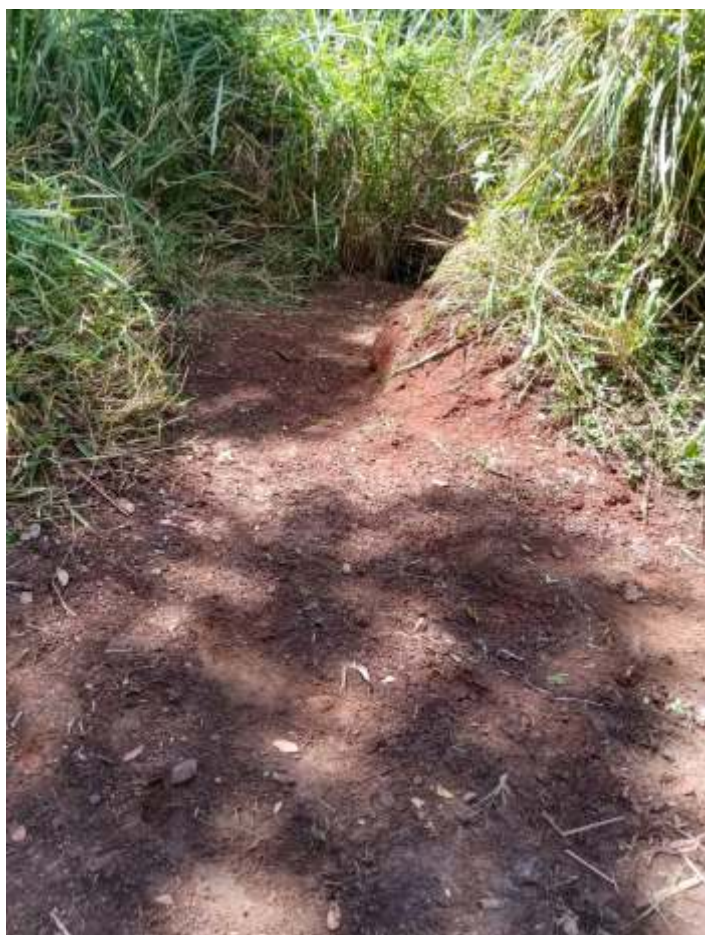
◆ Serviço de limpeza do sistema de drenagem da via.
