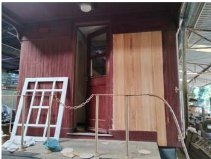
◆ Carro CA-18 já em repintura e reparos nas oficinas. Foto: HGF.
