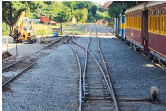
♦ Novo AMV instalado para acesso a linha 2 sentido Guanabara – Foto HGF
