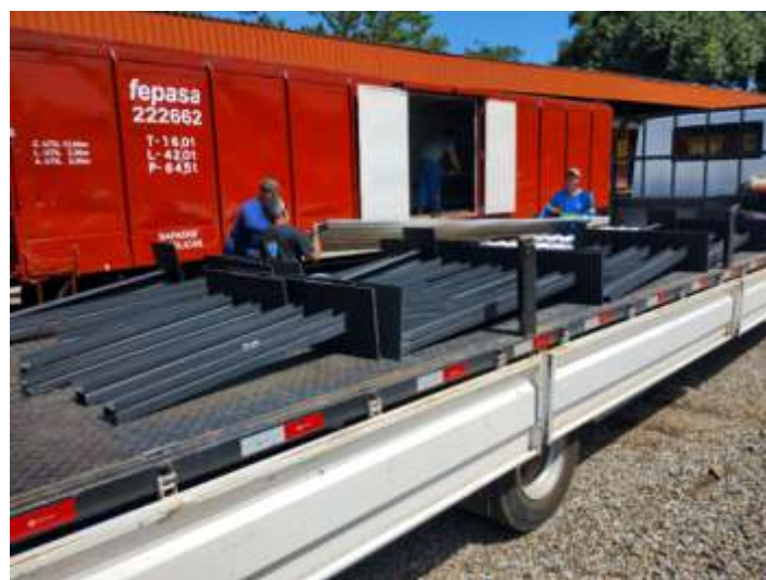
◆ Chumbadores (bases) do novo barracão sendo guardados no vagão. Foto HGF.
