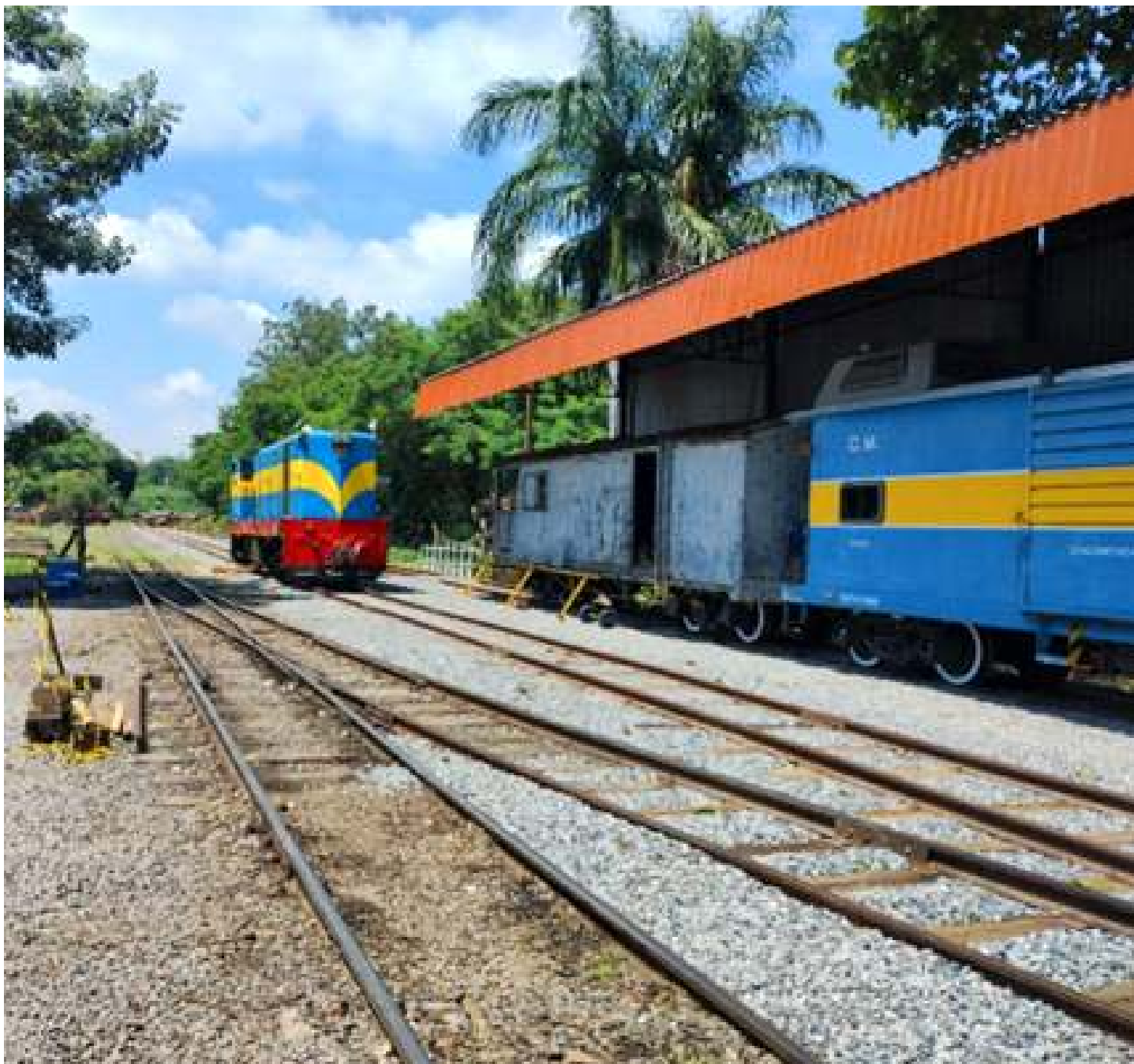
◆ Locomotiva testando nova linha após conclusão do AMV. Foto HGF
