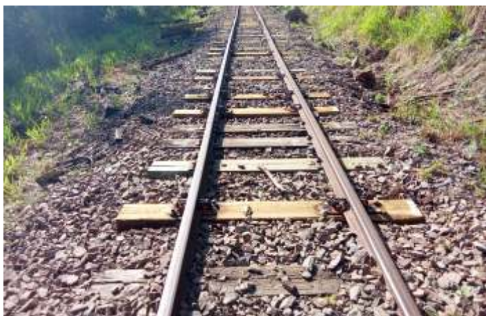
♦ Troca de dormentes no trecho do Trem das Termas.
