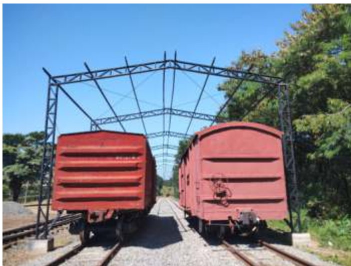
◆ Vagões sendo usados na obra. Foto de Eric Gazetta.
