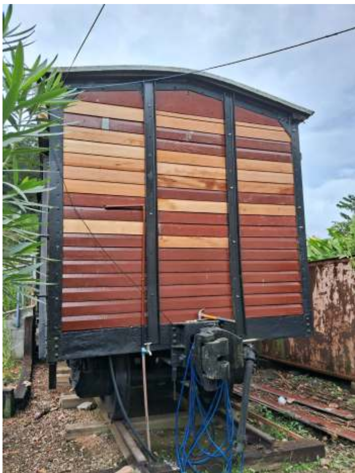
◆ O coordenador Otávio Georg Junior e o associado Jarbas Guazzelli, restaurando a cabeceira do vagon bilheteria, última etapa do trabalho. Autoria de Ângela Marques.
