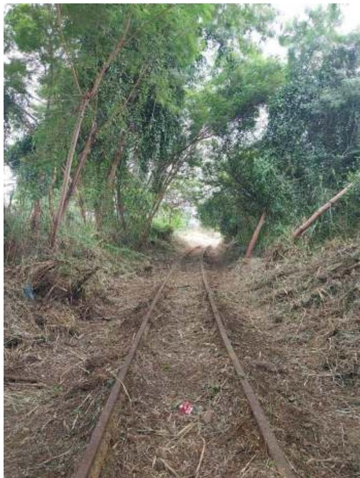
◆ *Trabalhos de limpeza da via entre os km4 e 5. A próxima etapa é a substituição de todos os dormentes.*
