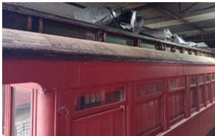
◆ Telhado do carro Administrativo AD-09 “GETÚLIO VARGAS” já sem a manta asfáltica e acabamento do clerestório.
