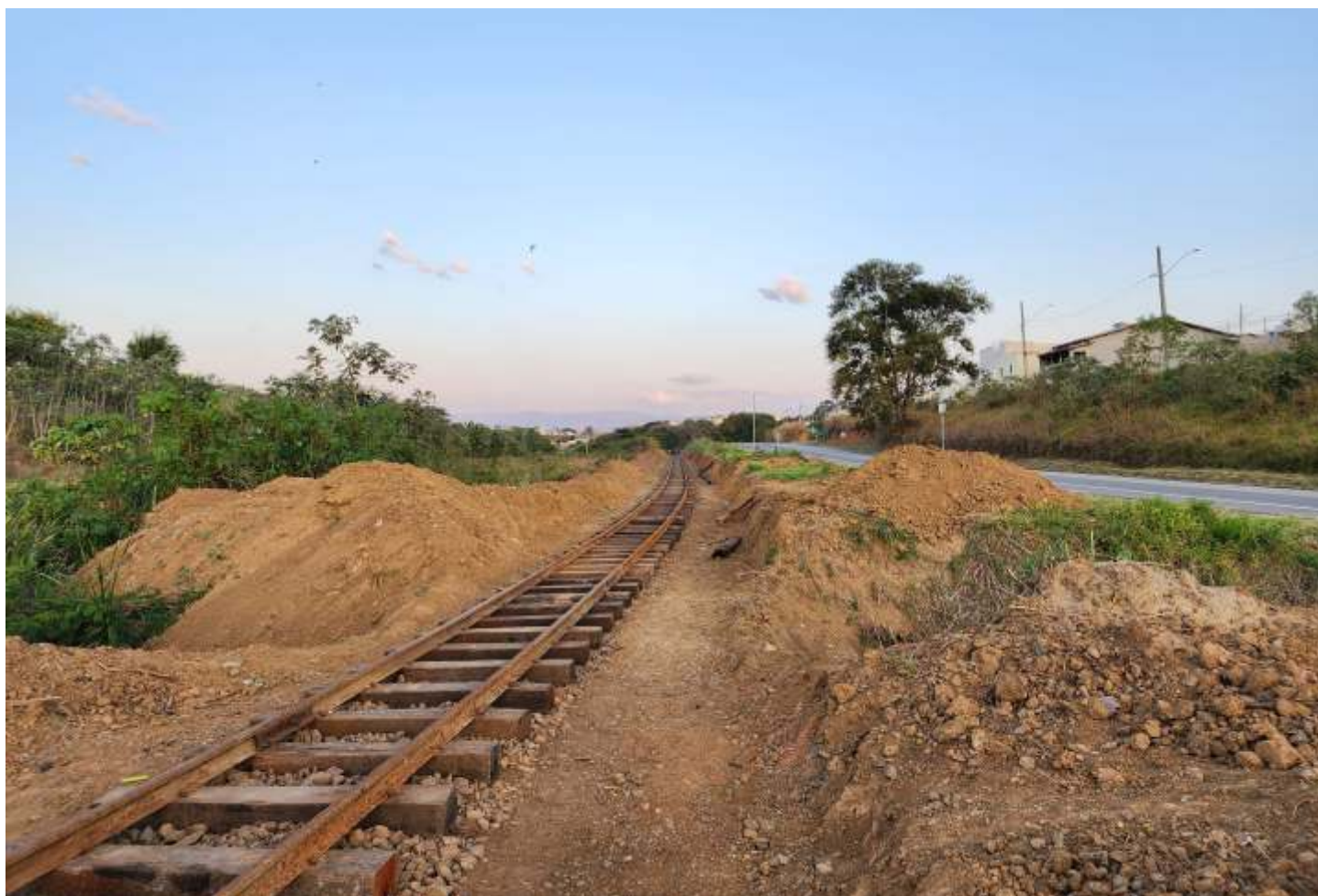
♦ Aspectos do antes e depois dos trabalhos de recuperação no km 4+900 da ferrovia.
