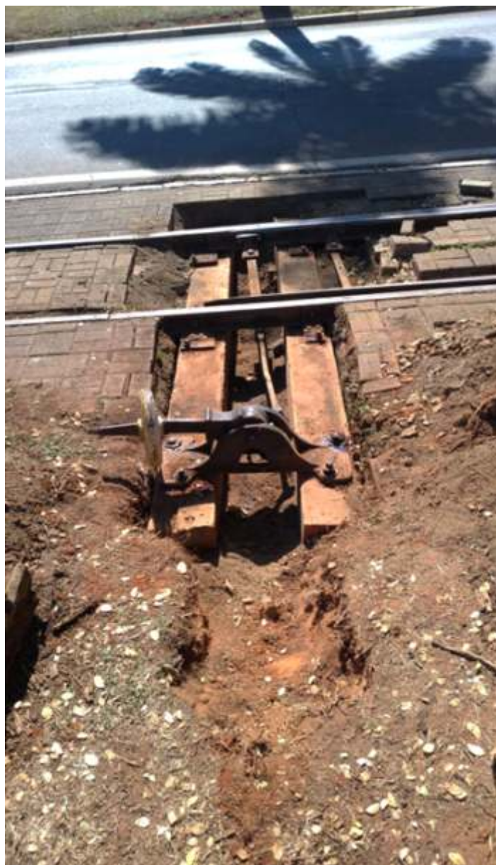
◆ Chave do final da linha em Jaguariuna sendo reparada. Foto de Edvaldo Silva.
