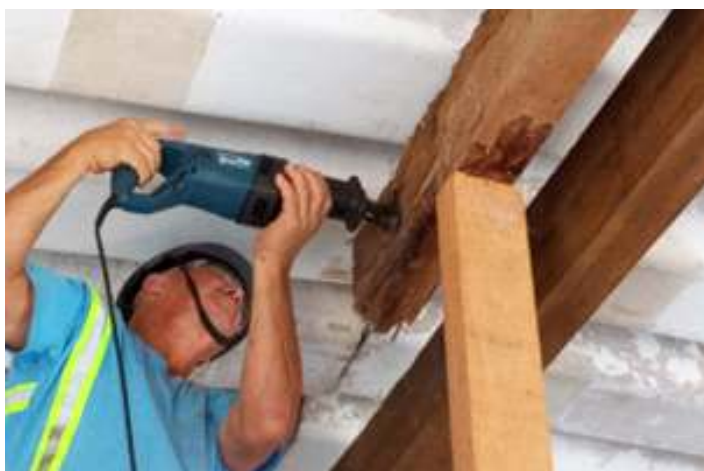
♦ Etapa de preparo da viga existente para a instalação da nova.
