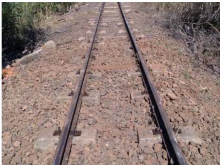
◆ Aplicação de dormentes de concreto. Foto Edvaldo Silva.
