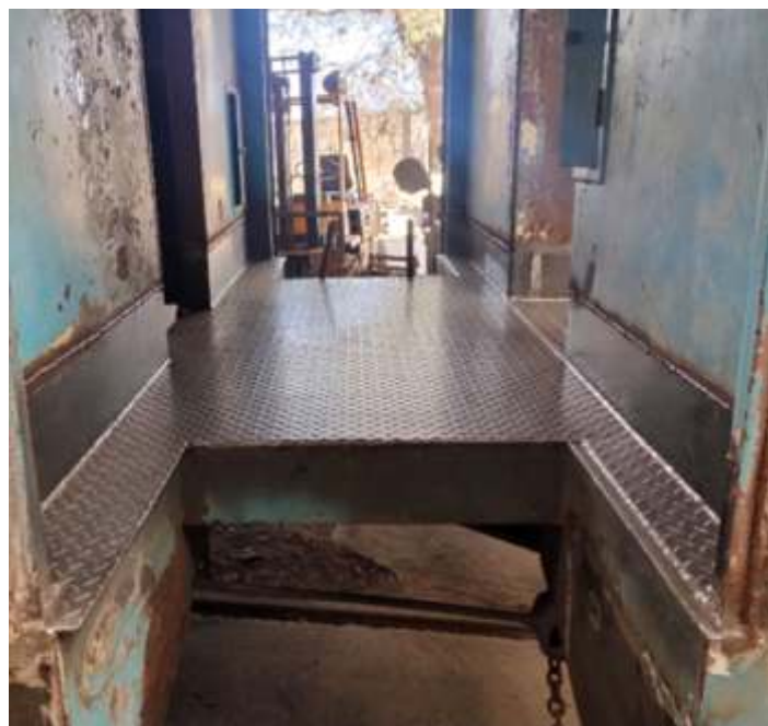
◆ Após serviços estrutural e pintura, foi instalado novo assoalho. Foto HGF.
