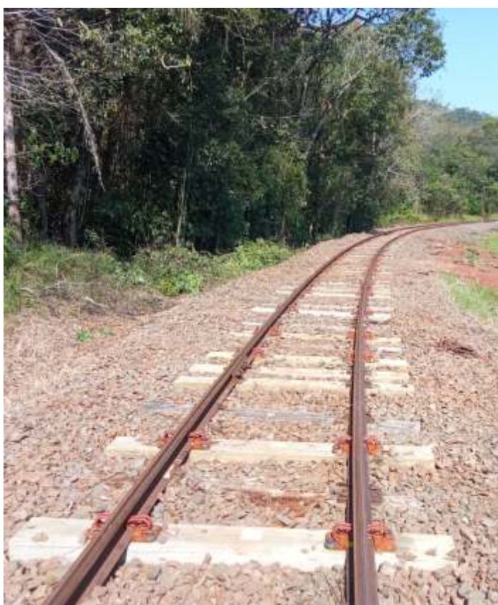
♦ Trabalhos de manutenção da via permanente.
