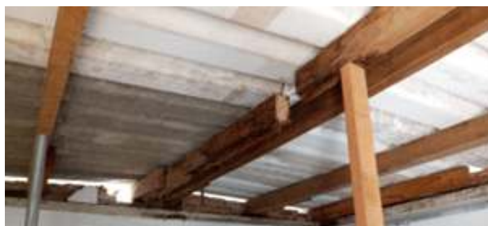
♦ Etapa de instalação da nova viga de madeira.
