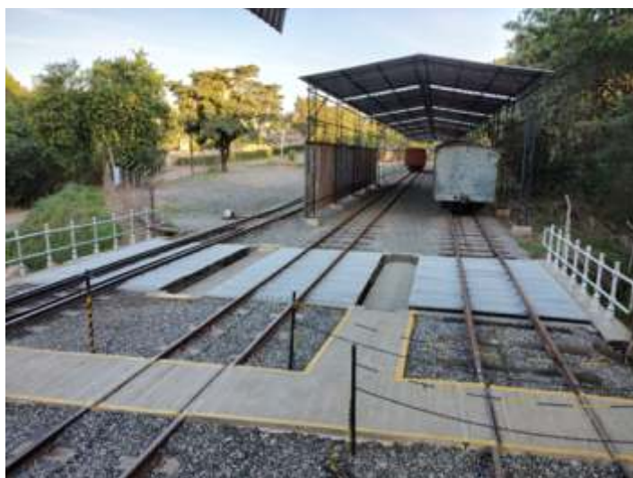
◆ Pontilhões com a instalação de tela de proteção. Foto Hélio Gazetta.
