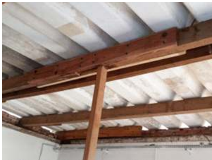
♦ Etapa de instalação da nova viga de madeira.
