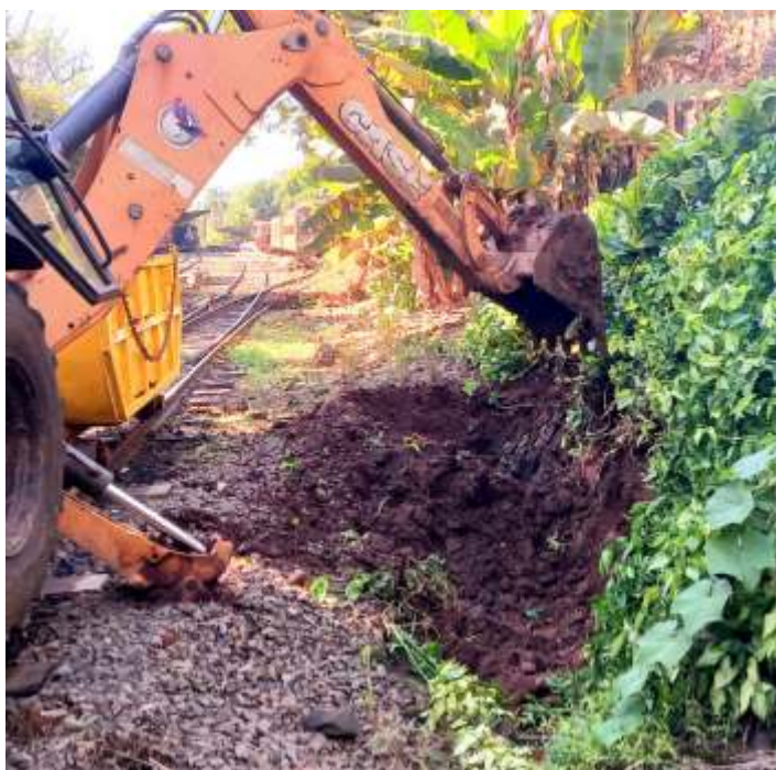
♦ Trabalhos de manutenção da via permanente.
