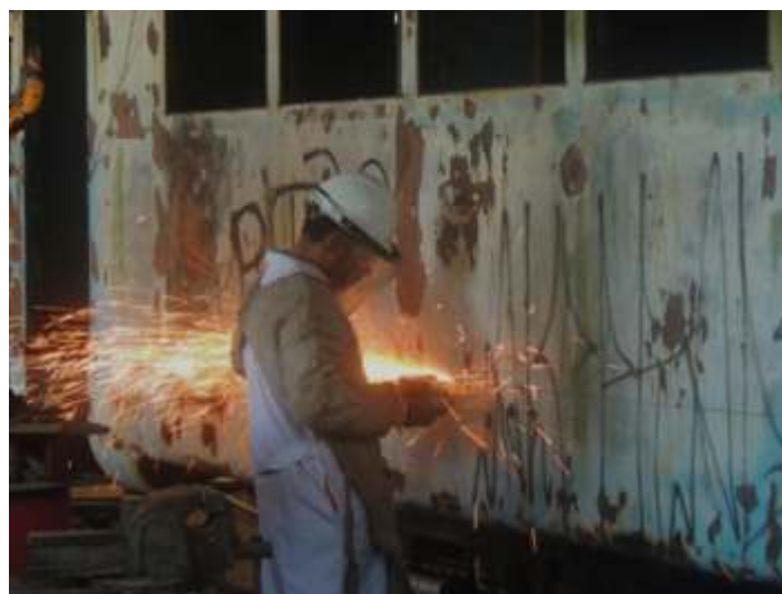
◆ Cortando parte da chaparia deteriorada. Foto de HGF.
