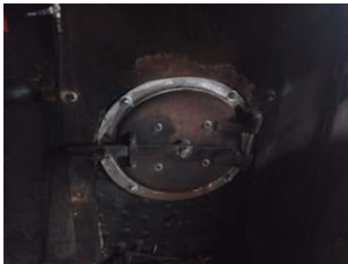
◆ Nova porta da fornalha da locomotiva Mikado #761 já instalada.
