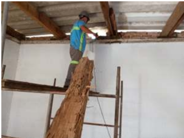
♦ Etapa de instalação da nova viga de madeira.
