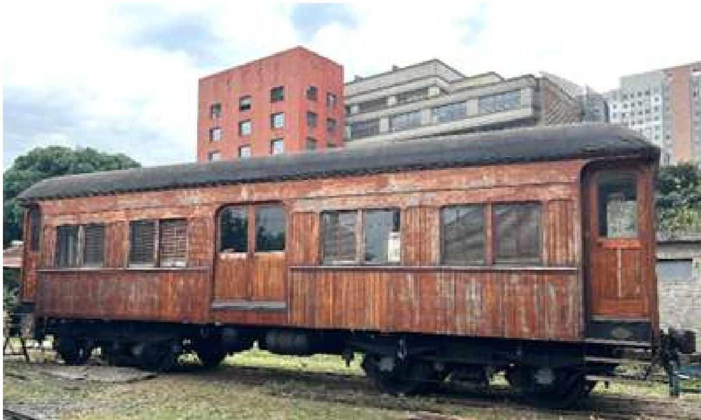
◆ Aspecto do carro 19 antes da intervenção.
