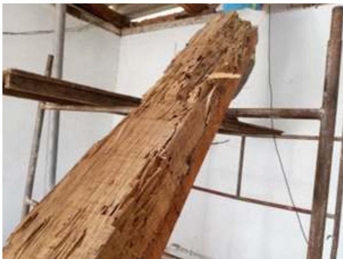
♦ Retirada da viga comprometida.
