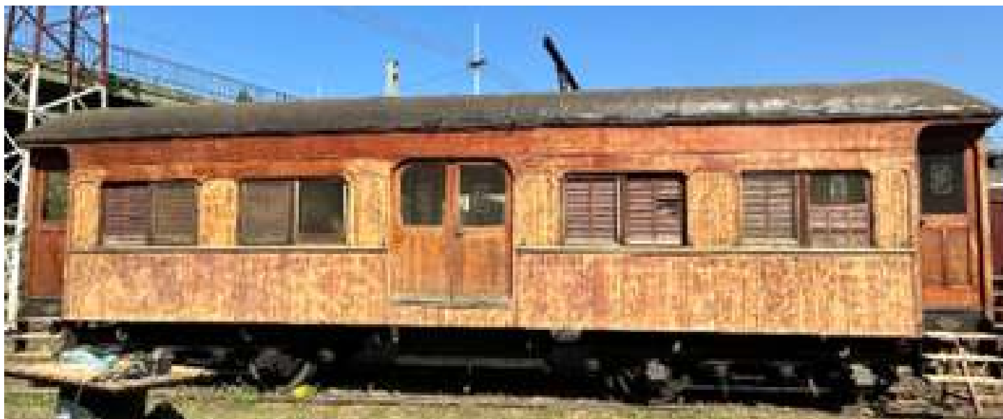
◆ Carro 19 sendo preparado com o lixamento da caixa de madeira para receber a nova aplicação de verniz.
