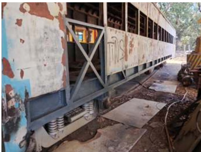
◆ Estrutura já reparada e pintada para início do fechamento. Foto HGF.
