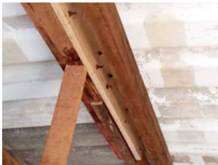
♦ Viga nova já instalada no local.
