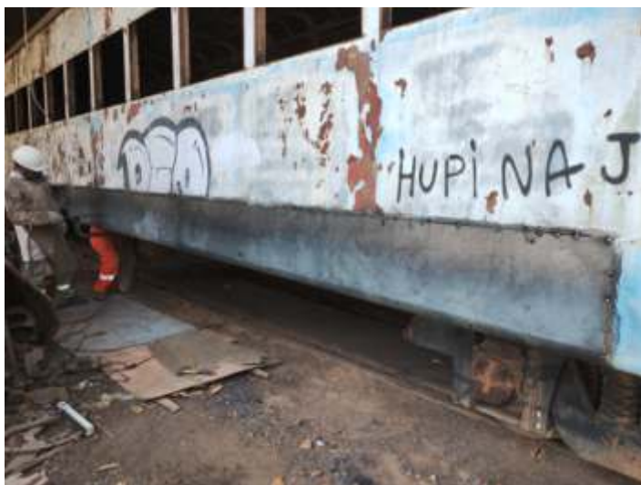
◆ Instalação das novas chapas de aço dobradas. Foto de HGF.
