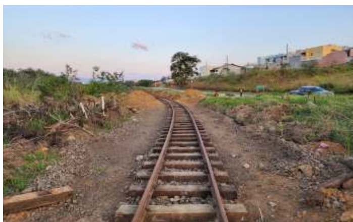
◆ Aspectos do antes e depois dos trabalhos no km 4+900.
