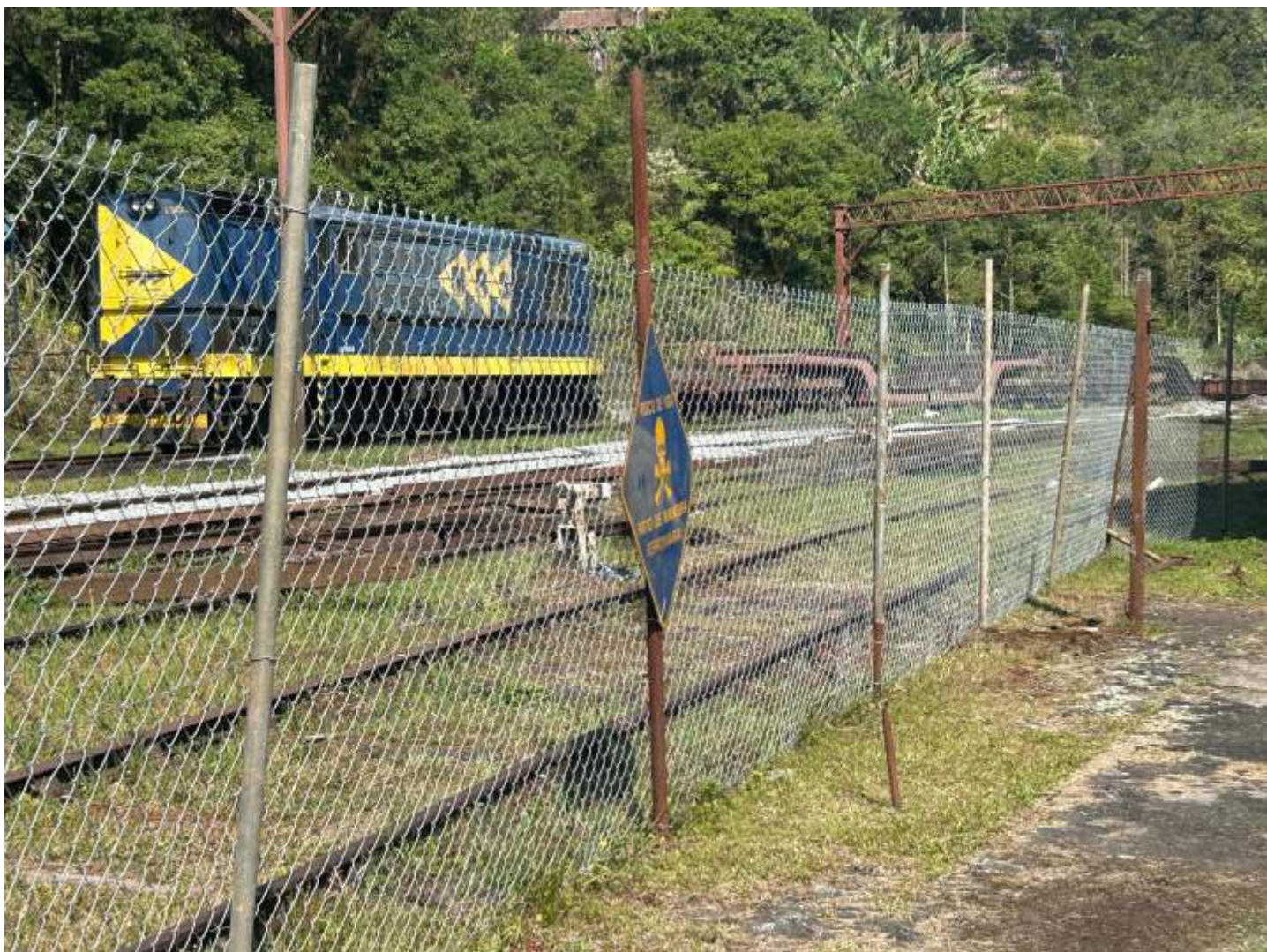
◆ Aspectos da nova grade de vedação instalada pela MRS no pátio de Paranapiacaba. Fotos: Alexandre Pisciotano.
