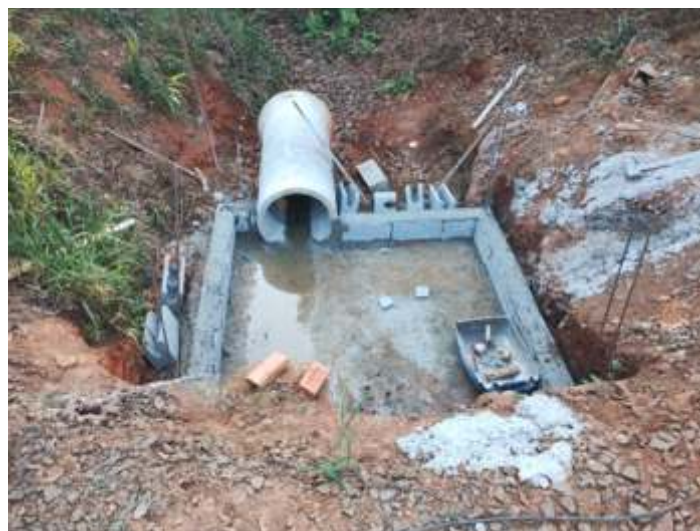
◆ Início de uma caixa onde chegam dois tubos e sai em um só. Foto HGF.
