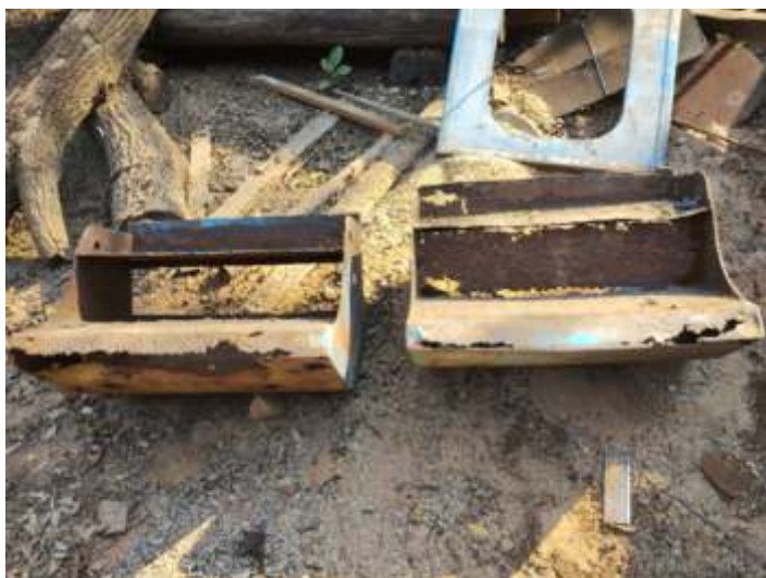
◆ Estado que estavam os degraus da varanda. Foto HGF
