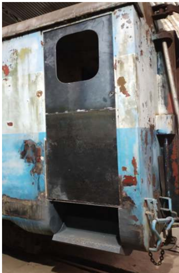
◆ Detalhe das novas portas e novos degraus. Foto HGF.
