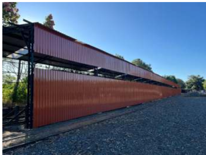
◆ Lateral da cobertura, restando somente a instalação das venezianas. Foto Eric Gazetta.
