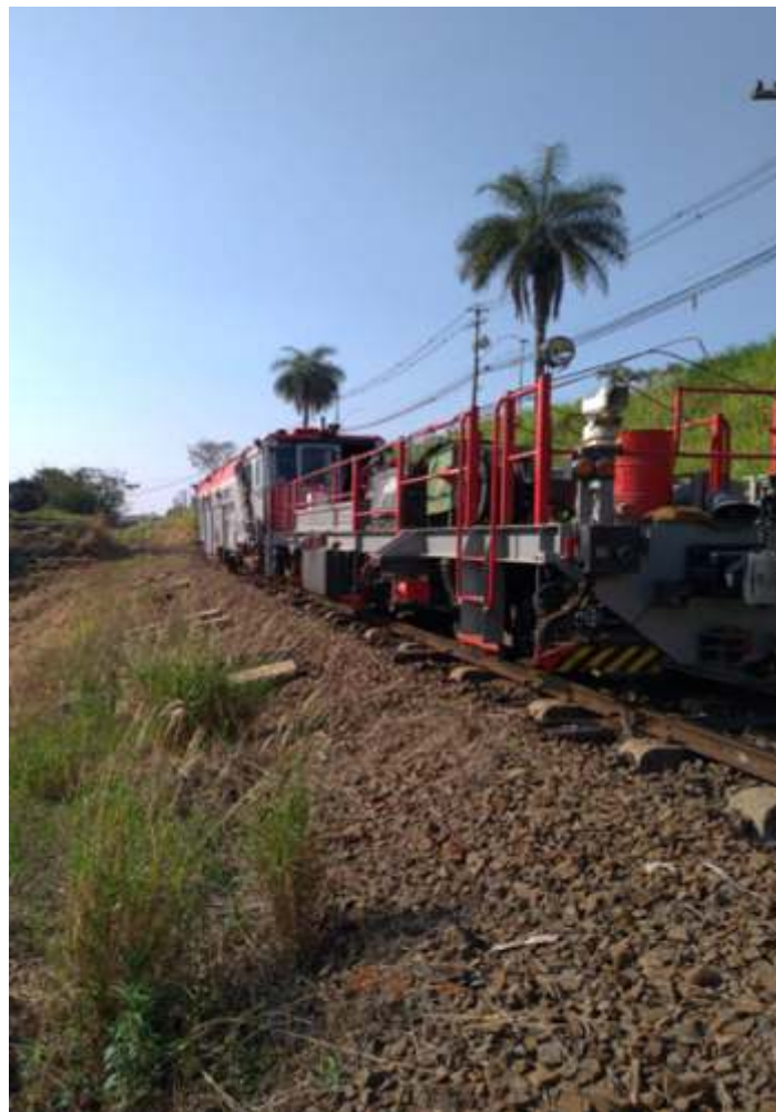
◆ Niveladora Plasser operando no KM 9,5. Foto Wenif dos Santos.
