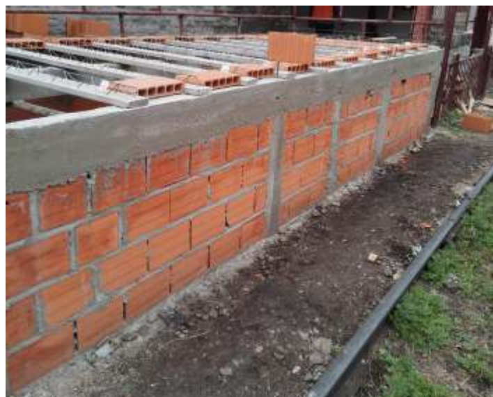
◆ Etapas da construção da nova plataforma em alvenaria. Fotos: Alexandre Pisciotano.
