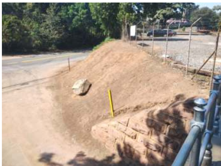
◆ Cabeceira da ponte sendo preparada para receber gramado. Foto HGF.
