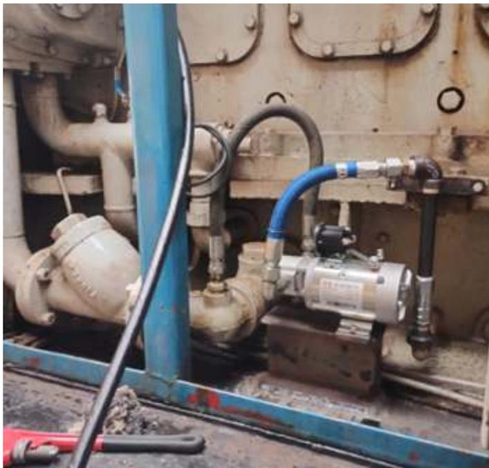
◆ Bomba elétrica hidráulica para pré lubrificação do motor. Foto HGF.
