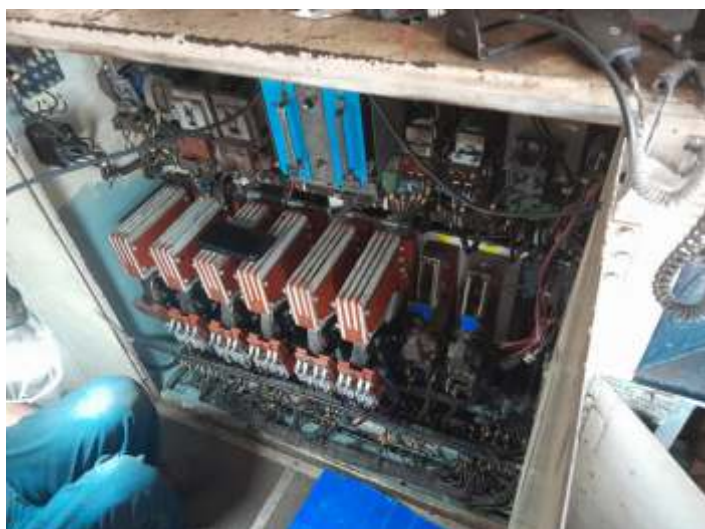
♦ Revisão de toda a parte elétrica da 3111.
