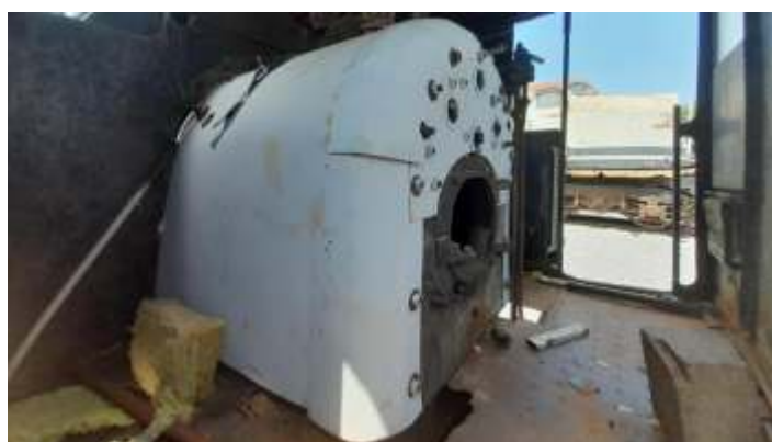
◆ Nova chaparia sendo instalada na locomotiva nº2.
