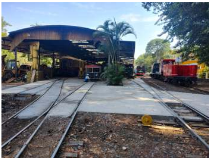
◆ Entrada das oficinas com as linhas e a PN concretadas. Foto HGF.
