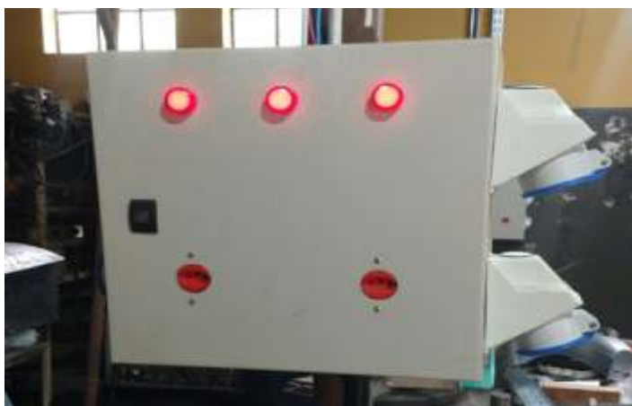
◆ Detalhe novo painéis na oficina. Foto Cristiano Belarmino.
