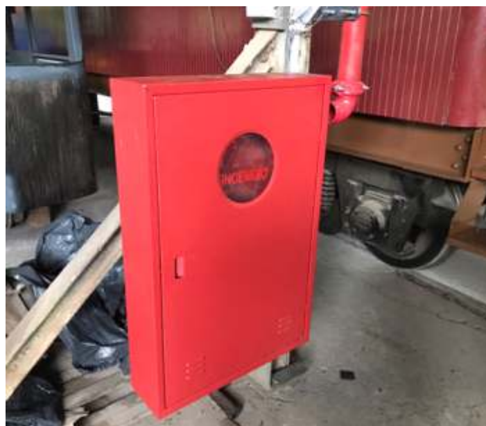
◆ Um dos sete hidrantes instalados em Carlos Gomes. Foto Paulo Deodato.
