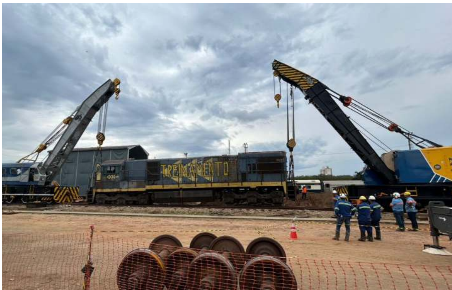
◆ Içamento da locomotiva 3265 durante o simulado para recolocação nos trilhos com utilização de dois guindastes ferroviários Orton, um da MRS e um da Rumo, esse último tracionado por locomotiva da ABPF. Foto Paulo Lima.
