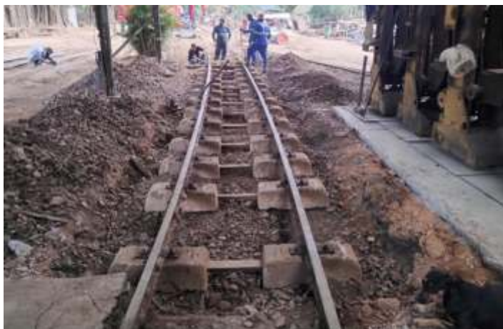
◆ Preparação da linha da oficina para receber nova concretagem. Foto HGF.
