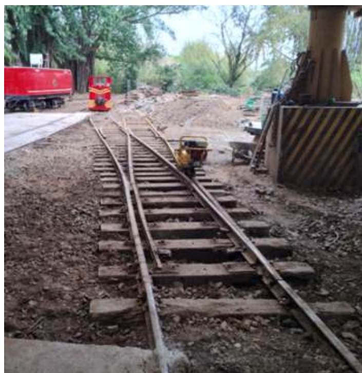
♦ Novo AMV instalado nas oficinas de Carlos Gomes, para em breve estender novo desvio para vagões. Foto HGF.
